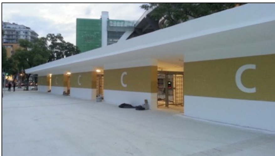
Figura 19: Foto do Portão C do Maracanã (Setor Sul)
