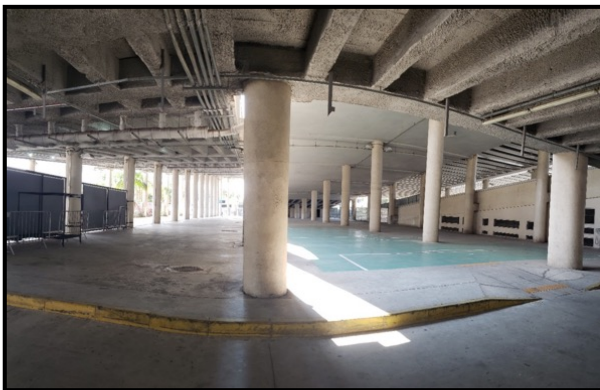
Figura 39: Visão interna da Praça de Acesso com 1.150 m 2 .
