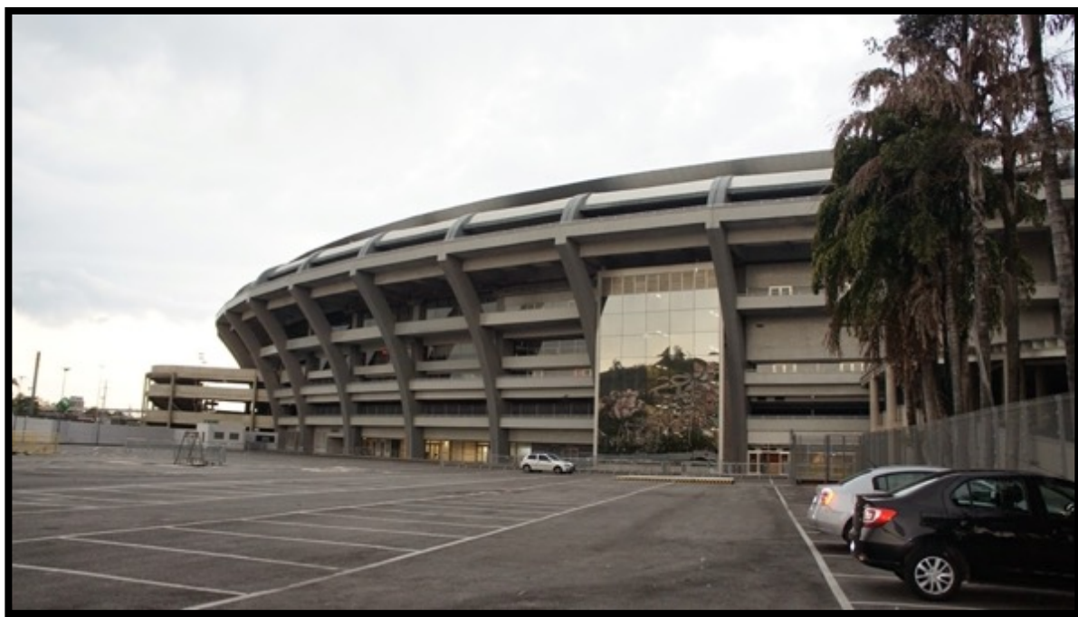
Figura 41: Visão Geral do Estacionamento P2.
