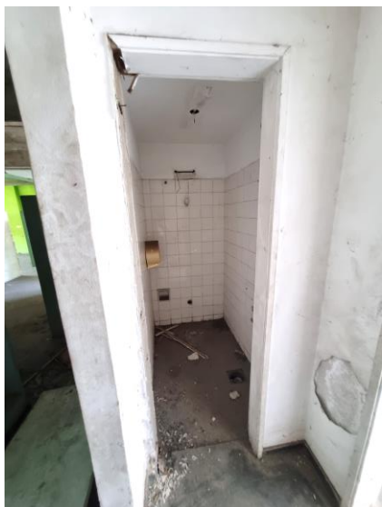
89 – Interior de um dos banheiros do 1º pavimento
