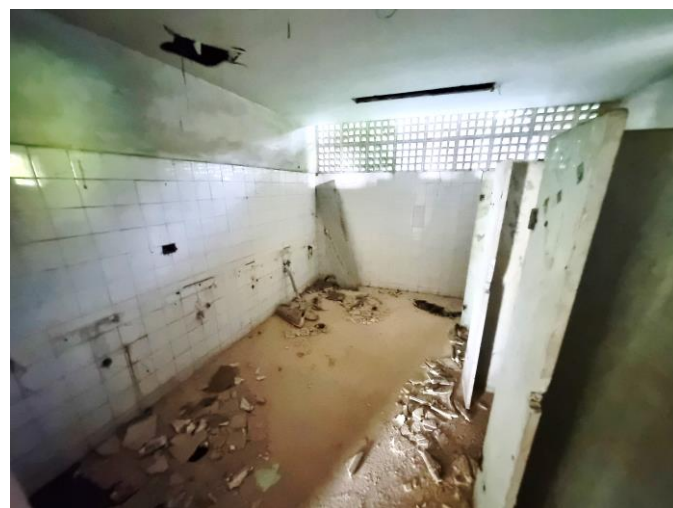
44 – Interior do banheiro feminino
