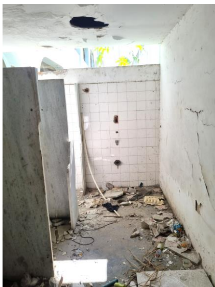
55 – Banheiro localizado na área da cozinha
