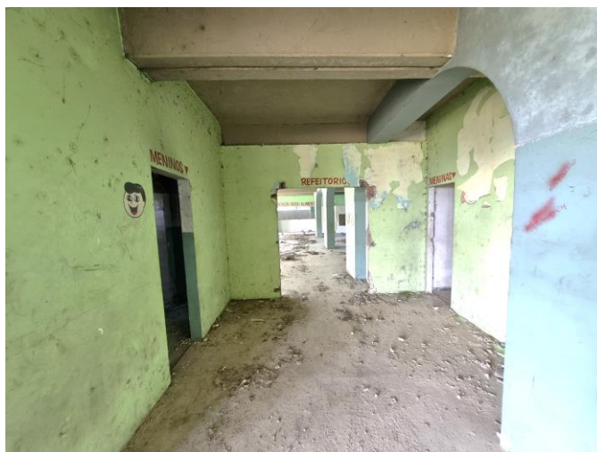
40 – Térreo da Edificação Principal Lateral esquerda – Acesso aos banheiros, Refeitório e cozinha
