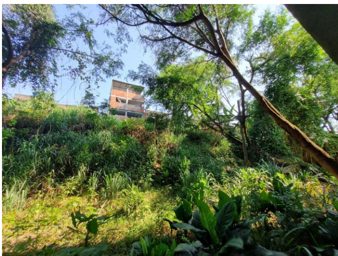
63 – Fundos da Edificação Principal
