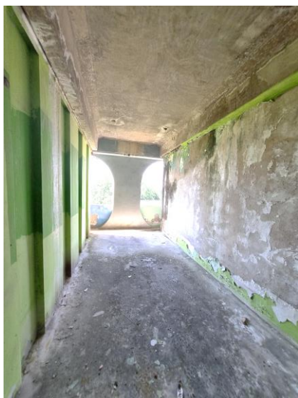
103 – Sala do 2º primeiro pavimento
