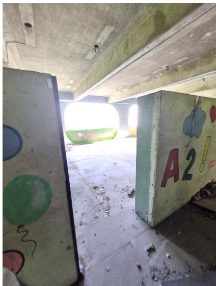
93 – Acesso a umas das salas do 1º pavimento
