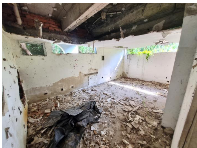
67 – Cômodo à esquerda do hall da FOTO 66
