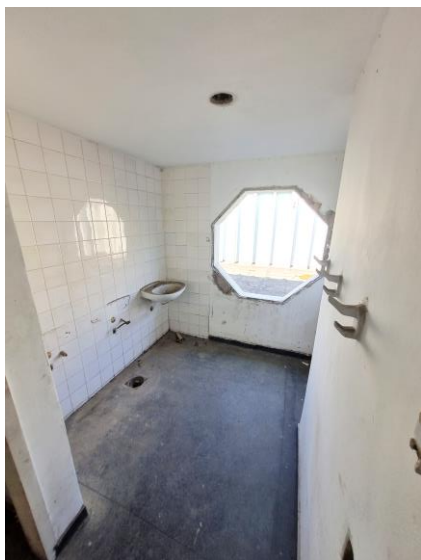
121 – Interior do banheiro do final do corredor da FOTO 108
