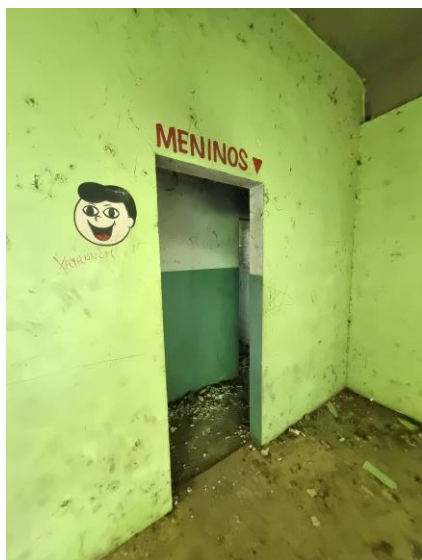
41 – Acesso ao banheiro Masculino
