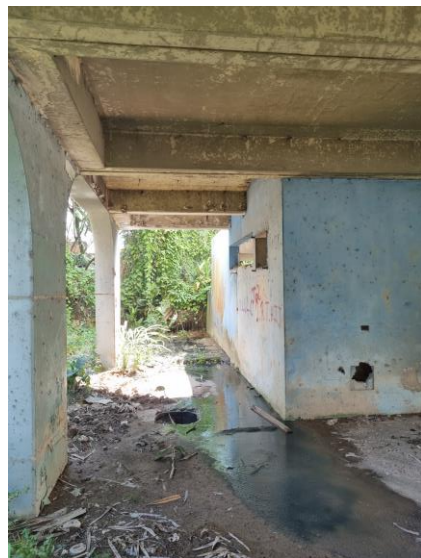
64 – Térreo da Edificação Principal Lateral direita
