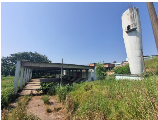
38 – Vista da quadra e da caixa d'água pela escada da FOTO 37
