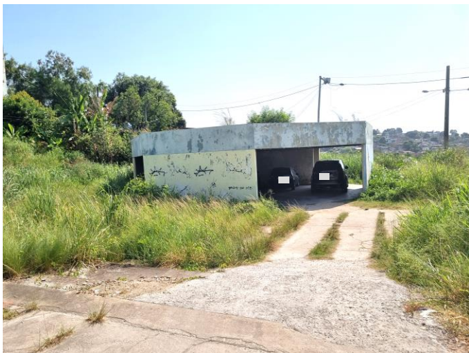
05 – Acesso da edificação onde funcionava a biblioteca
