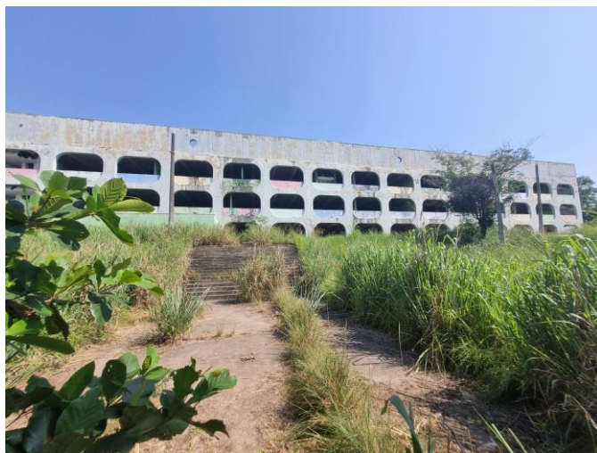
36 – Acesso à escada ao lado da quadra que dá acesso à área da edificação principal
