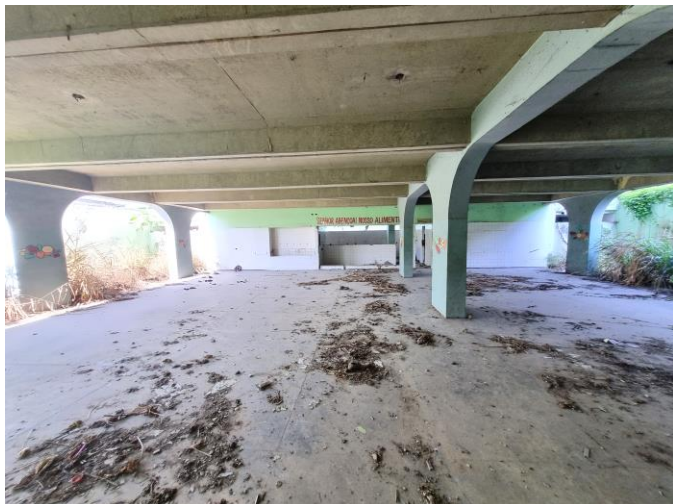
45 – Área do Refeitório
