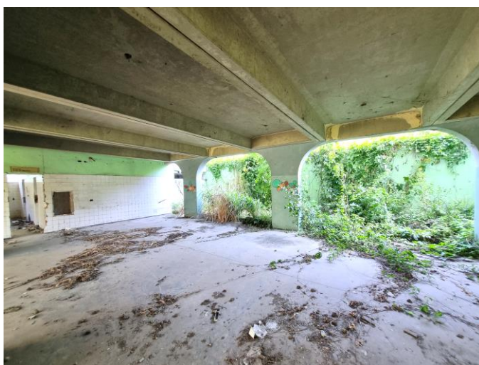
47 – Área do Refeitório – lateral direita
