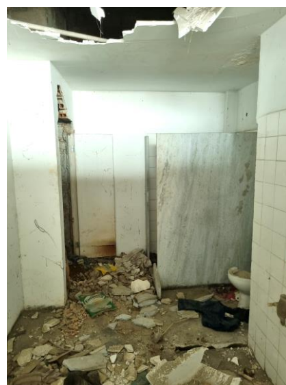
56 – Banheiro localizado na área da cozinha
