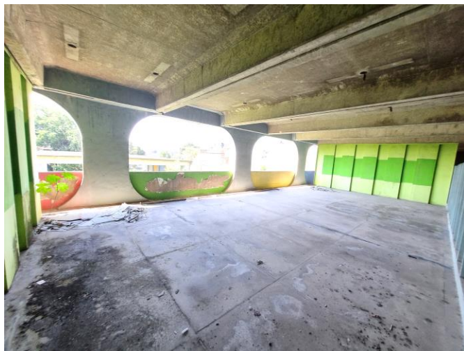
94 – Sala do 1º primeiro pavimento
