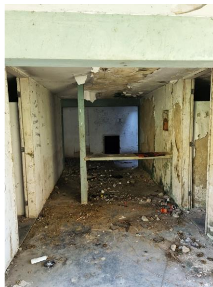
20 – Corredor central da área dos vestiários
