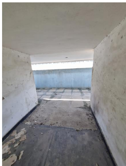
111 – Corredor no patamar do 3º pavimento
