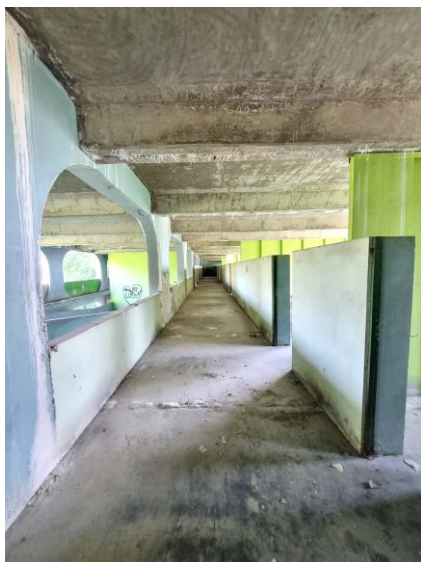
101 – Acesso aos cômodos localizados nos corredores dos fundos do imóvel
