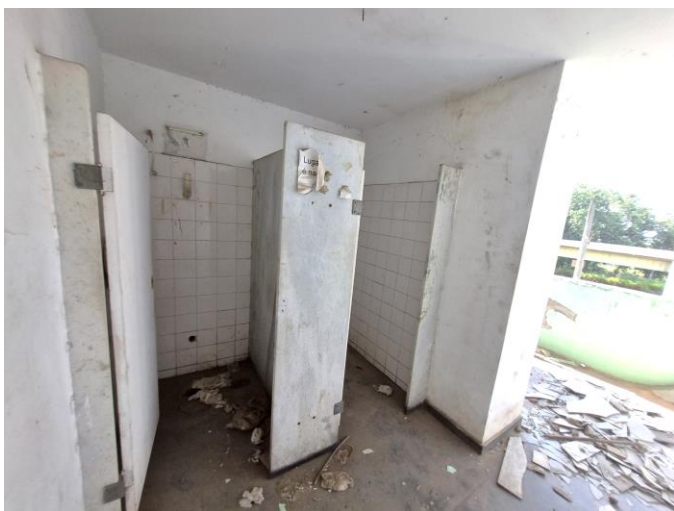
91 – Interior de um dos banheiros do 1º pavimento
