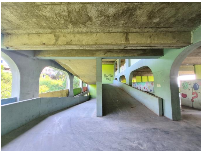
97 – Rampa de acesso ao 2º pavimento
