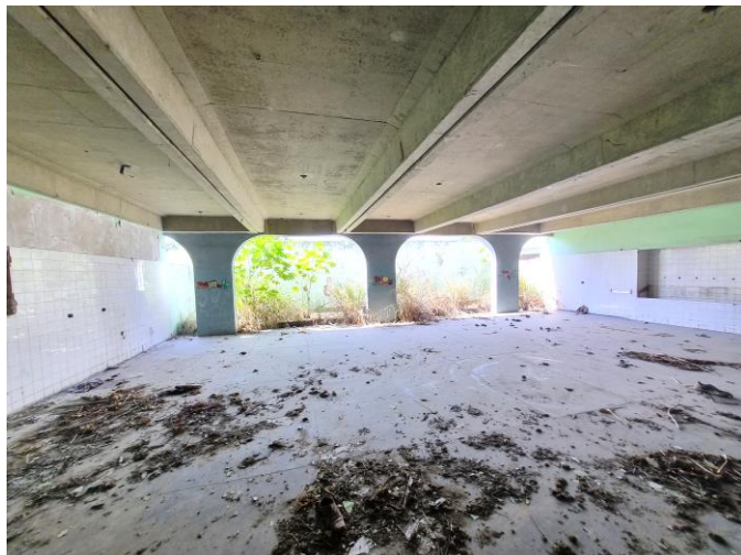
46 – Área do Refeitório – lateral esquerda
