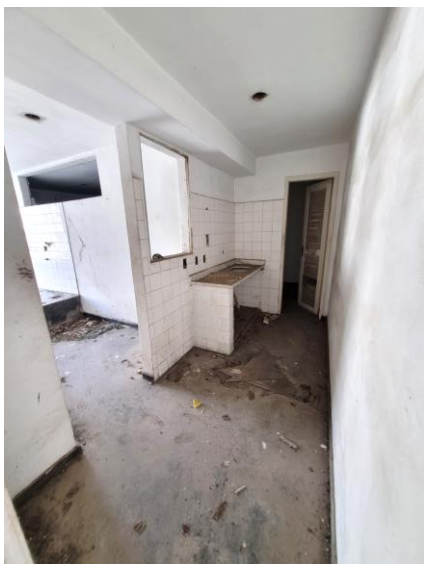
123 – Cozinha acessada pelo corredor da FOTO 114
