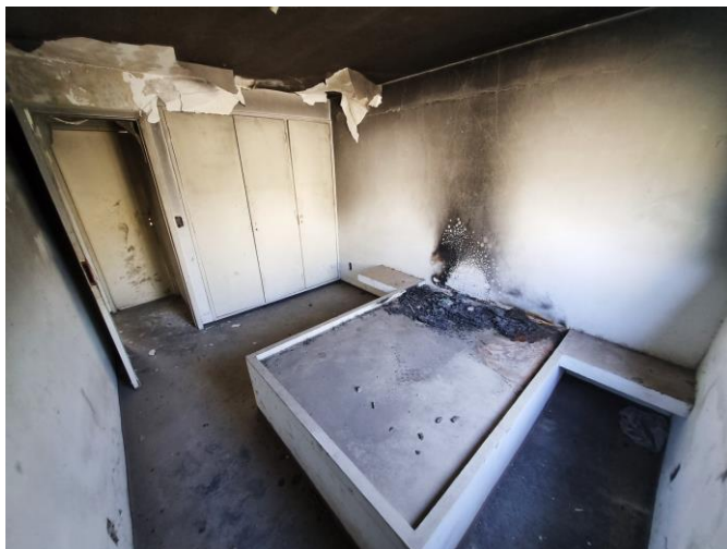
126 – Interior de 1 dos 2 quartos acessados pelo corredor da FOTO 114
