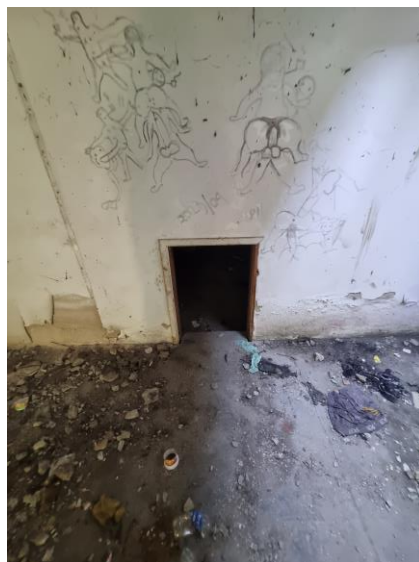
30 – Boca de visita para o interior da arquibancada da quadra
