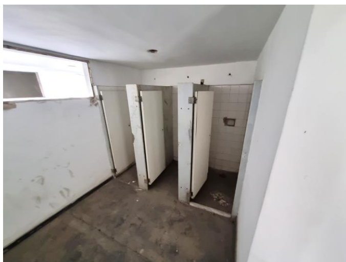
120 – Interior do banheiro do final do corredor da FOTO 108
