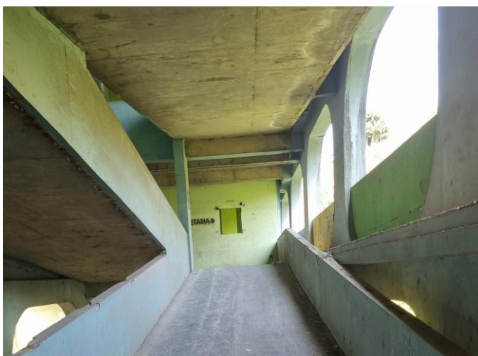
79 – Rampa de acesso ao 1º pavimento Segundo lance
