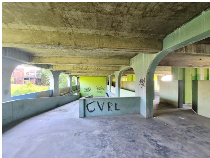
98 – Patamar do 2º pavimento
