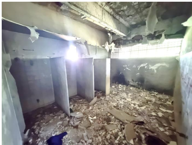
42 – Interior do banheiro masculino
