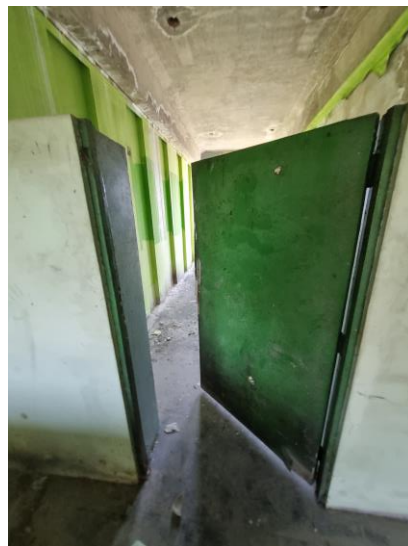
102 – Acesso a umas das salas do 2º pavimento
