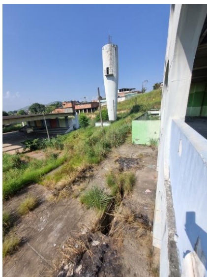
39 – Vista do patamar superior da escada no nível da edificação principal
