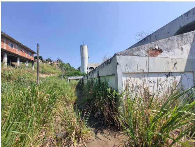
17 – Corredor nos fundos da quadra que dá acesso aos vestiários
