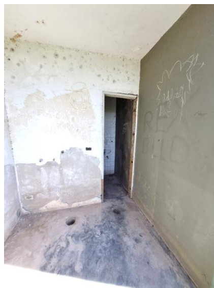
08 – Banheiro localizado na edificação onde funcionava a biblioteca
