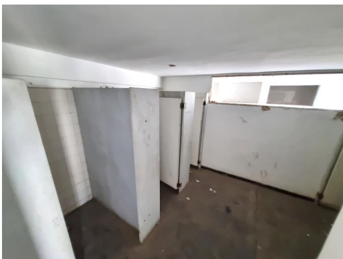
119 – Interior do banheiro do final do corredor da FOTO 108
