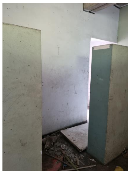
88 – Acesso a um dos banheiros do 1º pavimento
