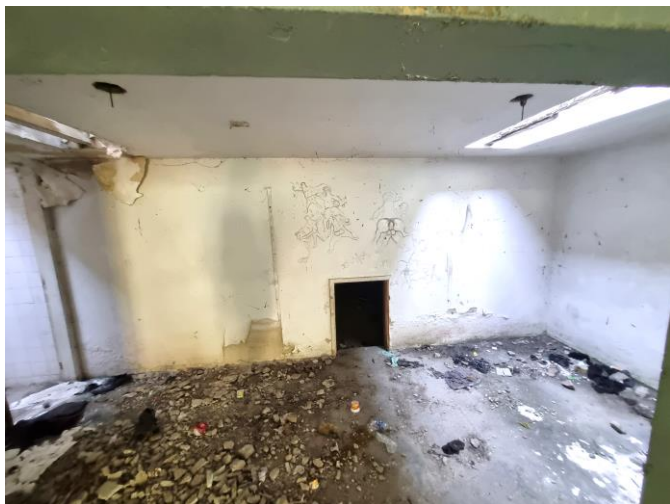
29 – Área nos fundos do corredor central da área dos vestiários
