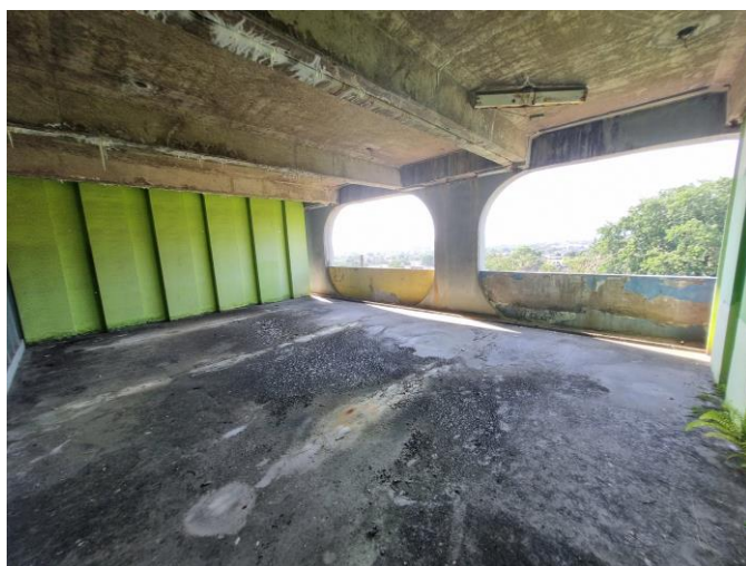
104 – Sala do 2º primeiro pavimento
