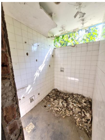
71 – Cômodo à direita do hall da FOTO 66
