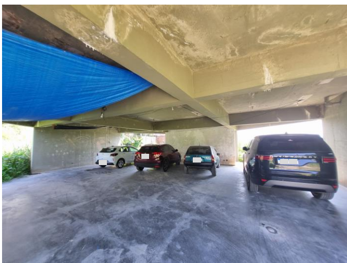
07 – Área interna da edificação onde funcionava a biblioteca
