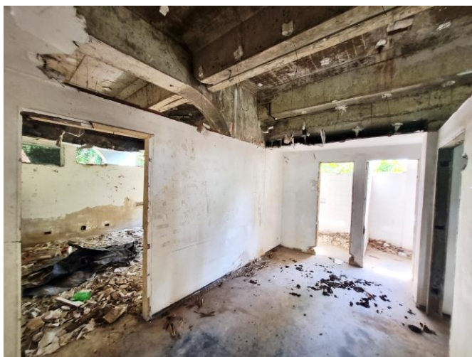
66 – Térreo da Edificação Principal Lateral direita – Hall de acesso aos cômodos
