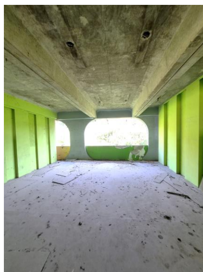
84 – Sala do 1º primeiro pavimento
