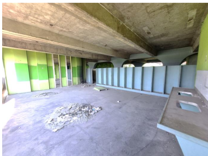
96 – Sala do 1º primeiro pavimento
