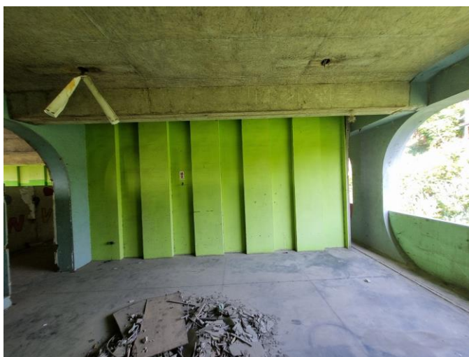
82 – Sala do 1º primeiro pavimento
