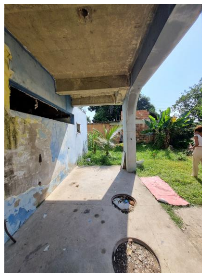
72 – Área externa na lateral direita dos cômodos da FOTO 65
