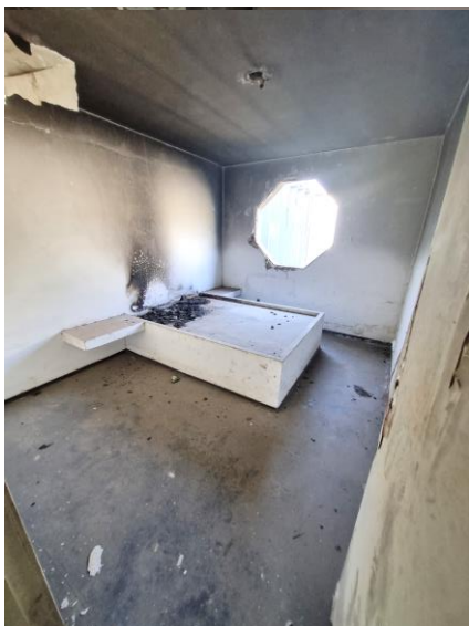
125 – Interior de 1 dos 2 quartos acessados pelo corredor da FOTO 114
