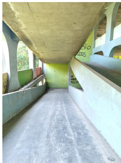
78 – Rampa de acesso ao 1º pavimento Segundo lance
