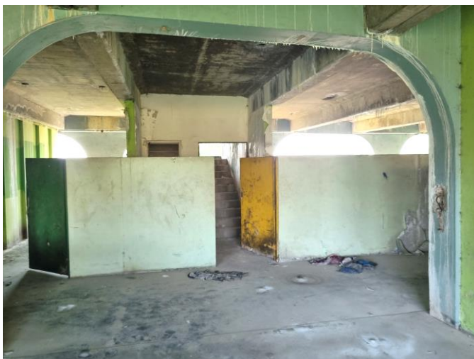
108 – Acesso ao 3º pavimento
