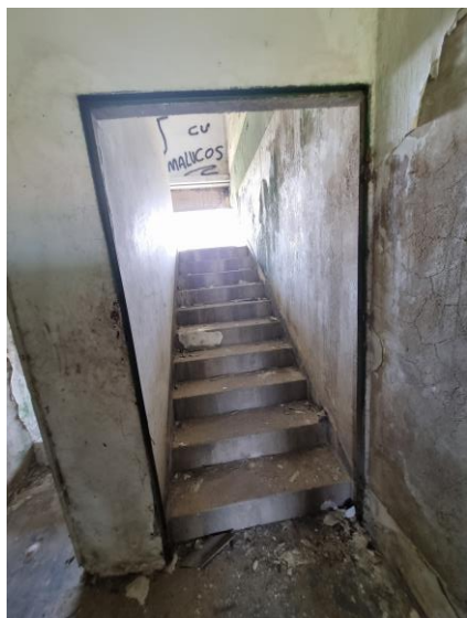
109 – Escada de acesso ao 3º pavimento
