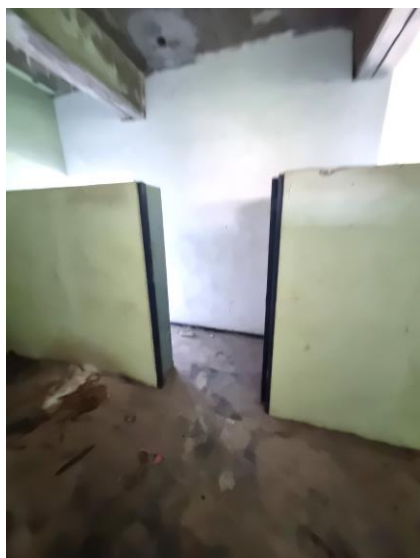
105 – Acesso a um dos banheiros do 2º pavimento
