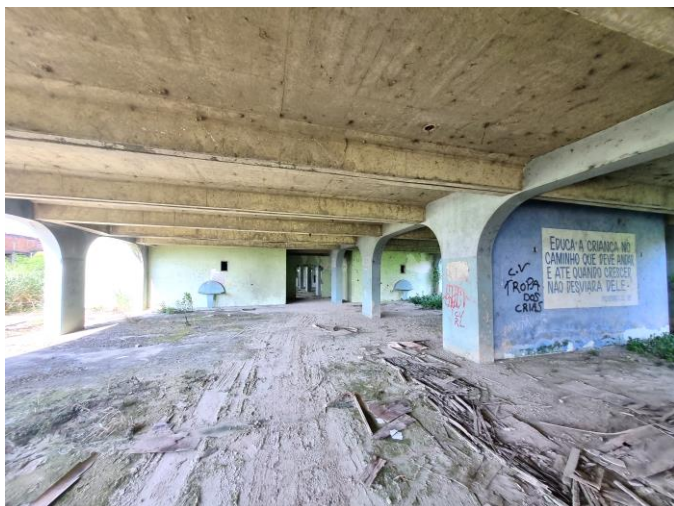
57 – Térreo da Edificação Principal Lateral esquerda
