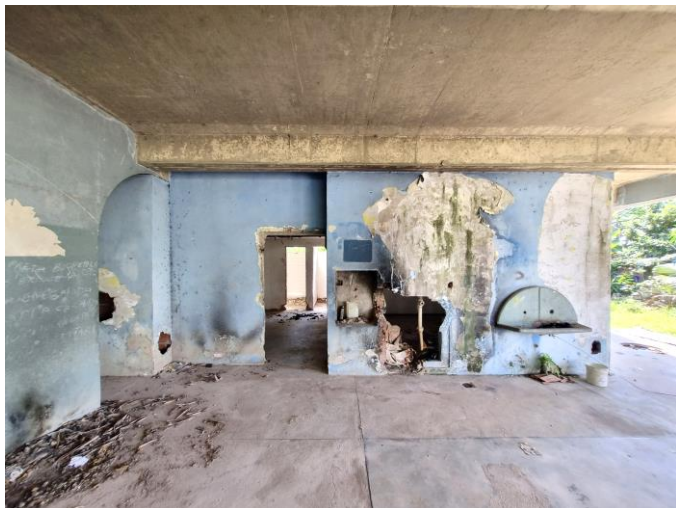
65 – Térreo da Edificação Principal Lateral direita – Acesso aos cômodos
