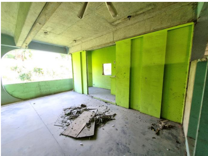
81 – Sala do 1º primeiro pavimento
