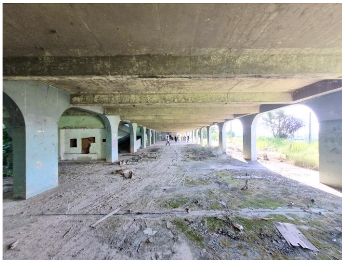
58 – Térreo da Edificação Principal Área de circulação central
