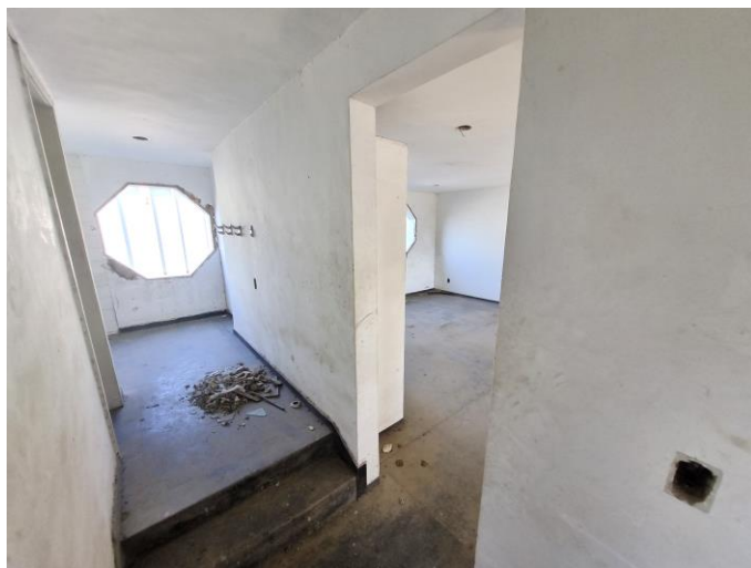
116 – Corredor de acesso aos cômodos do lado direito
