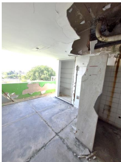
107 – Interior de um dos banheiros do 2º pavimento
