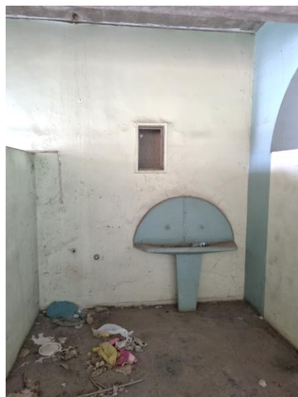
87 – Final do corredor central Lado direito
