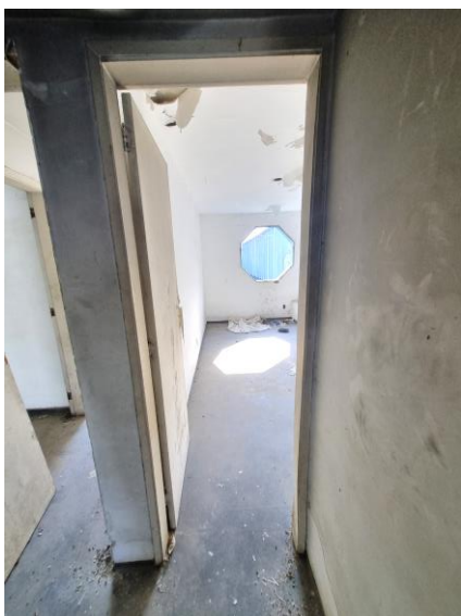
127 – Interior do segundo quarto acessado pelo corredor da FOTO 114
