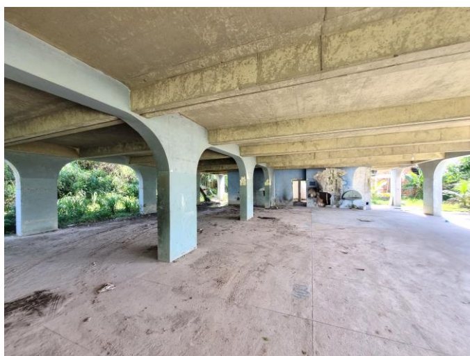
60 – Térreo da Edificação Principal Lateral direita
