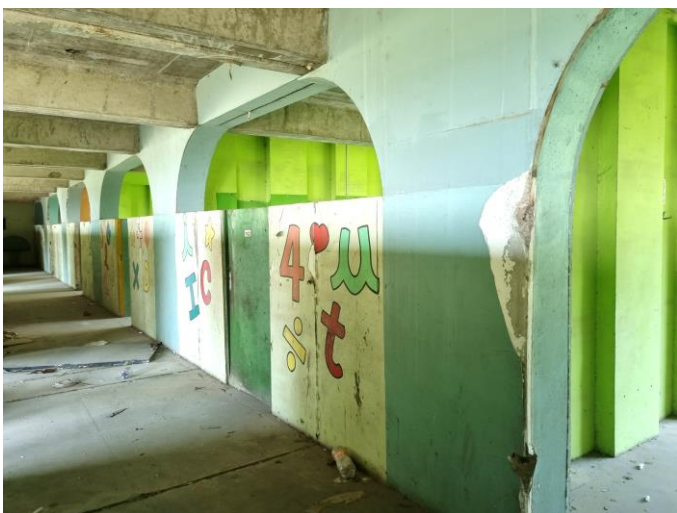
83 – Frente das sala do 1º primeiro pavimento
