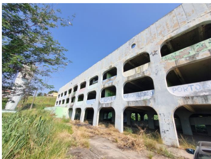
76 – Fachada da frente da Edificação principal Lateral esquerda
