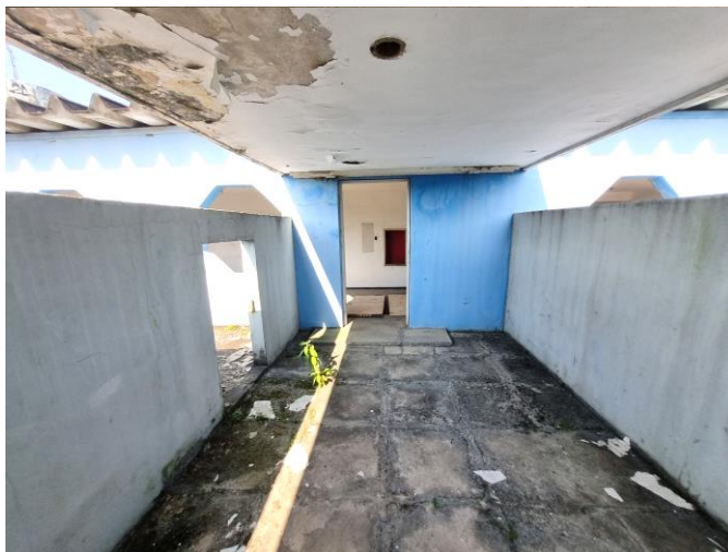
114 – Acesso às instalações tipo residencial do 3º pavimento Lateral esquerda
