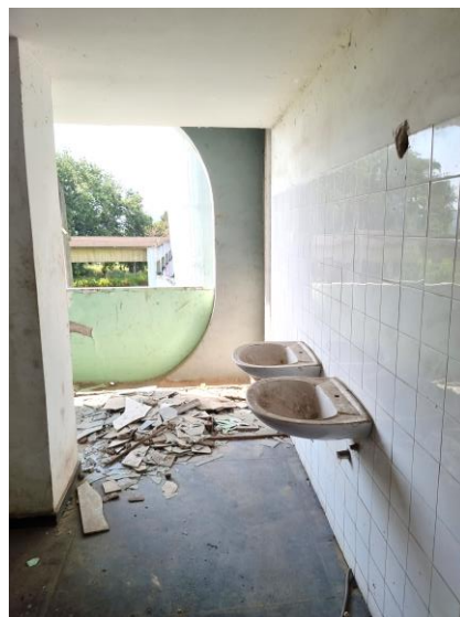
90 – Interior de um dos banheiros do 1º pavimento
