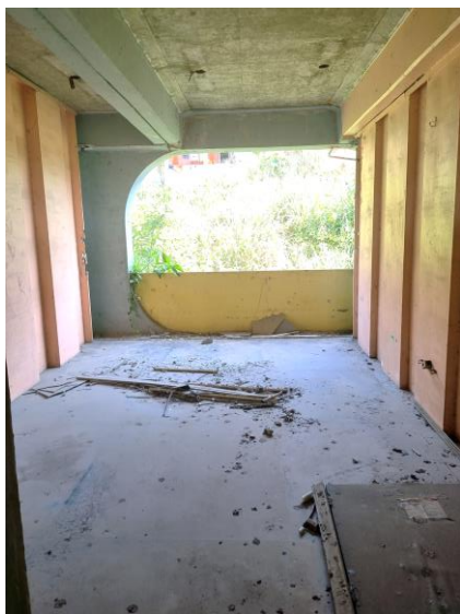
85 - Sala do 1º primeiro pavimento
