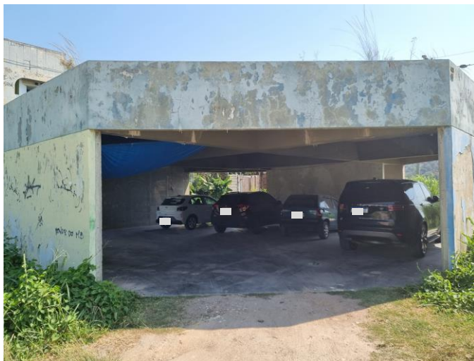
06 – Edificação onde funcionava a Biblioteca
