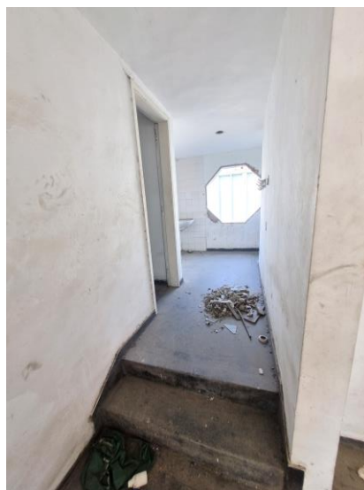
118 – Acesso ao banheiro no final do corredor da FOTO 108
