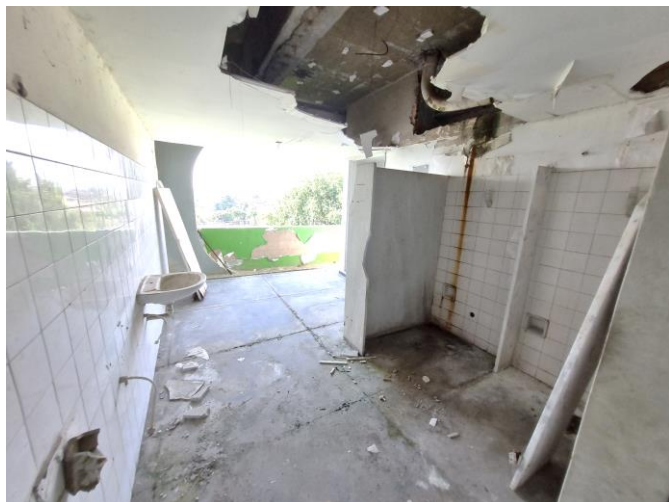
106 – Interior de um dos banheiros do 2º pavimento
