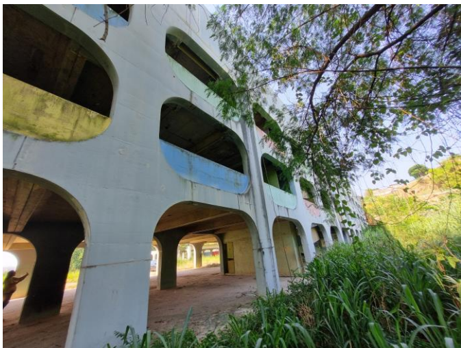
61 – Fachada dos fundos da Edificação Principal esquerda
