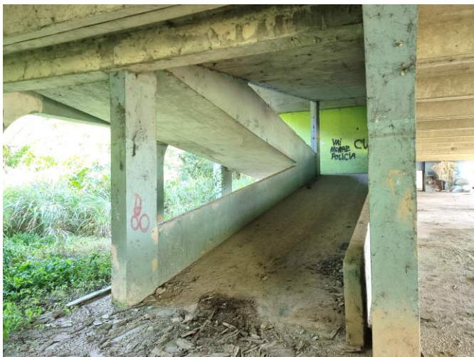
77 – Rampa de acesso ao 1º pavimento Primeiro lance
