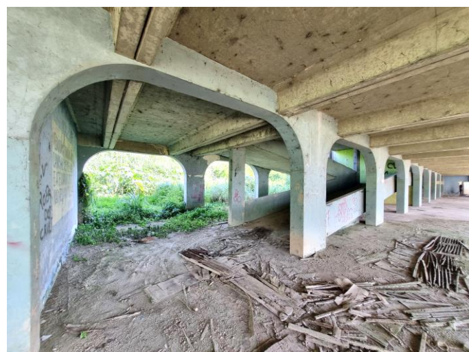
59 – Térreo da Edificação Principal Rampa de acesso ao pavimento superior
