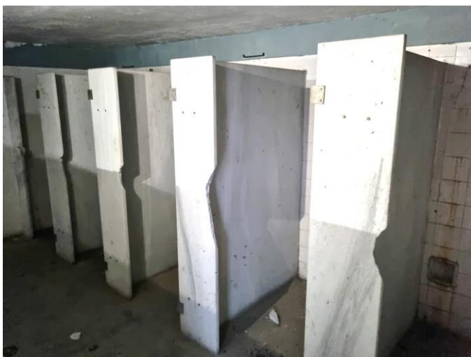
23 – Área dos sanitários do vestiário esquerdo
