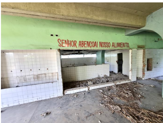
48 – Parte da frente da cozinha
