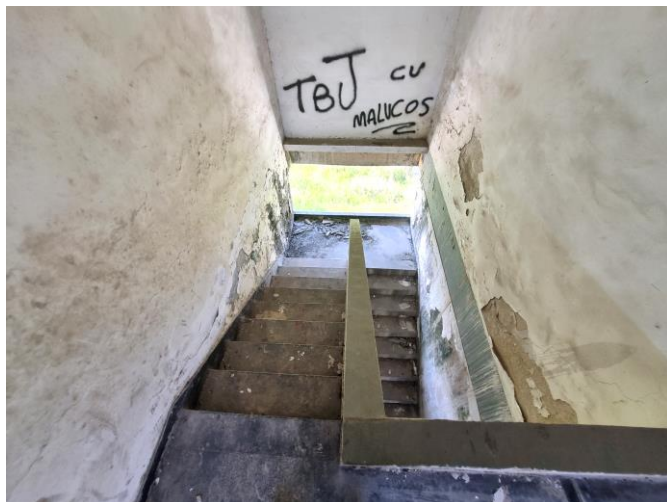
110 – Escada de acesso ao 3º pavimento
