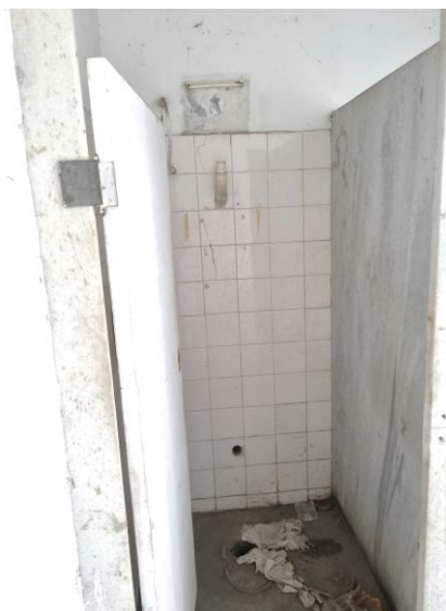
92 – Interior de um dos banheiros do 1º pavimento
