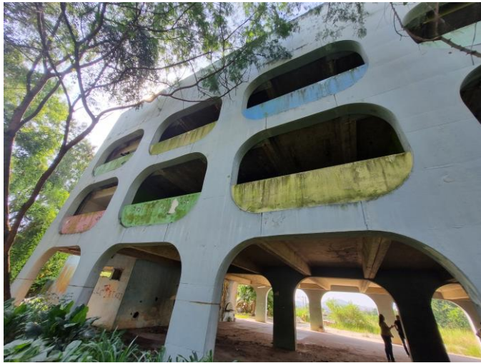
62 – Fachada dos fundos da Edificação Principal esquerda
