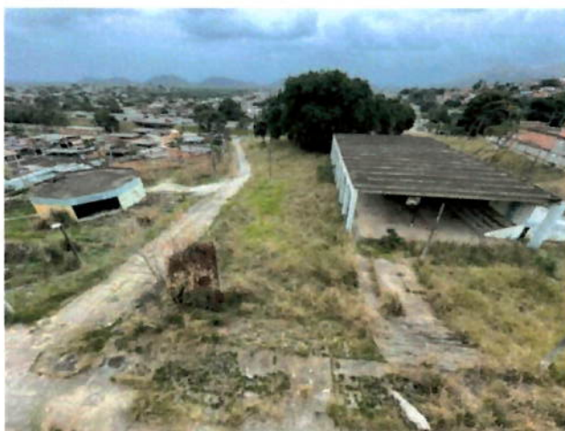
Vista geral da área descoberta com o anexo da biblioteca e o ginásio.
