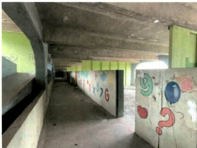
Vista do pátio coberto da edificação principal com a rampa.
