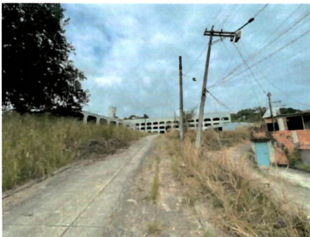
Vista do acesso ao CIEP 045, com a edificação principal e ginásio aos fundos.
