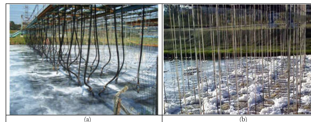
Figura 67: Unidades para adição de produtos químicos coagulantes e polímeros na (a) Coagulação - mistura rápida - e (b) Floculação - mistura lenta. Fonte: FCTH
