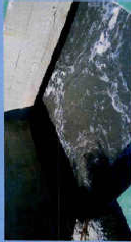
Tanque de Aeração operacional
