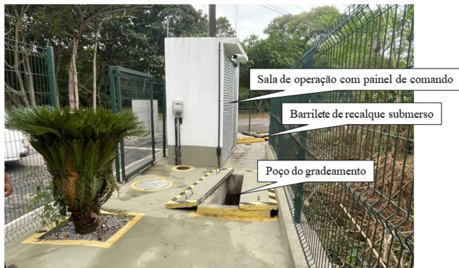
Foto 2 - Vista interna da EEE Câmara Cascudo
