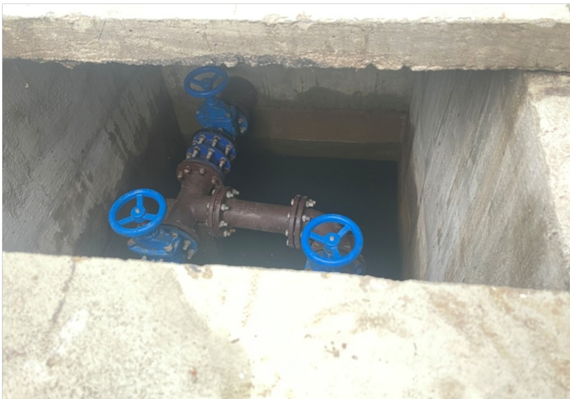
Foto 5 – Poço do barrilete
