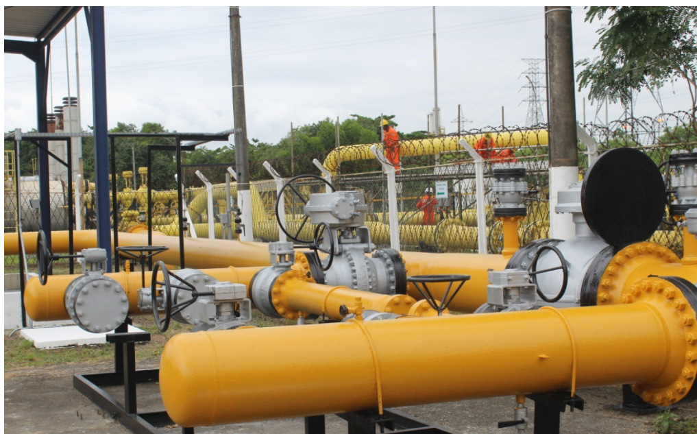
Foto 9: Válvulas manuais.
