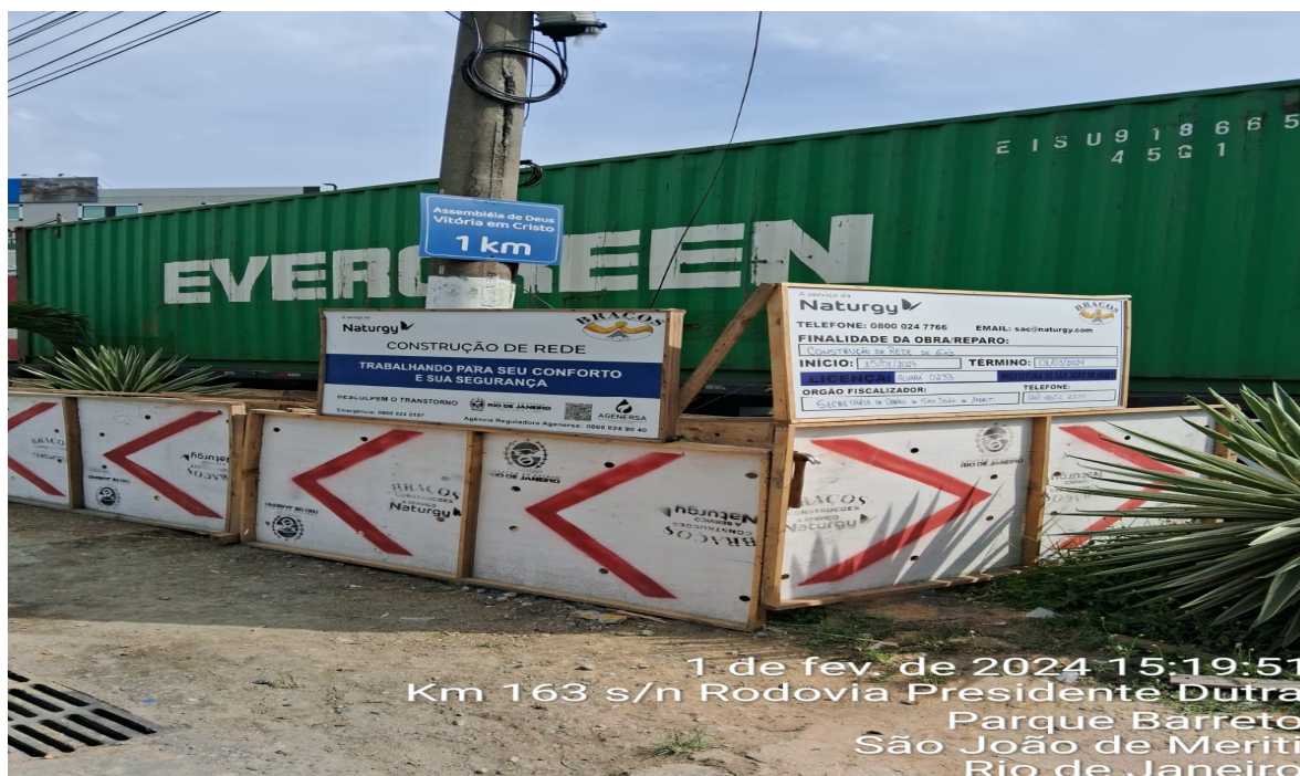
Foto 2: Identificação da obra - pista sul (sentido São Paulo)
