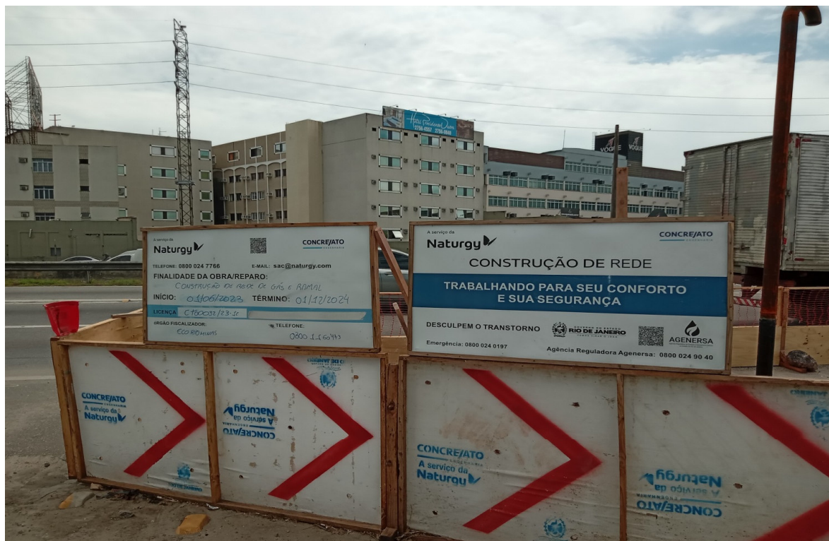
Foto 1: Identificação da obra - pista norte (sentido Rio de Janeiro)
