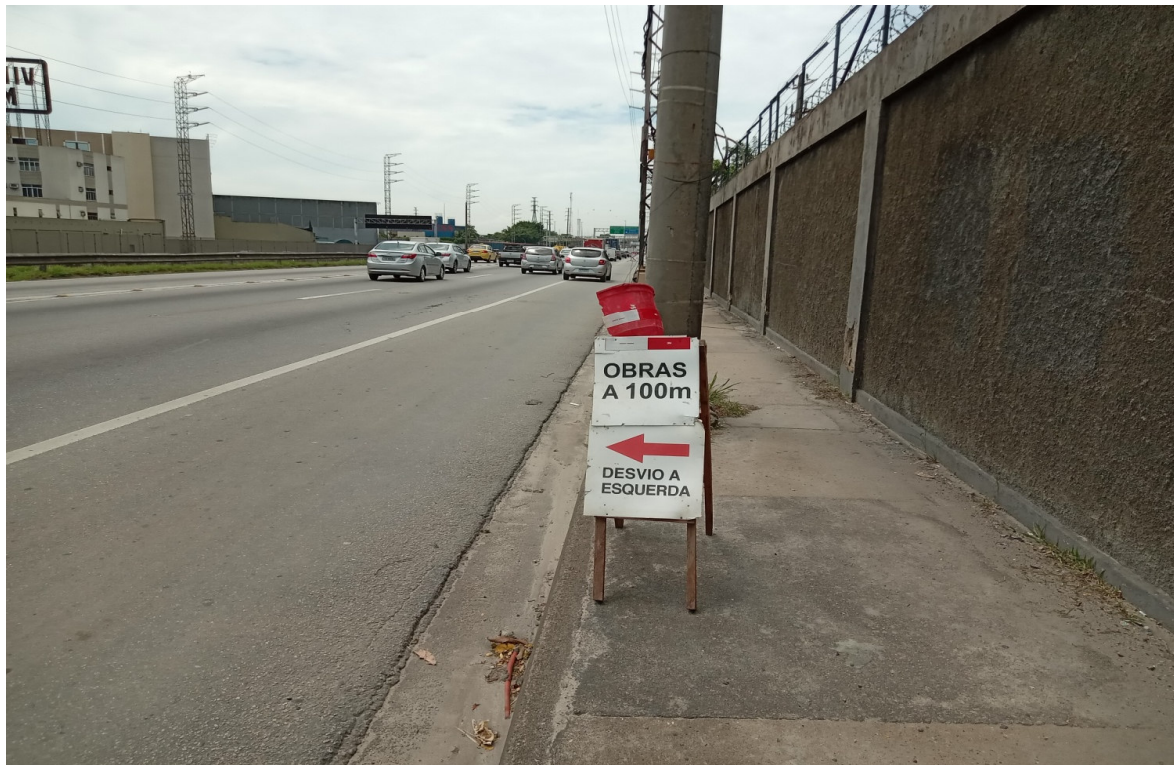
Foto 9: Sinalização - pista norte (sentido Rio de Janeiro)
