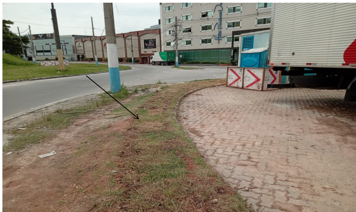
Foto 6: Recomposição - pista sul (sentido São Paulo)
