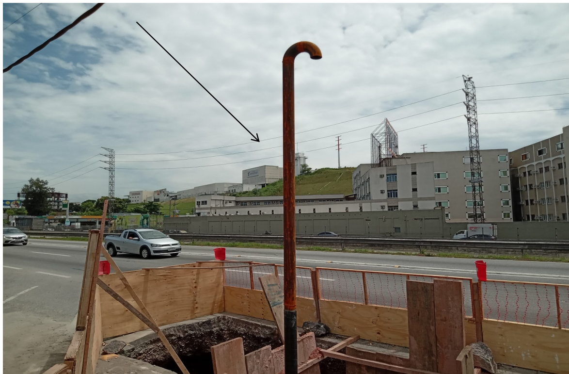
Foto 5: Chaminé de ventilação - pista norte (sentido Rio de Janeiro)
