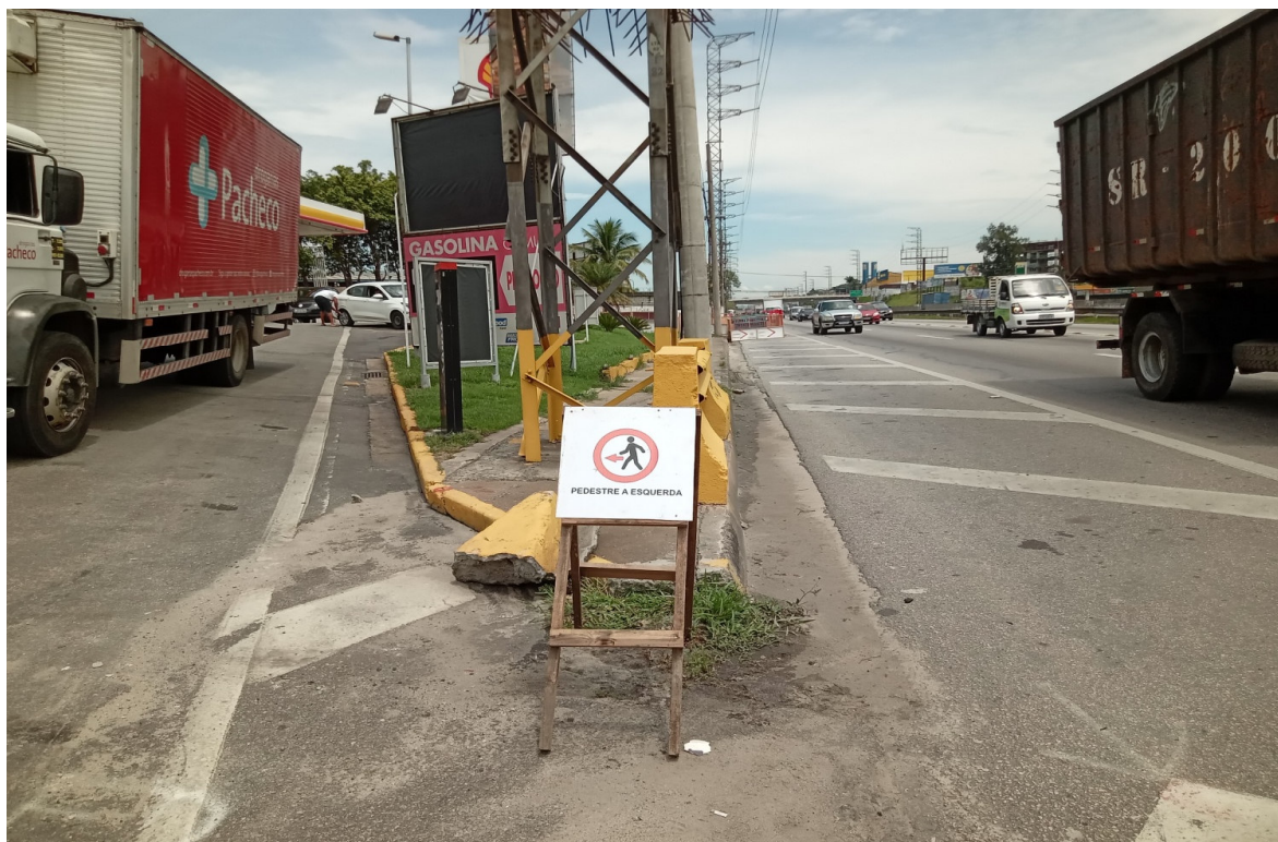
Foto 7: Passagem de pedestre antes da adequação - pista norte (sentido Rio de Janeiro)
