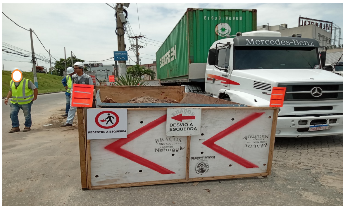
Foto 12: Área de descarte e sinalização - pista sul (sentido São Paulo)
