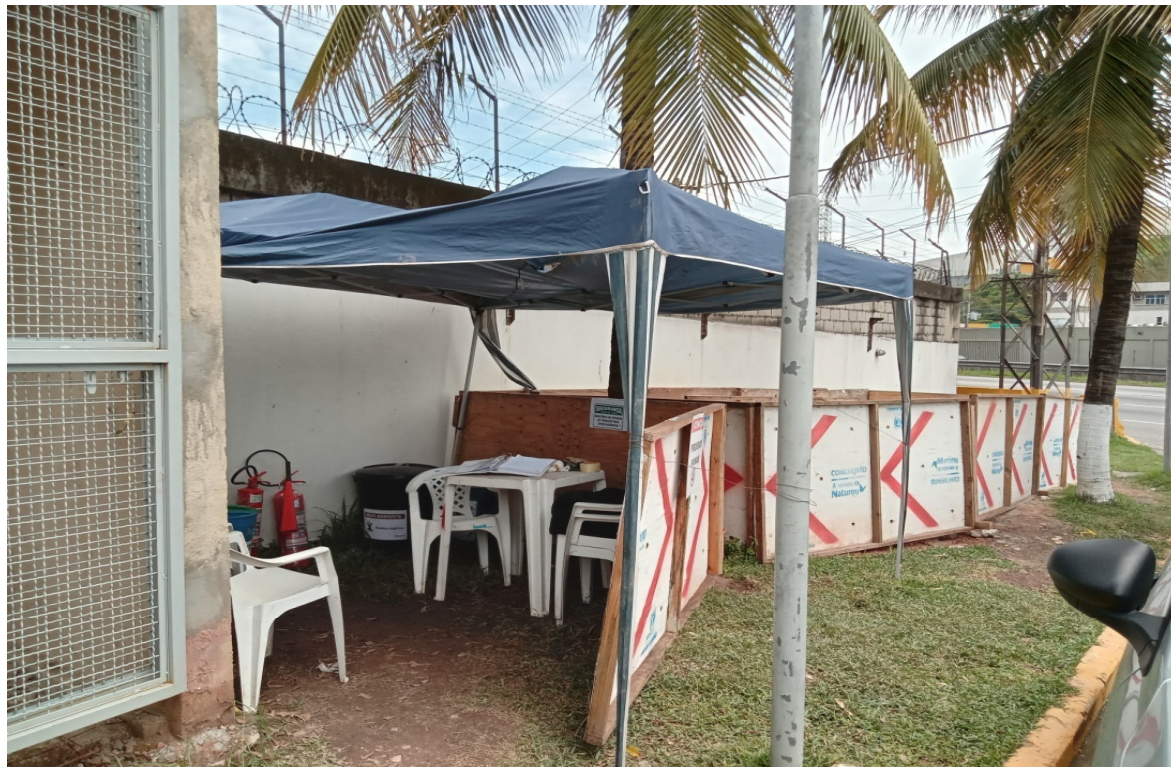
Foto 3: Área de vivência - pista norte (sentido Rio de Janeiro)
