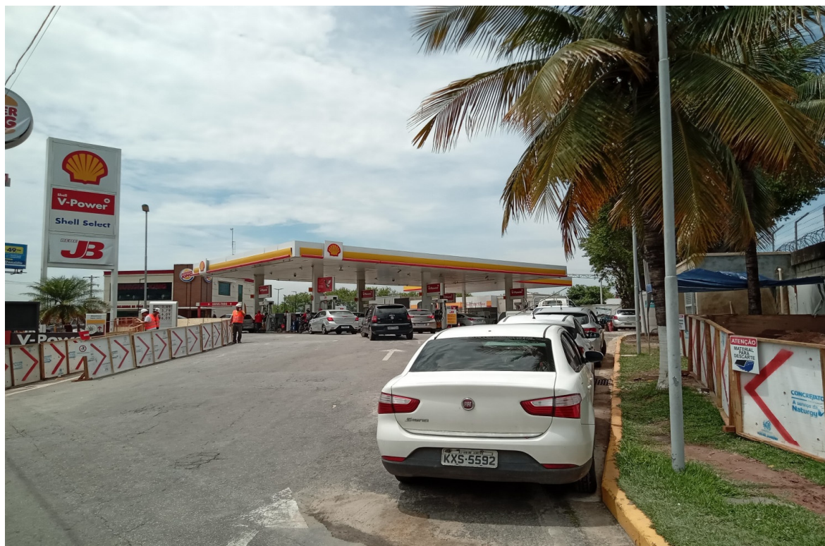
Foto 11: Vista geral da obra na entrada do posto Galápagos - pista norte (sentido Rio de Janeiro)
