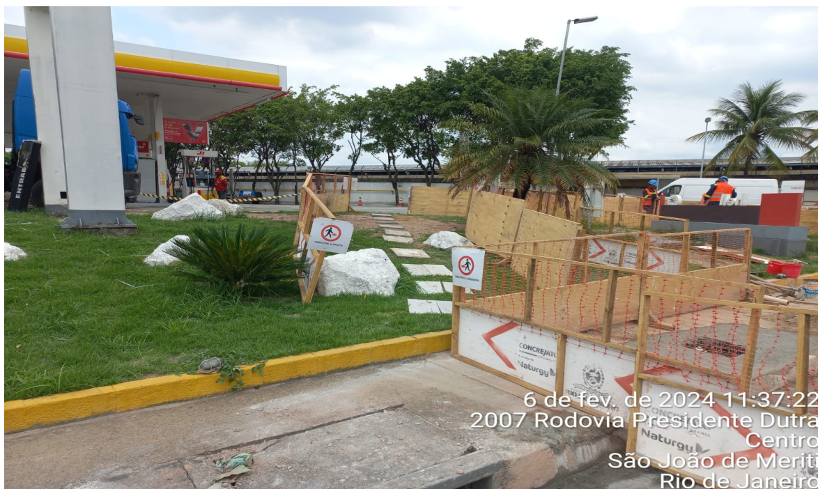
Foto 8: Adequação da passagem de pedestre visando oferecer maior segurança - pista norte
