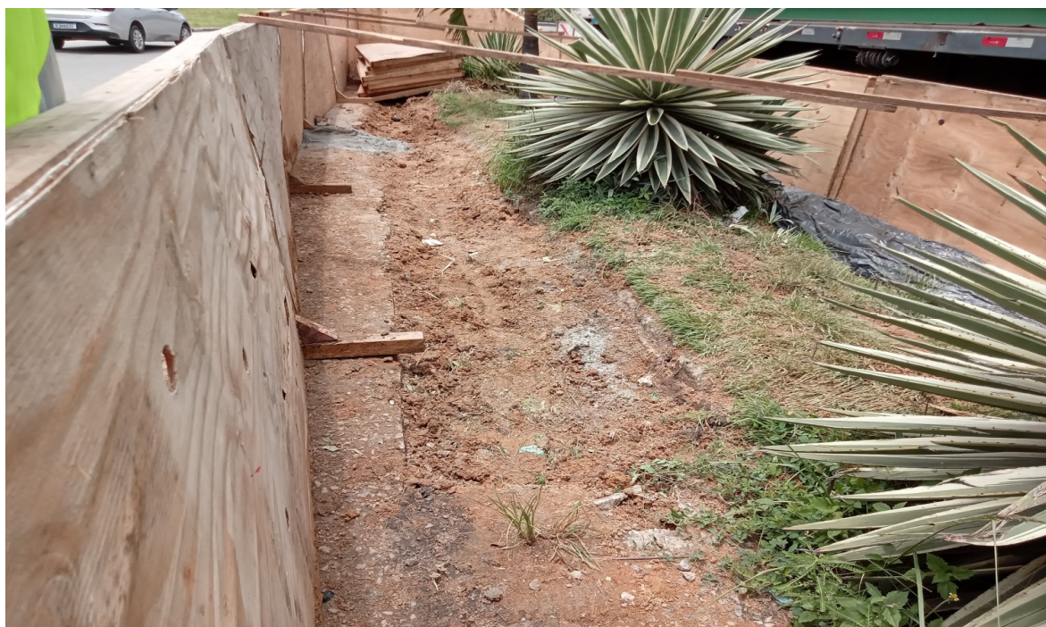
Foto 10: Reaterro de vala no passeio após assentamento de rede - pista sul (sentido São Paulo)
