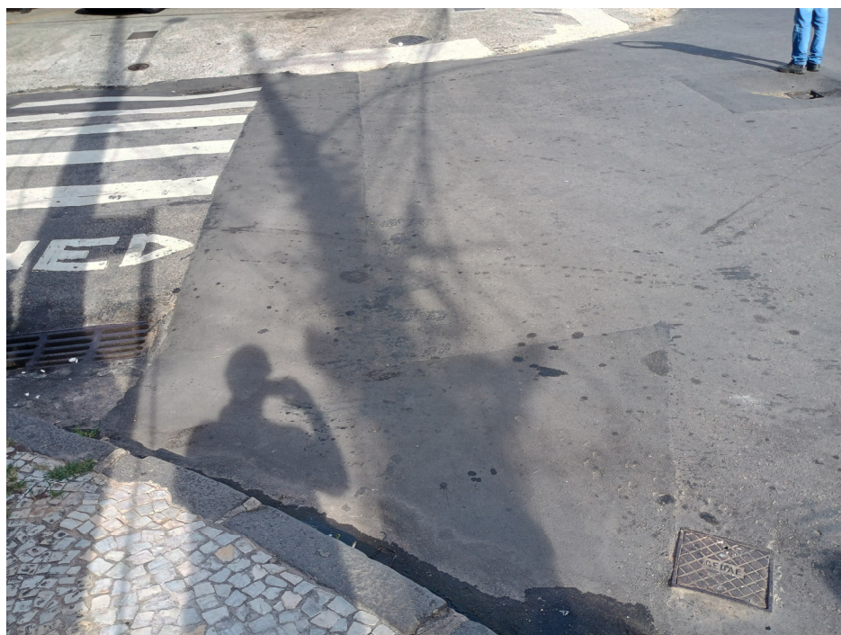
Foto 4: trecho de recomposição na via.
