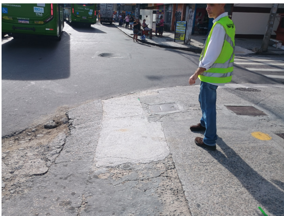
Foto 2: trecho de recomposição no passeio.
