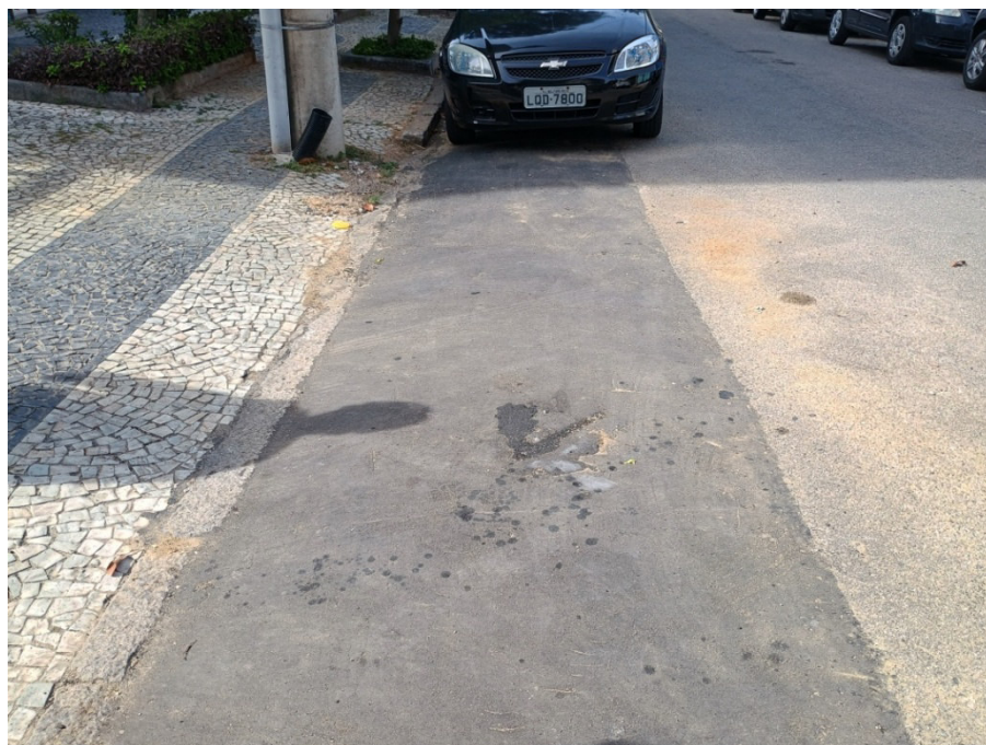
Foto 7: trecho de recomposição provisória sem identificação.
