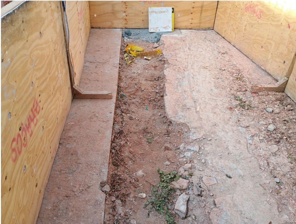
Foto 5: assentamento de tubulação por método destrutivo.
