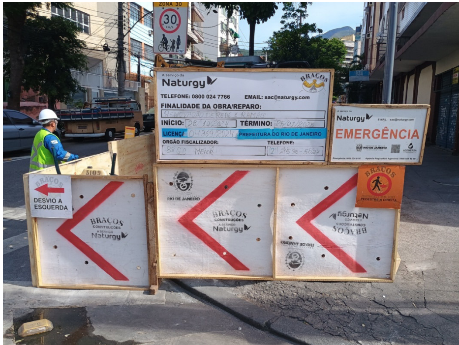
Foto 1: início da obra na Rua José Veríssimo.
