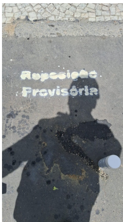
Foto 8: trecho de recomposição provisória identificado após fiscalização.
