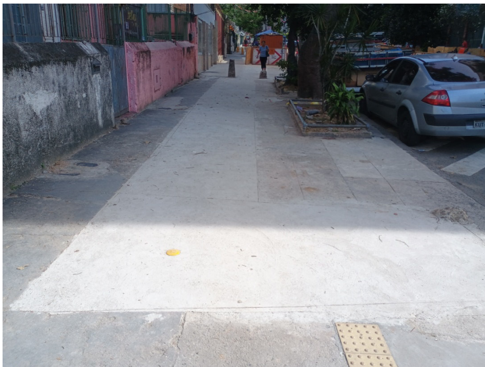
Foto 2: trecho de recomposição no passeio.
