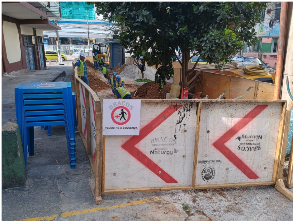
Foto 6: trecho em andamento na Rua José Veríssimo, entre o número 14 e a esquina com a Rua Dias da Cruz.
