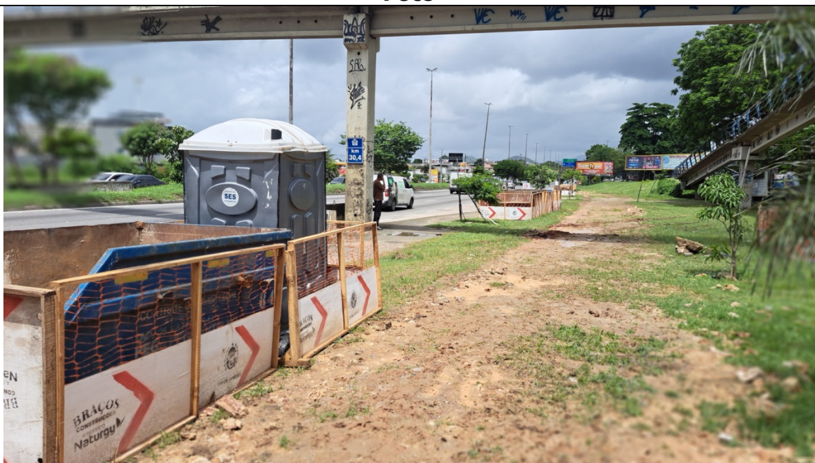
Foto 6: Trecho executado Método Destrutivo recomposto
