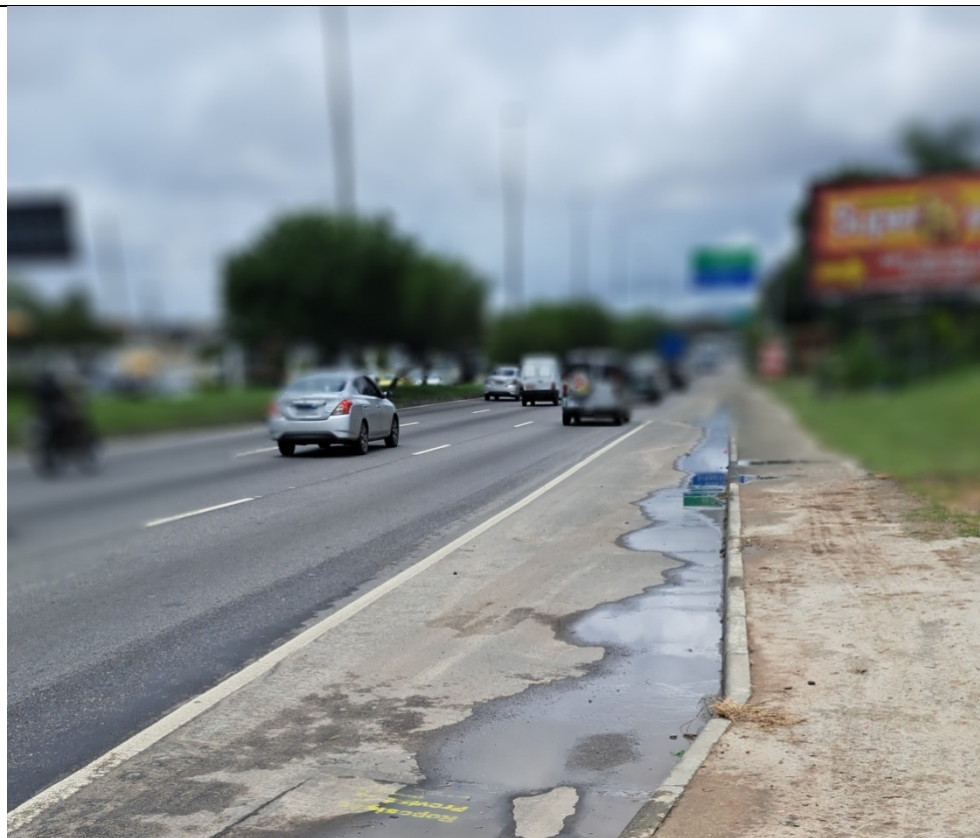
Foto 5: Trecho executado por MND com recomposição provisória
