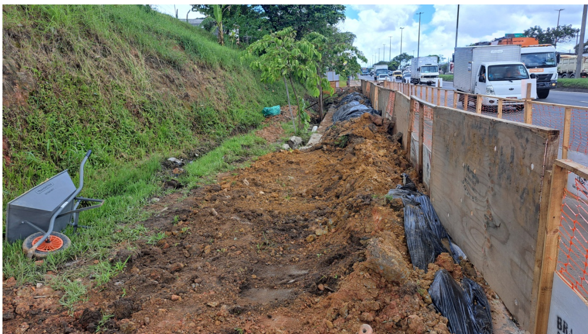
Foto 12: Trecho em execução com recomposição provisória
