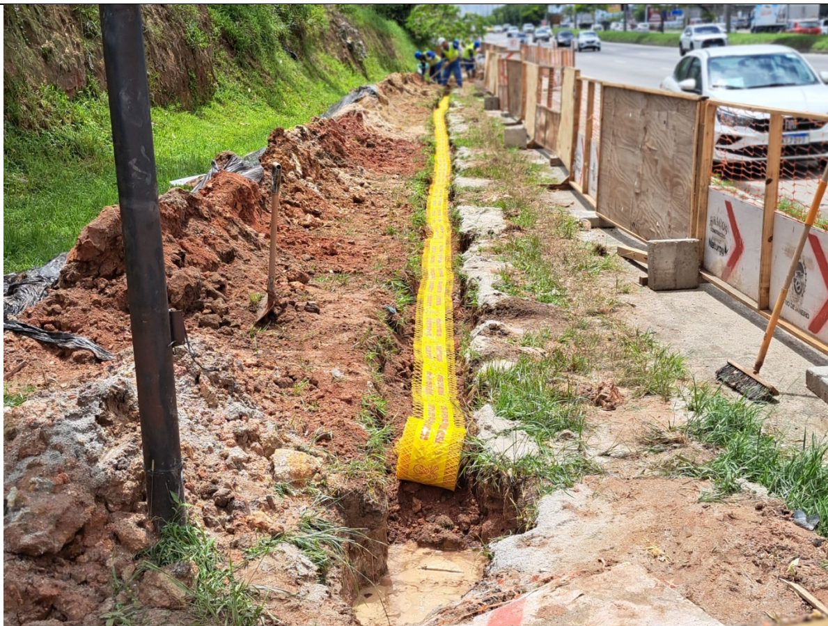
Foto 7: Trecho em execução - método destrutivo
