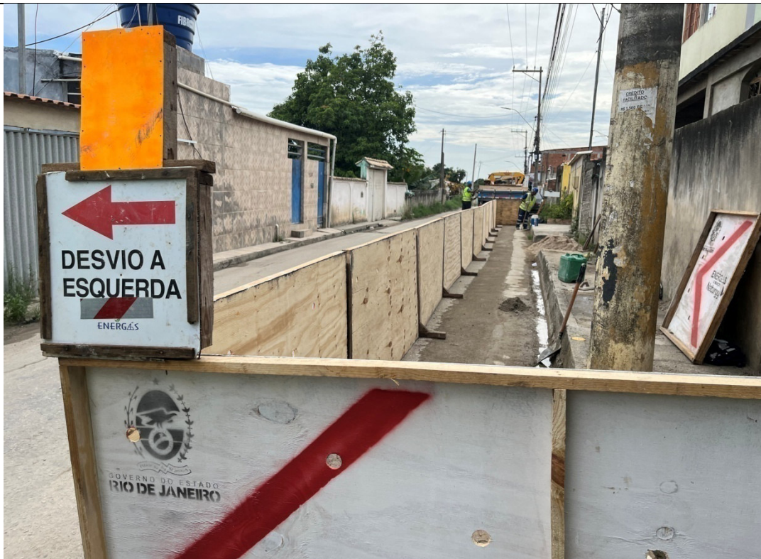
Foto 8: Obra de recomposição da via.
