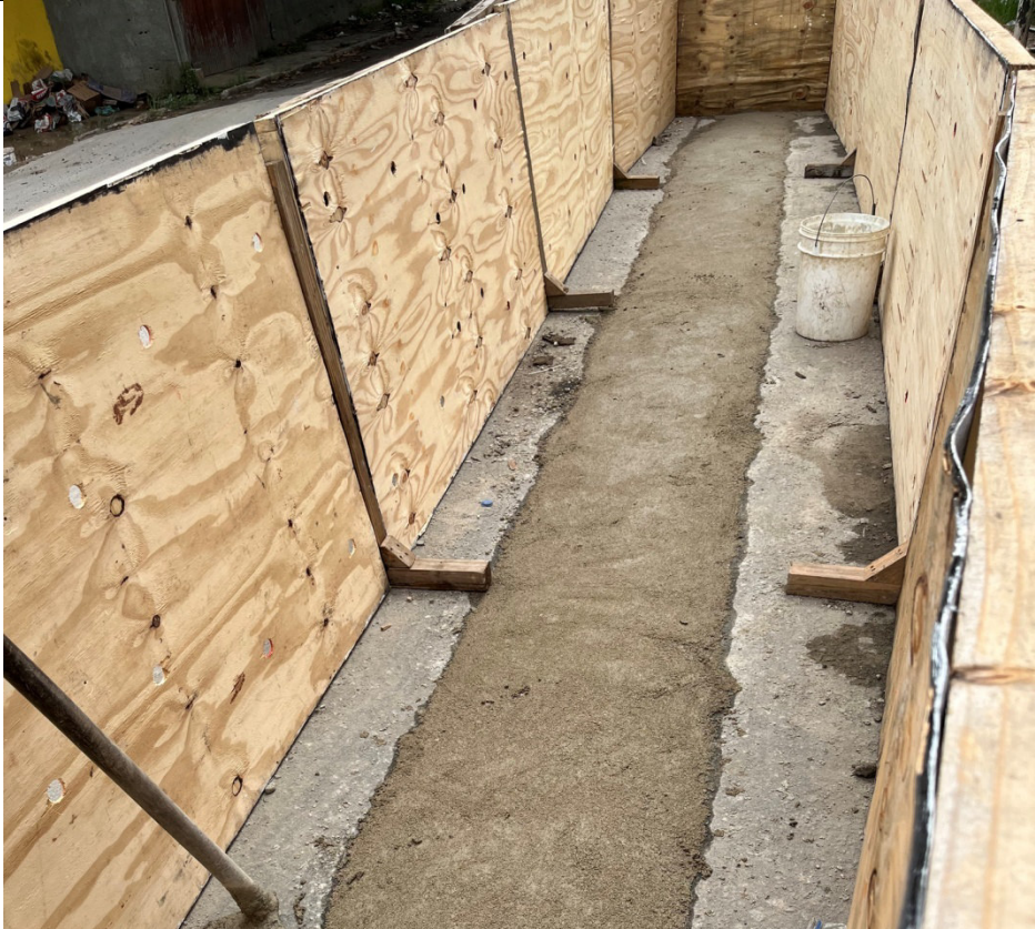
Foto 5: Obra de recomposição da via.
