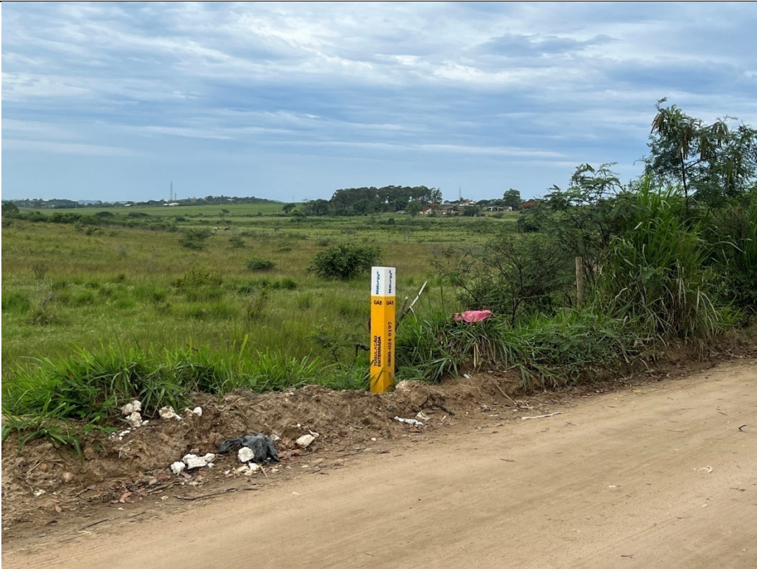
Foto 10: Marco vertical instalado no segundo trecho da obra.
