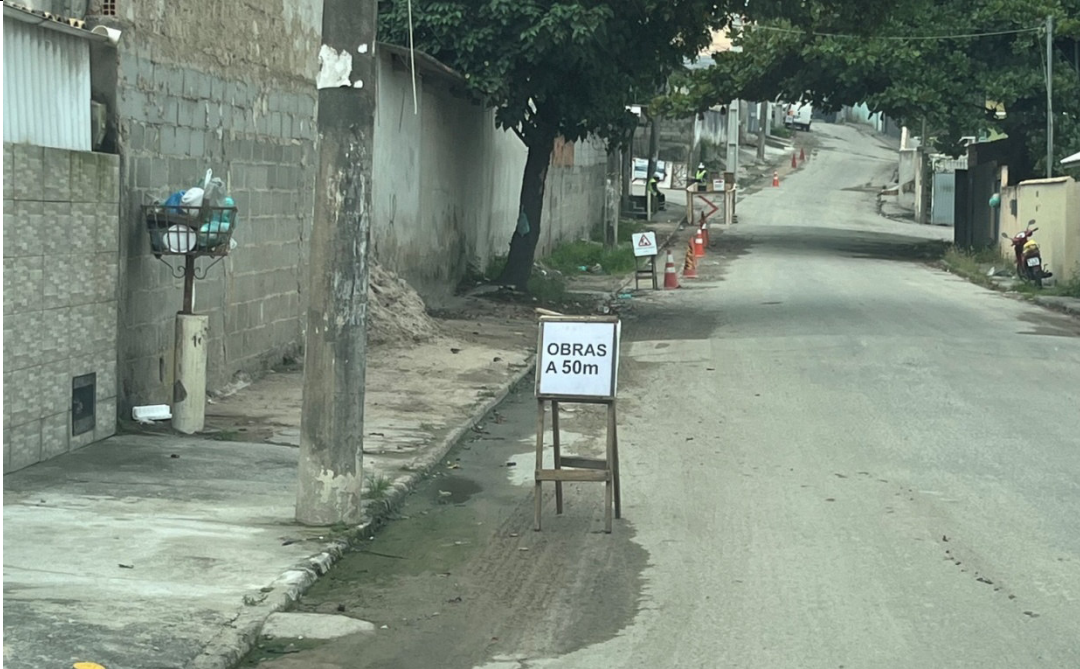
Foto 3: Avisos de obra e cones ao fundo.
