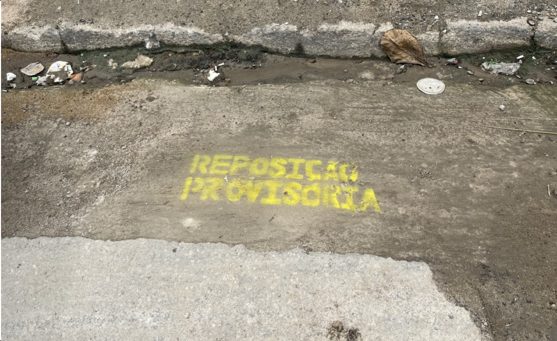
Foto 7: Trecho da via com recomposição provisória.
