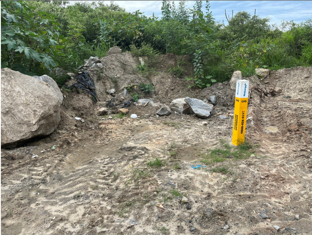
Foto 9: Marco vertical instalado na estrada adjacente à pedreira.
