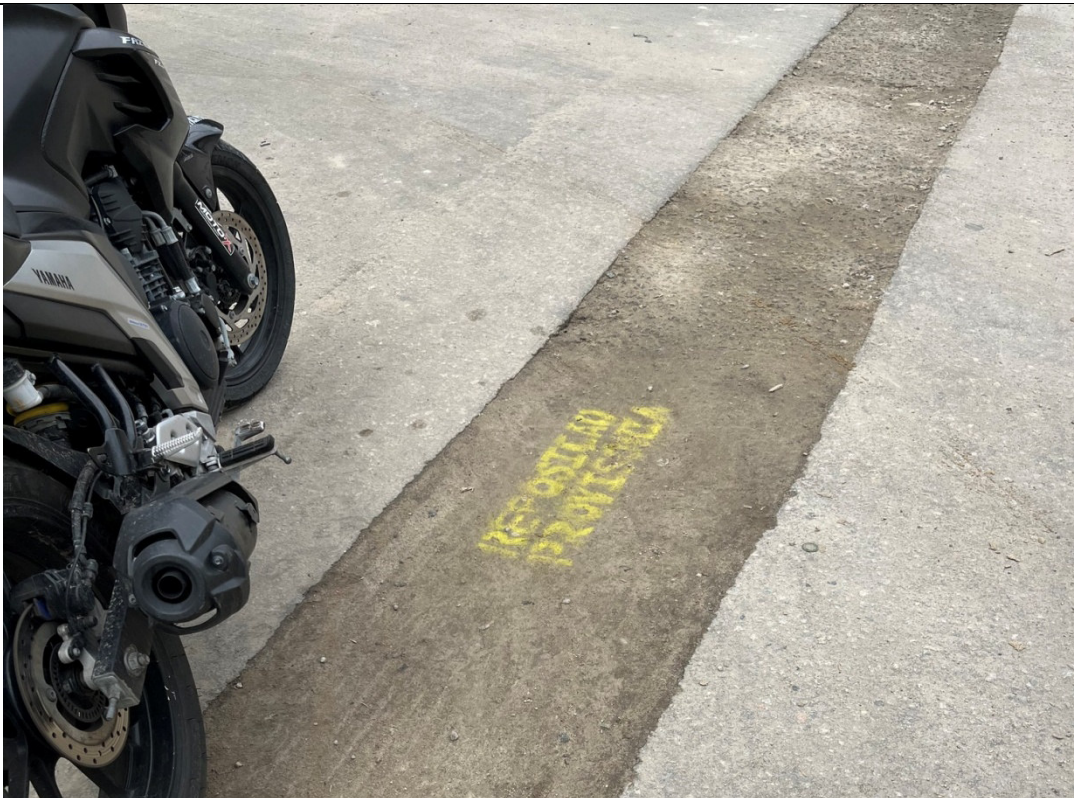
Foto 6: Trecho da via com recomposição provisória.
