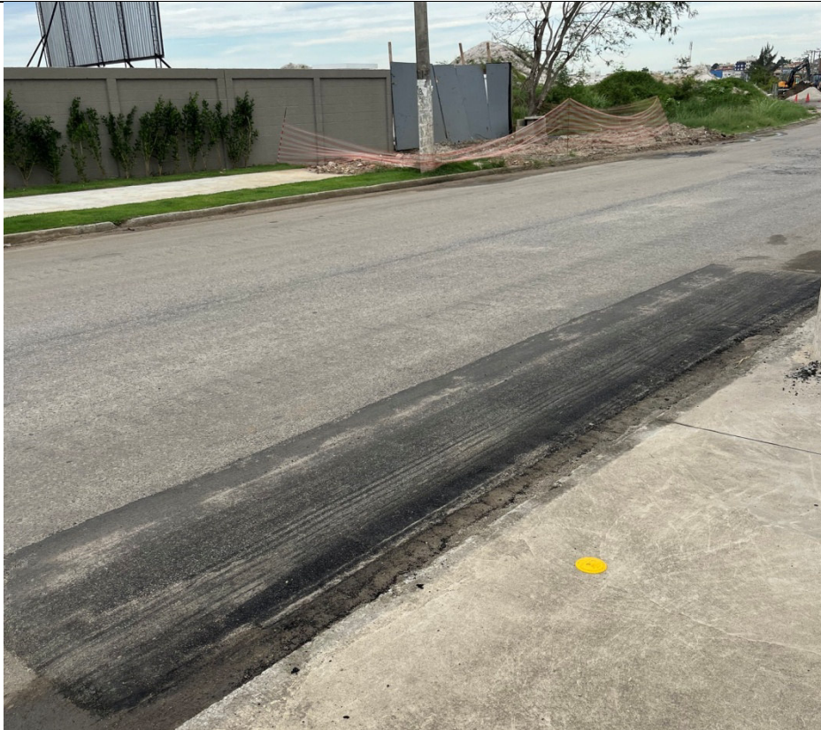
Foto 11: Recomposição permanente na via, e marco plano no passeio.
