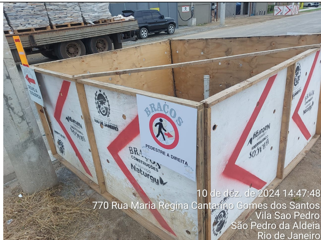
Foto 14: Obra de extensão da obra com sinalizações acertadas.
