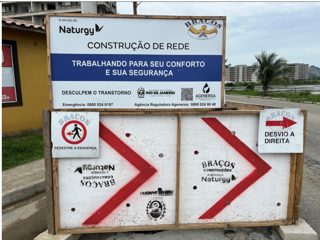
Foto 9: Aviso de obra e sinalização de desvio para pedestre e trânsito.
