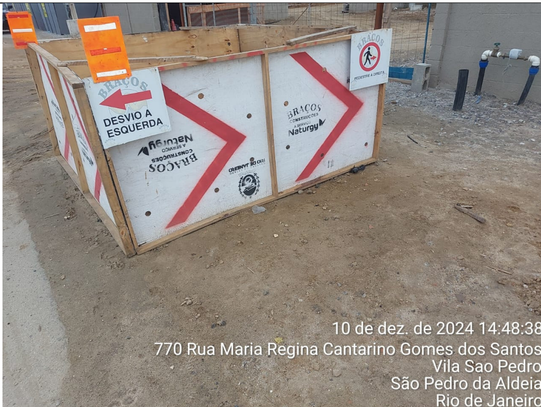
Foto 13: Obra de interligação com sinalizações acertadas.
