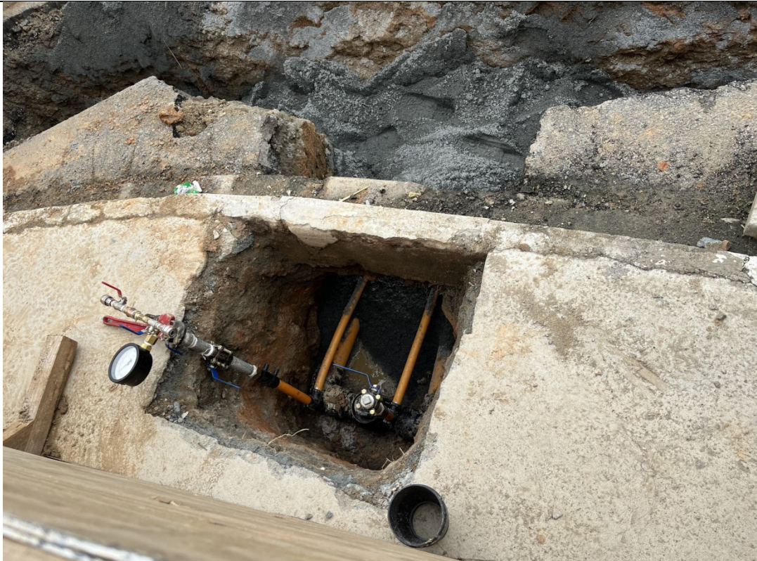
Foto 3: Ponto de interligação para expansão da rede.
