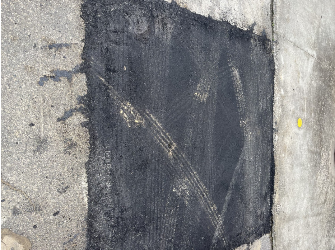
Foto 7: Trecho com recomposição permanente na via e marco plano.
