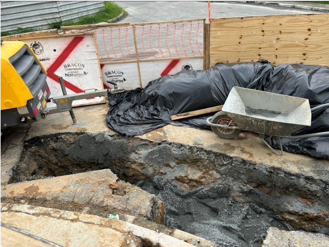
Foto 2: Obra de expansão de rede por método destrutivo.
