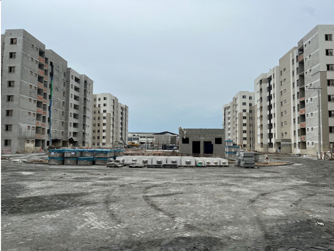
Foto 3: Vista do empreendimento em construção.
