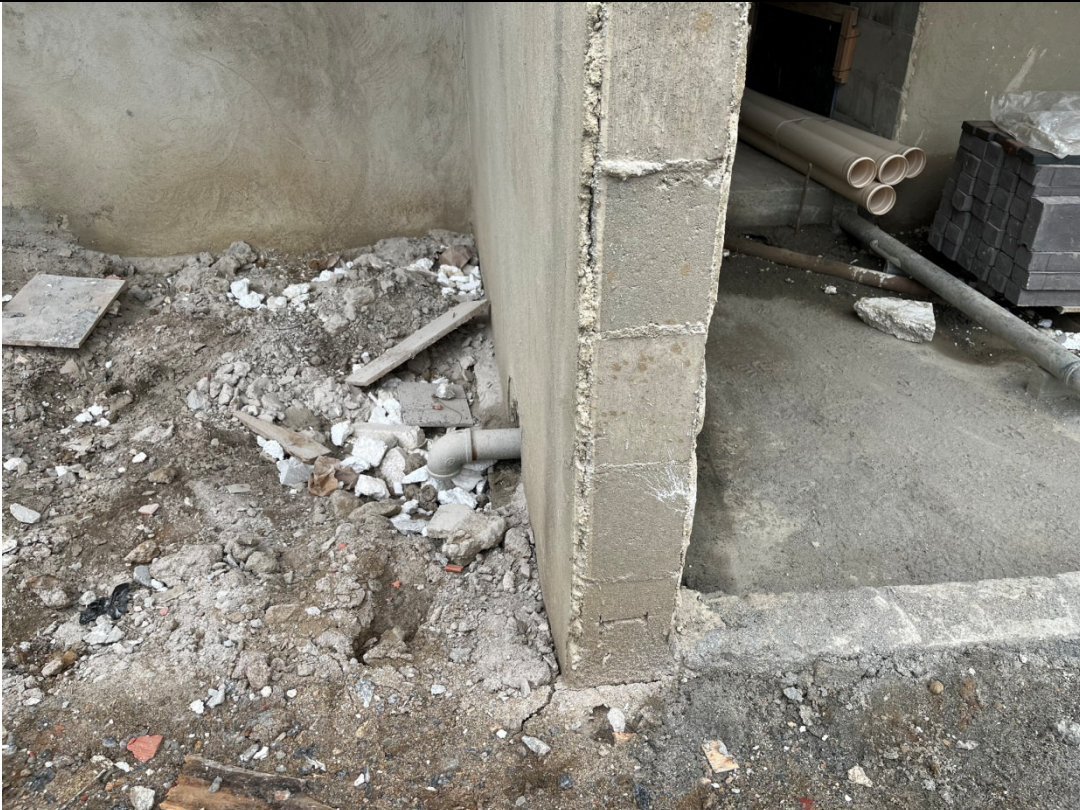
Foto 4: Entrada da tubulação em um dos prédios, onde será ligado ramal.
