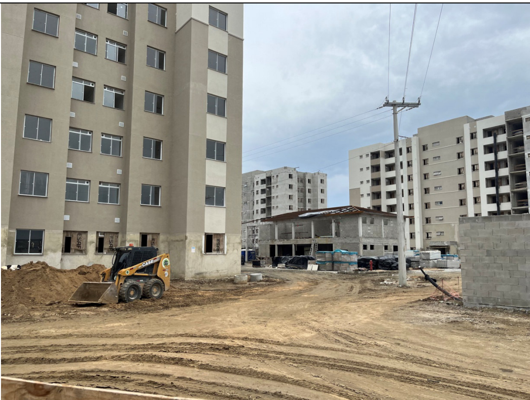
Foto 2: Empreendimento atendido, ainda em construção.
