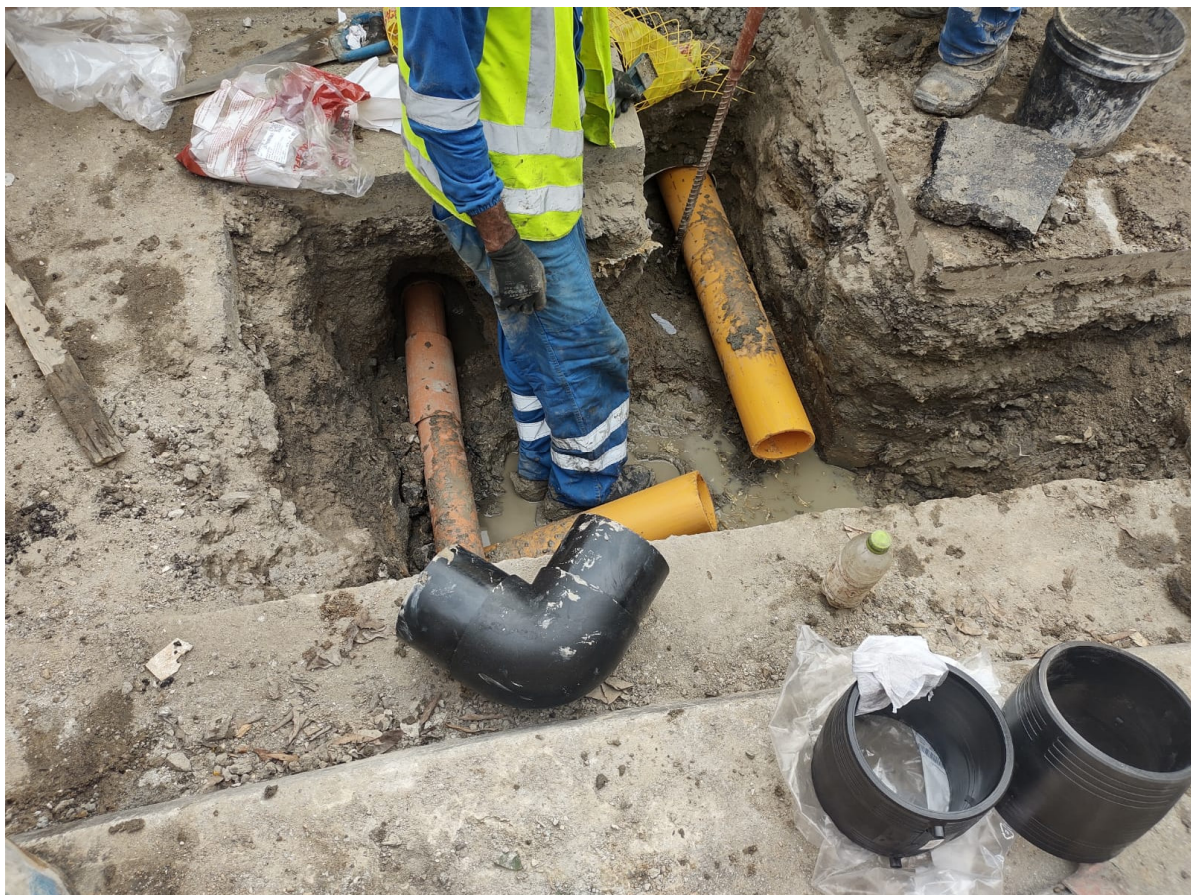
Foto 8: Instalação de conexão na esquina das Ruas Dr. Godofredo Garcia Cruz com a Rua Jornalista Osias Stutz.
