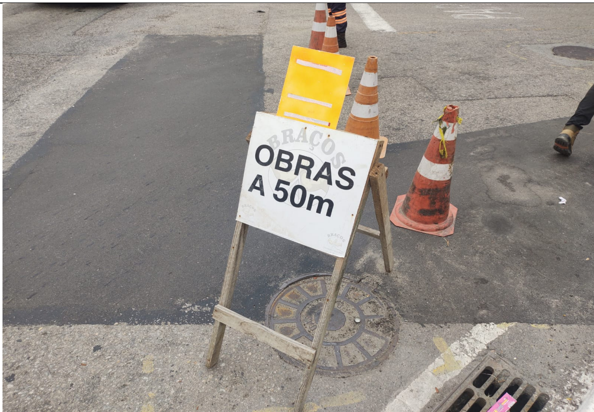
Foto 5: Recomposição definitiva e placa de aviso de obra.
