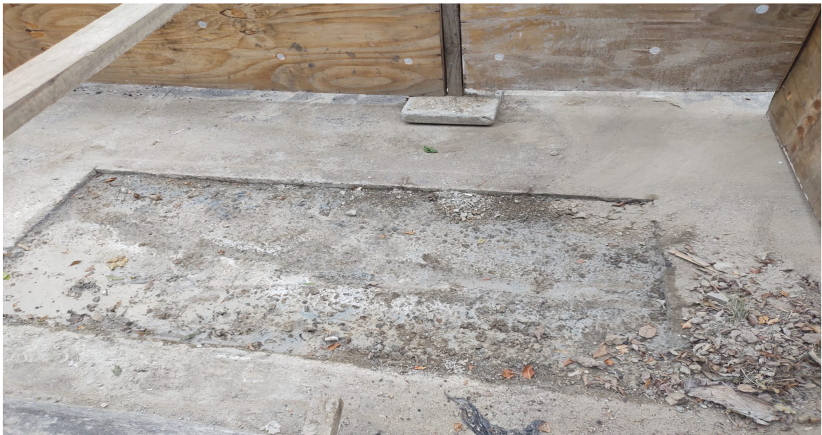
Foto 12: Recomposição provisória com isolamento em frente ao nº 36 da Rua Jornalista Osias Stutz.
