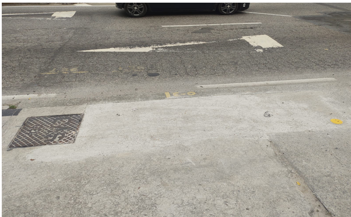
Foto 4: Caixa para válvula de setorização e recomposição definitiva na Estrada Francisco da Cruz Nunes.
