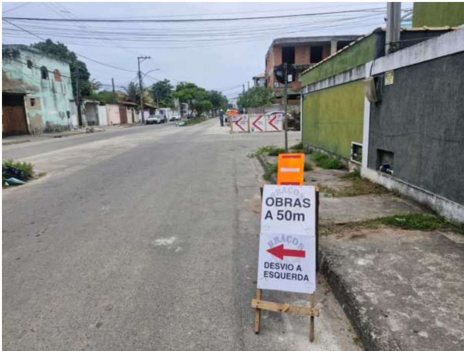
Foto 3: Sinalização de Obra.
