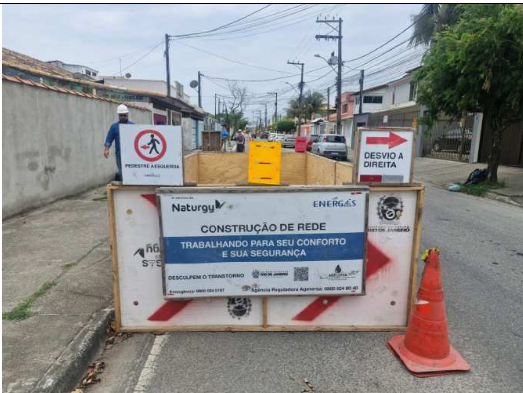
Foto 2: Sinalização de desvio de pedestre e desvio de trânsito.
