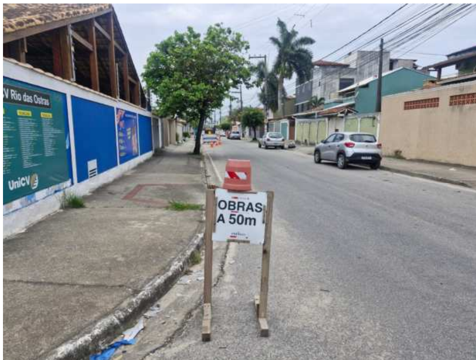
Foto 5: Sinalização de Obra
