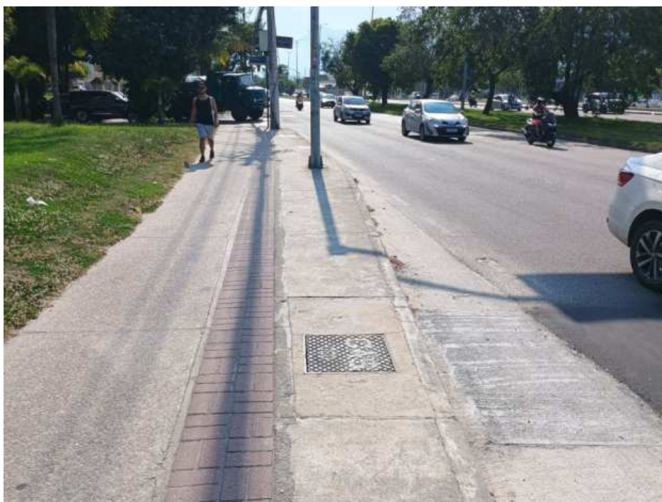
Foto 1: início da fase 2, na Avenida das Américas, na altura da Avenida Guiomar de Novaes.
