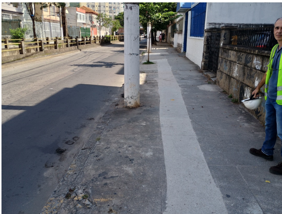
Foto 2: trecho de recomposição após assentamento por método destrutivo.
