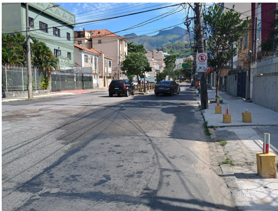
Foto 3: início da obra, próximo ao número 229.
