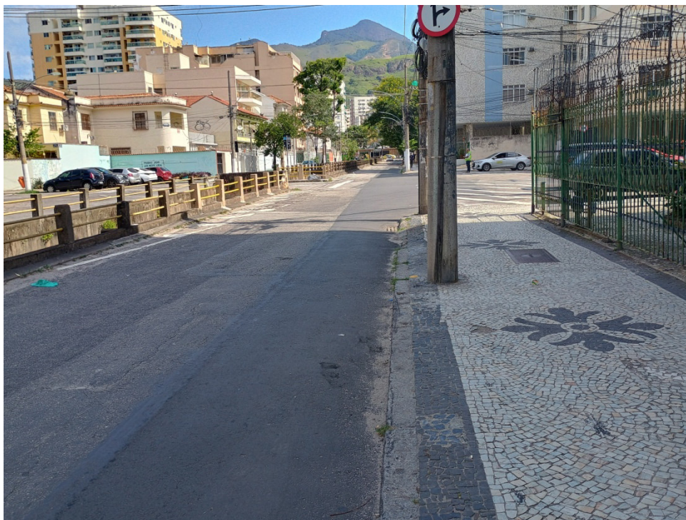
Foto 1: trecho de recomposição após assentamento por método destrutivo.
