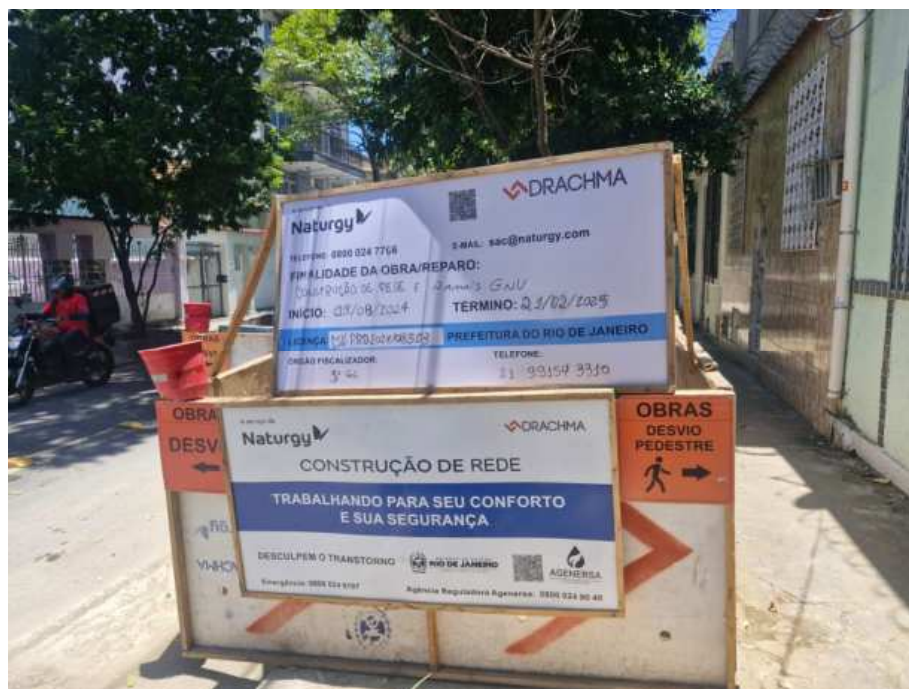
Foto 1: Identificação da obra de renovação de rede.
