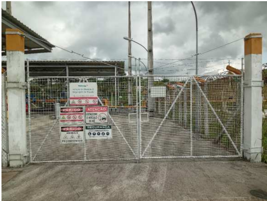
Foto 1: Entrada da estação e sinalização de segurança.
