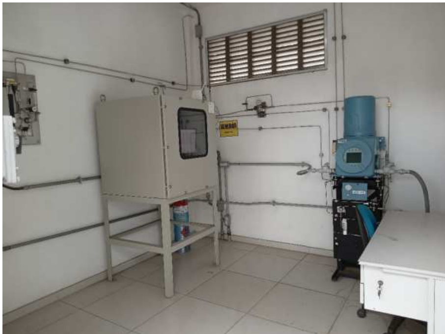
Foto 12: Sala de cromatografia (análise da qualidade do gás).
