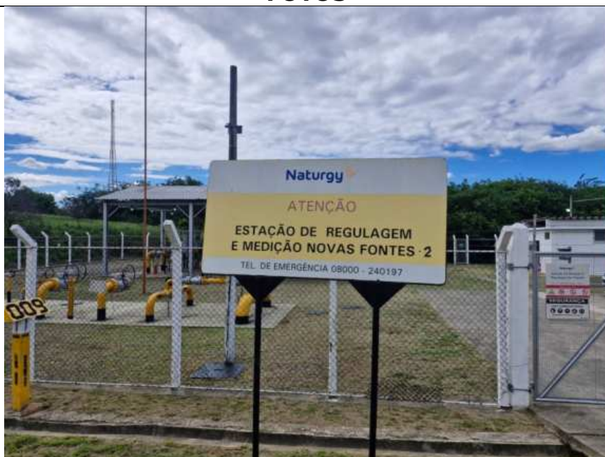
Foto 1: Placa de identificação da Estação.
