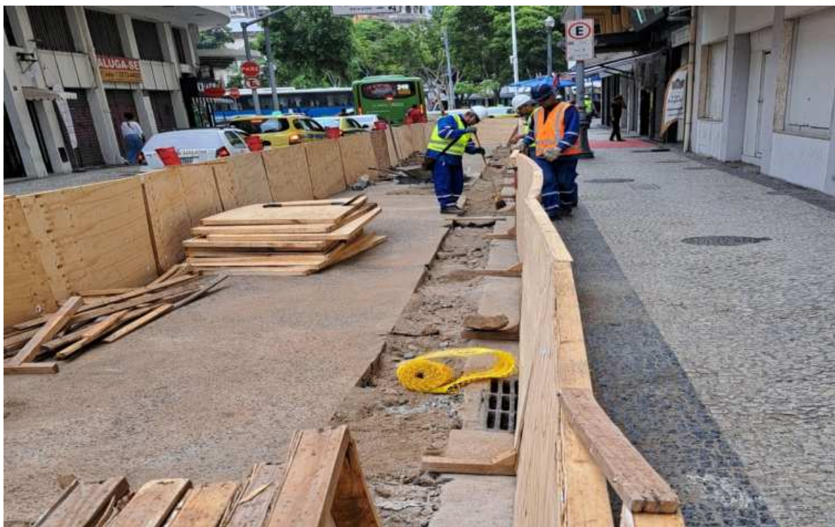
Foto 10: Tubulação assentada na Rua Pedro I.
