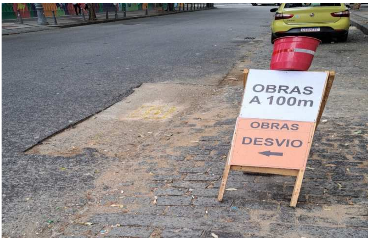
Foto 12: Recomposição provisória e Placa de sinalização na Rua do Senado.
