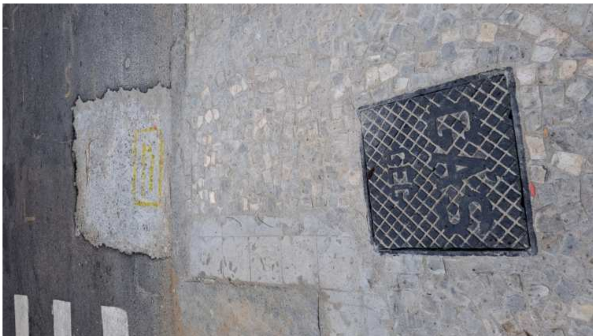
Foto 4: Caixa para válvula de setorização e recomposição provisória em frente ao nº 90 da Rua do lavradio.
