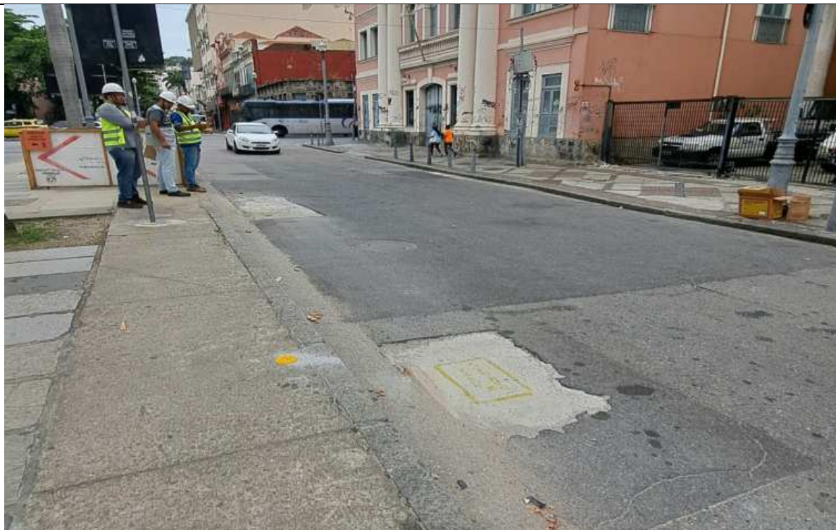
Foto 5: Recomposição provisória em frente ao nº 78 da Rua do lavradio.
