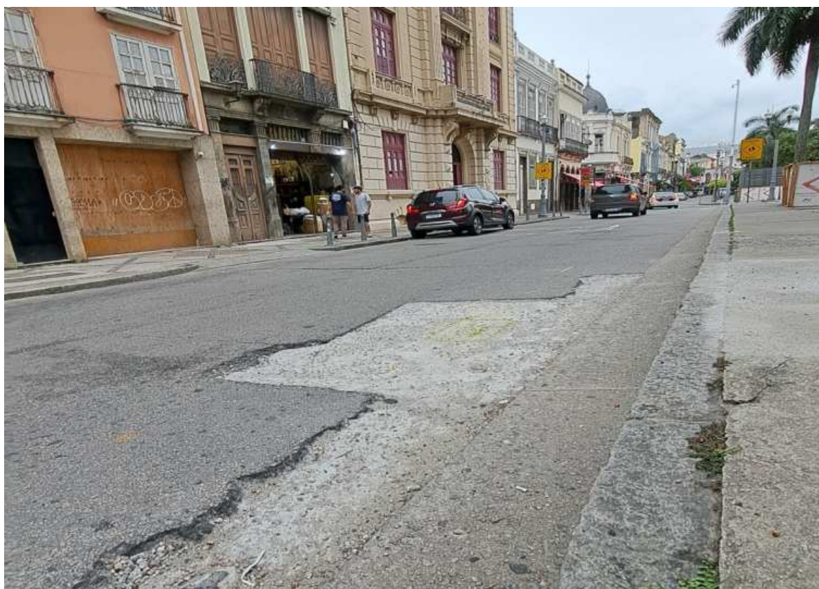
Foto 6: Recomposição provisória em frente ao nº 62 da Rua do lavradio.
