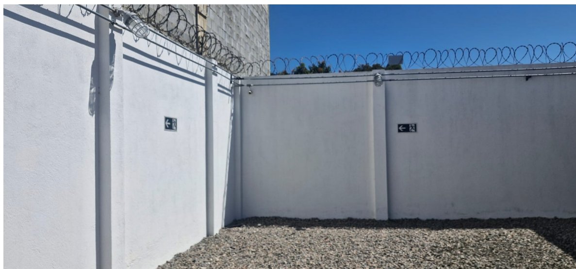
Foto 7: Muro da estação e sinalização de rota de fuga.
