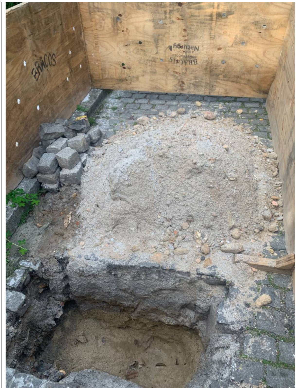
Foto 9: Sondagem realizada para identificação do tipo de solo antes do assentamento da tubulação de gás
