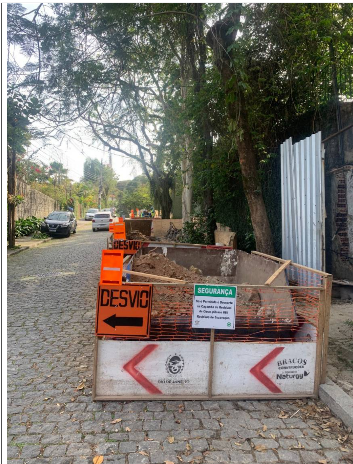
Foto 8: Caçamba para descarte de resíduos de escavação na obra de expansão da rede de gás, com sinalização de segurança e desvio para pedestres
