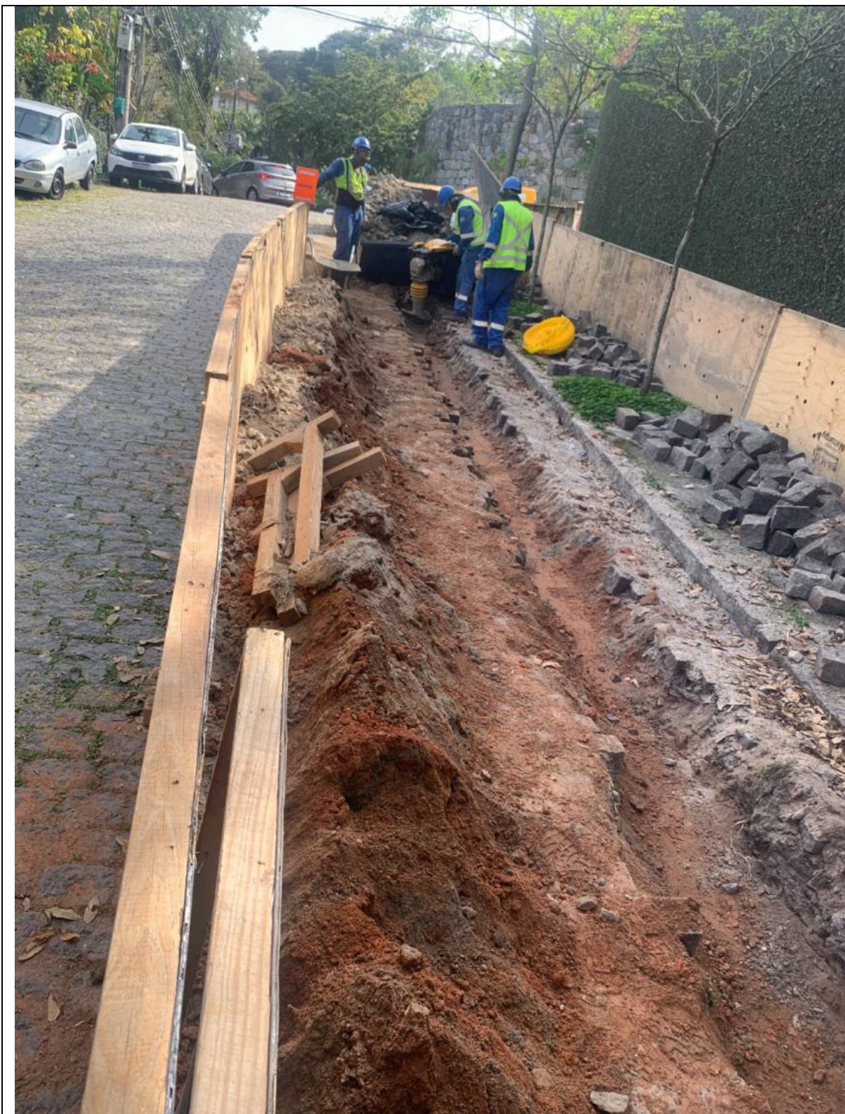
Foto 5: Escavação para assentamento de tubulação de gás no Jardim Botânico, Rio de Janeiro/RJ.
