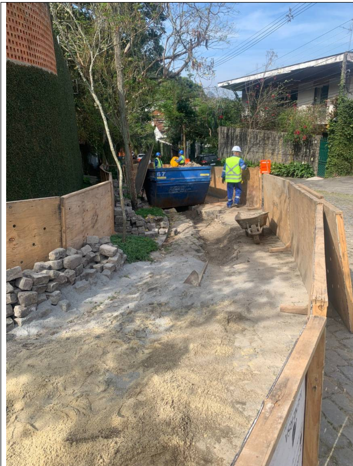
Foto 4: Obra de expansão da rede de gás no Jardim Botânico, Rio de Janeiro/RJ, com escavação por método destrutivo.
