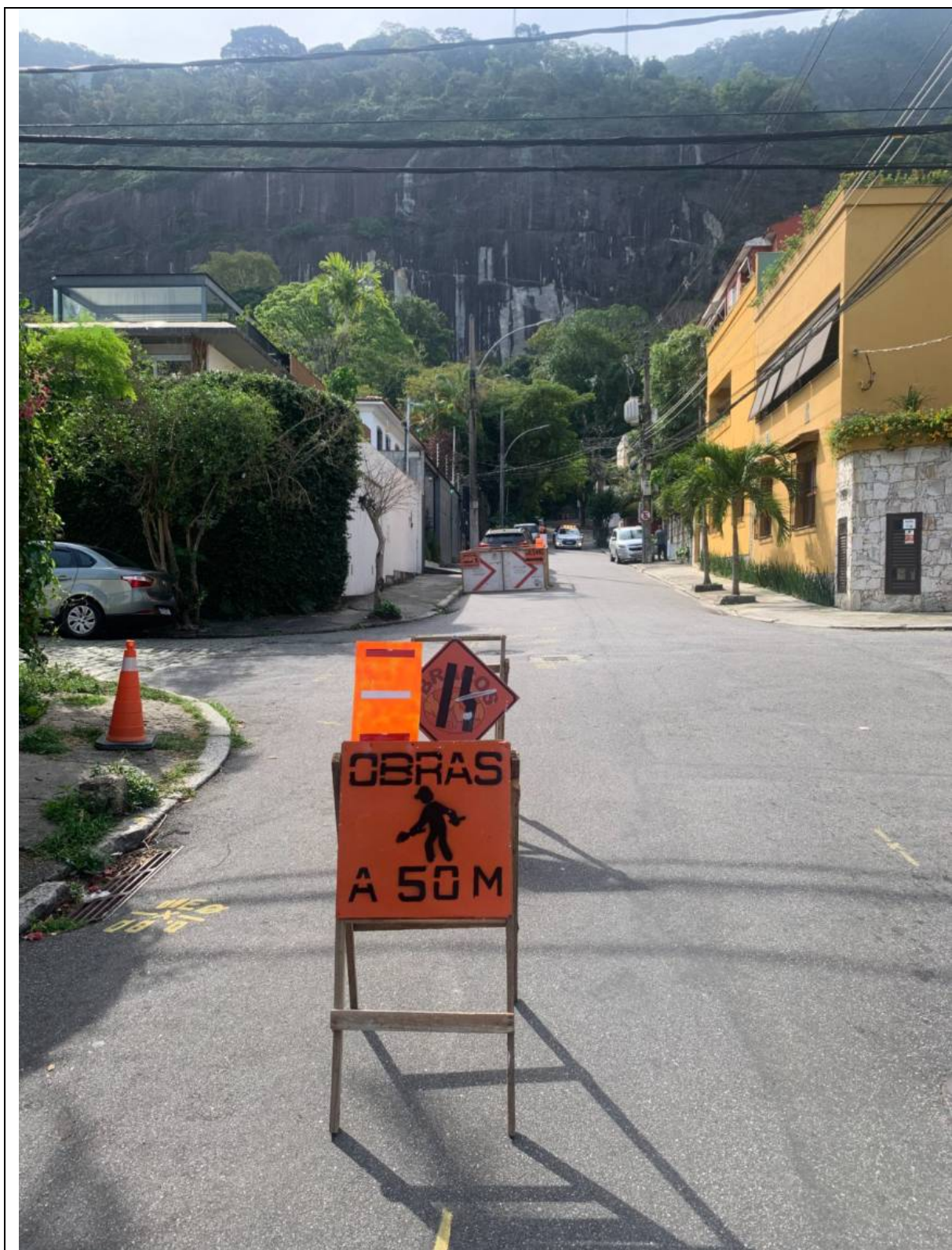
Foto 11: Sinalização de advertência indicando obra a 50 metros de distância no Jardim Botânico, Rio de Janeiro/RJ.
