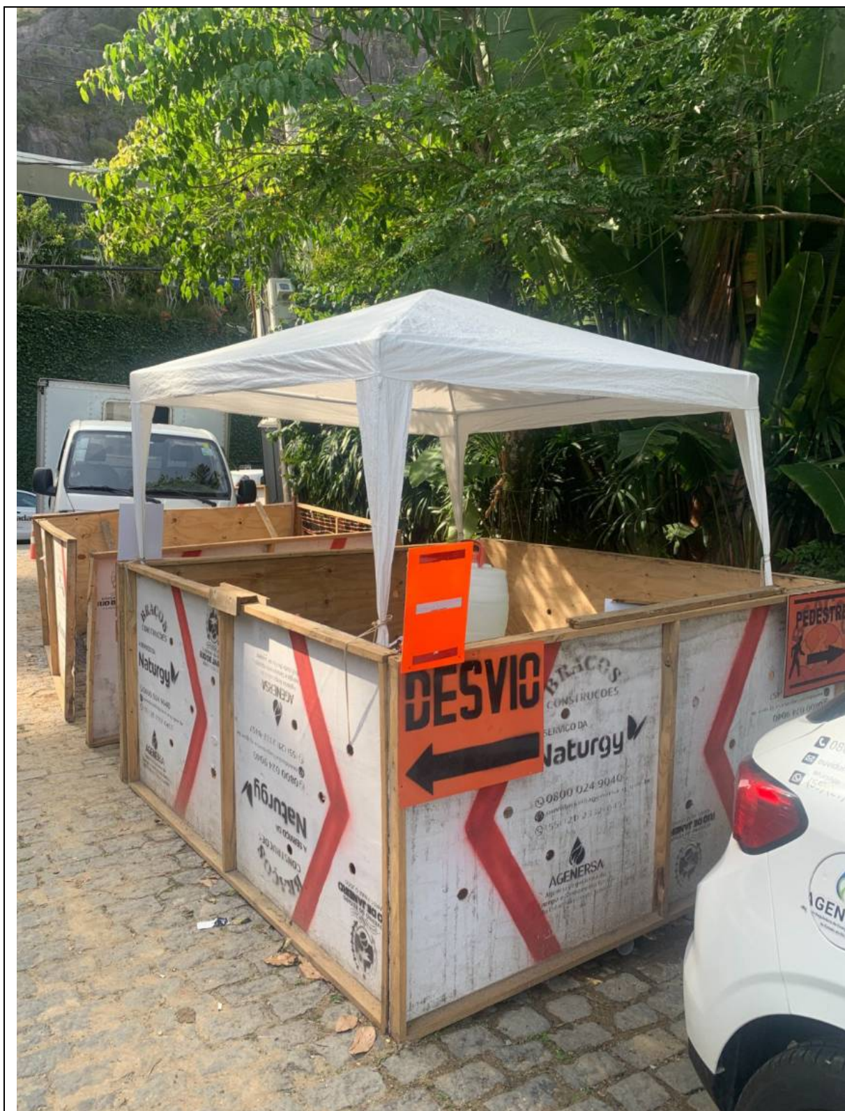
Foto 7: Local de vivência da obra de expansão da rede de gás no Jardim Botânico
