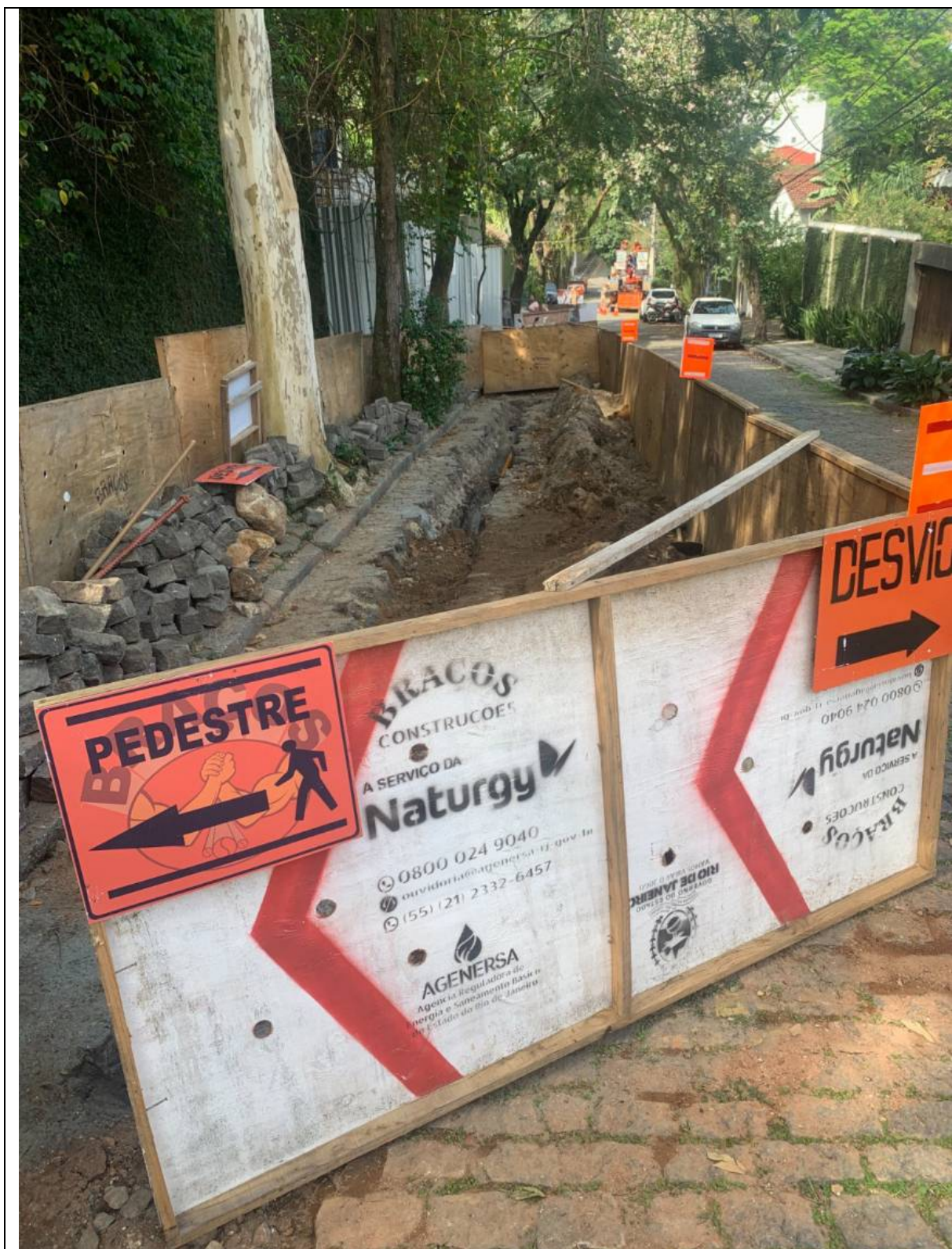
Foto 6: Trecho da obra de expansão da rede de gás no Jardim Botânico, Rio de Janeiro/RJ, com sinalização para desvio de pedestres e sinalização noturna.
