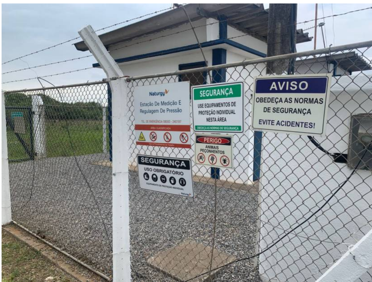
Foto 8: Placas de sinalização de segurança.
