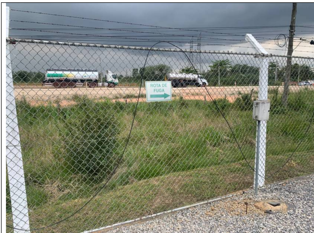
Foto 9: Placa de rota de fuga.
