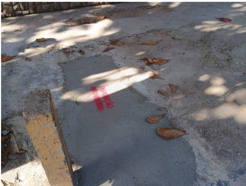
Foto 7: trecho de recomposição provisória identificada.
