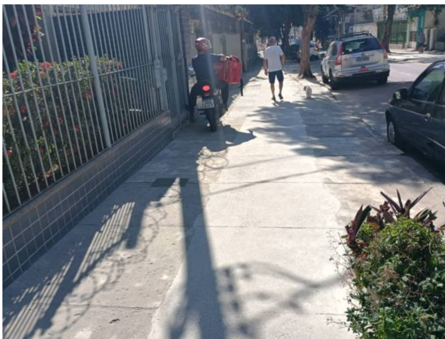
Foto 6: trecho de recomposição após o assentamento da rede.
