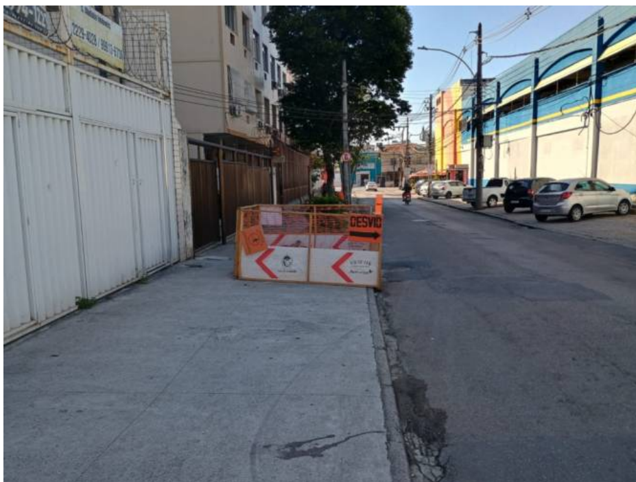
Foto 4: trecho da obra na Rua Carolina Santos, próximo à Rua Dias da Cruz.
