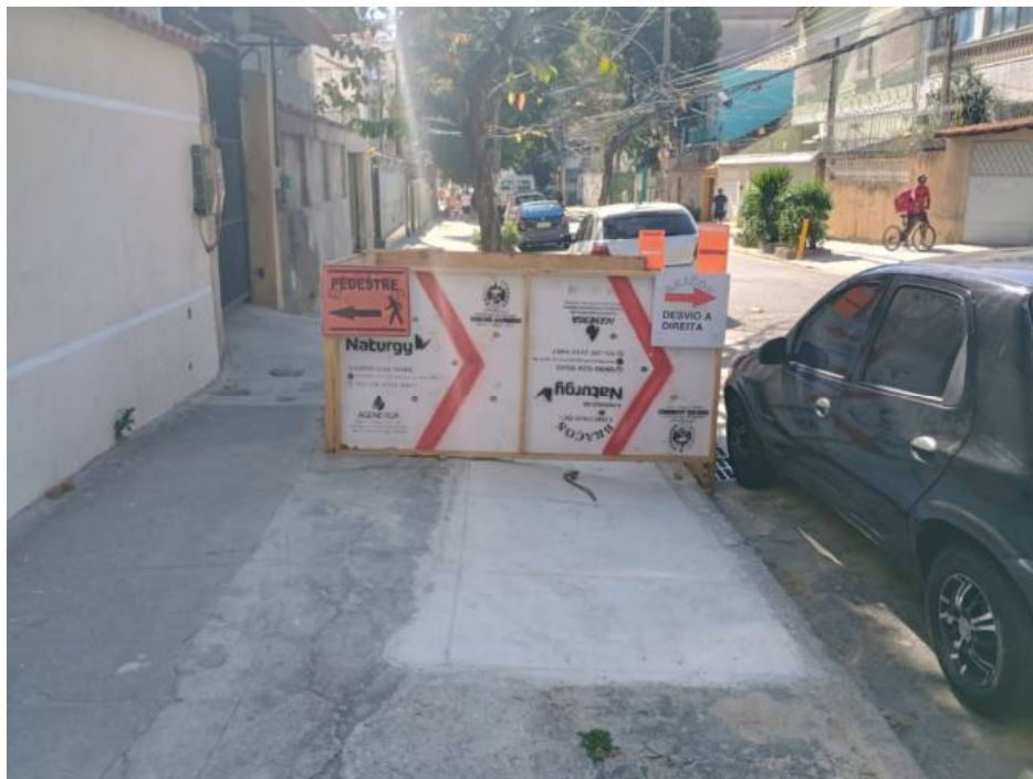
Foto 3: trecho da obra na Rua Carolina Santos, próximo à Rua Visconde de Taunay.
