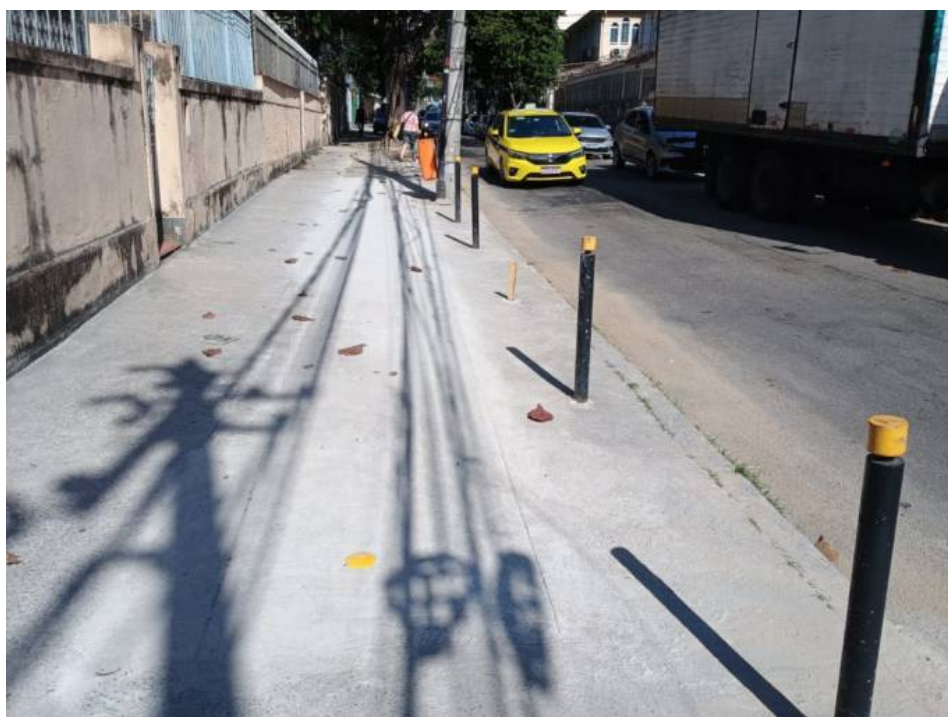
Foto 8: marcos planos instalados.
