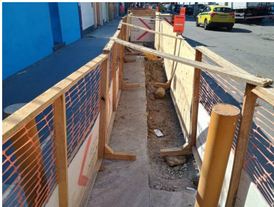
Foto 5: trecho de assentamento da nova rede de polietileno.
