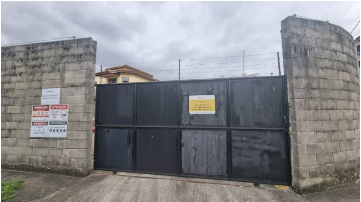
Foto 1: Portão de entrada e placa de identificação da estação GNC de PEQUENO PORTE MANGARATIBA.
