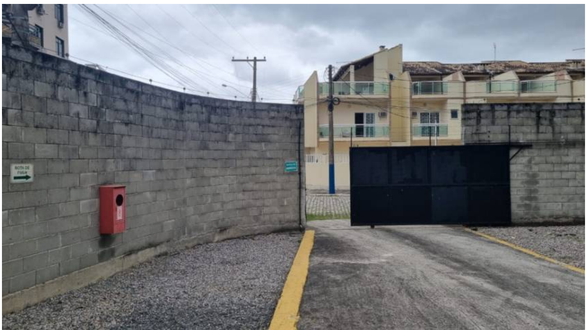
Foto 12: Saída de emergência e extintor protegido contra intempéries.
