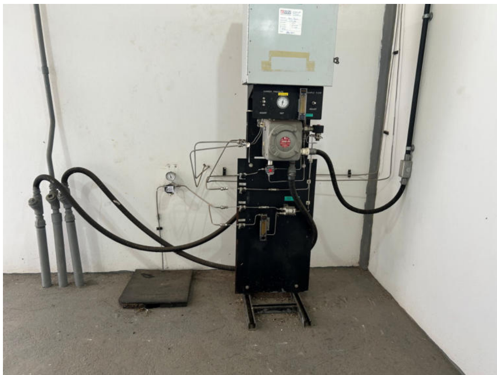
Foto 14: Cromatógrafo da estação.
