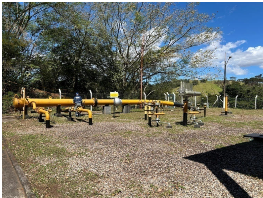
Foto 10: Funcionário da Concessionária corrigindo o sentido das setas de fluxo.
