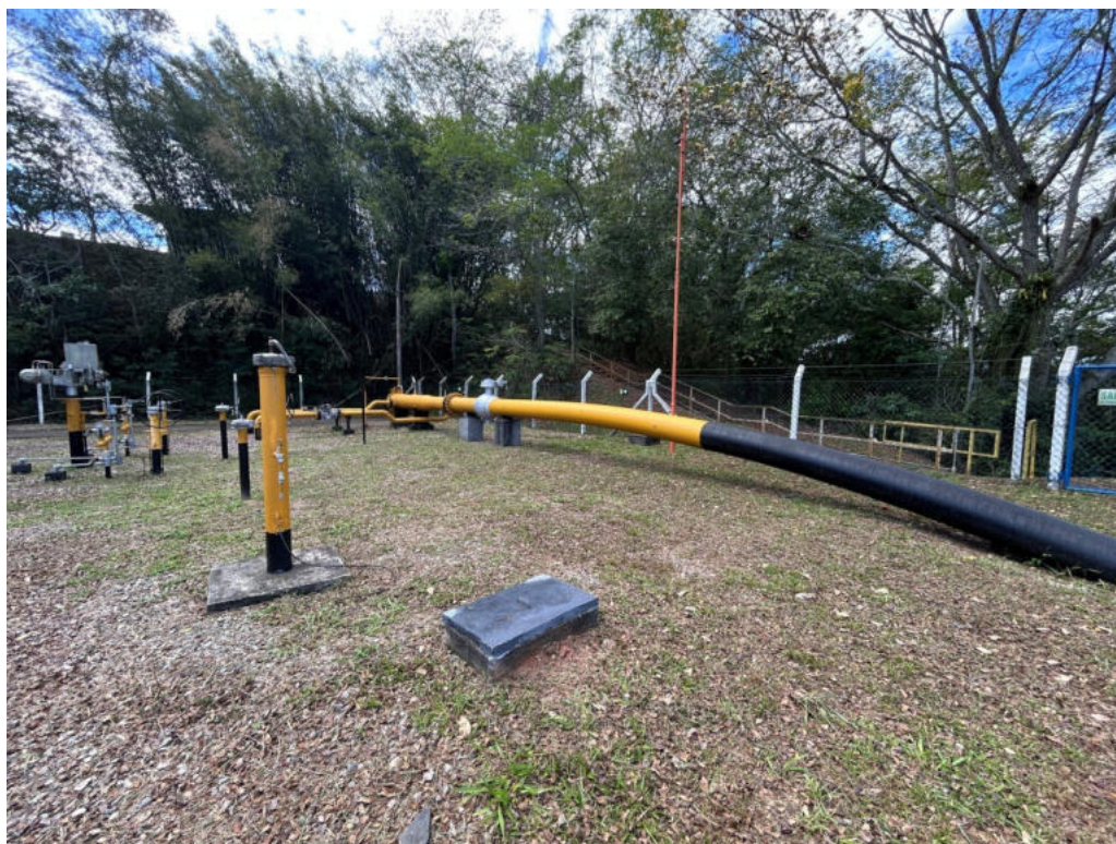
Foto 9: Canhão receptor de PIG.
