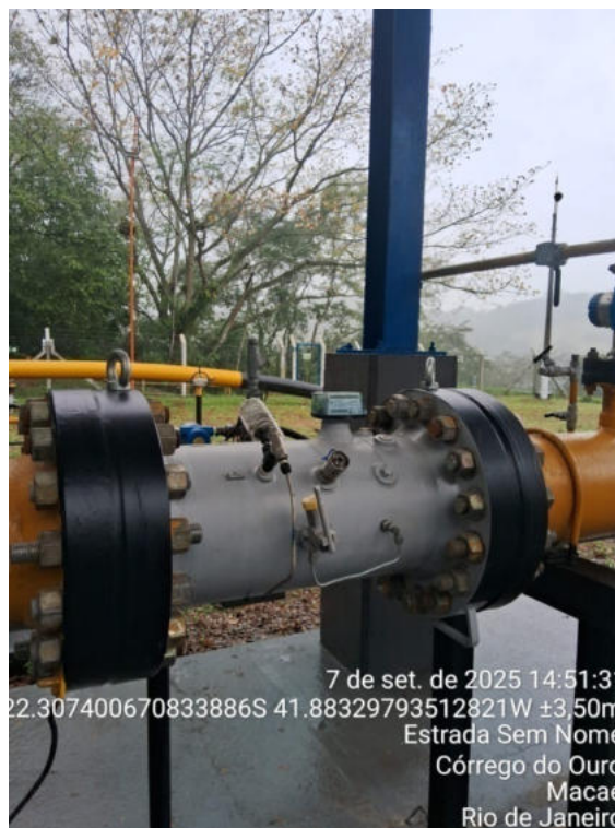
Foto 8: Fita de proteção reposta na turbina (foto enviada pelo representante da Concessionária).
