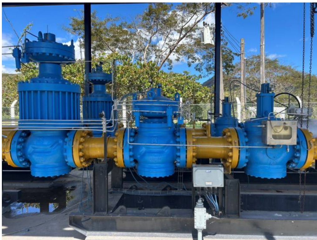
Foto 3: As duas linhas de regulação da estação.
