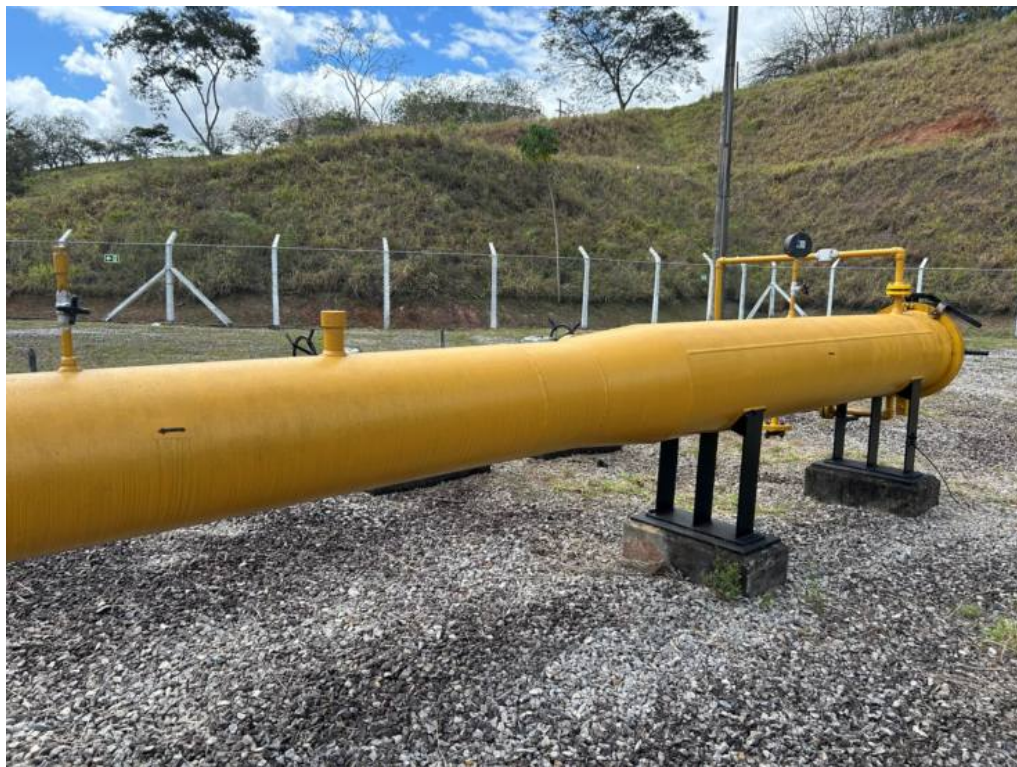
Foto 7: Canhão receptor de PIG com setas de fluxo invertidas.
