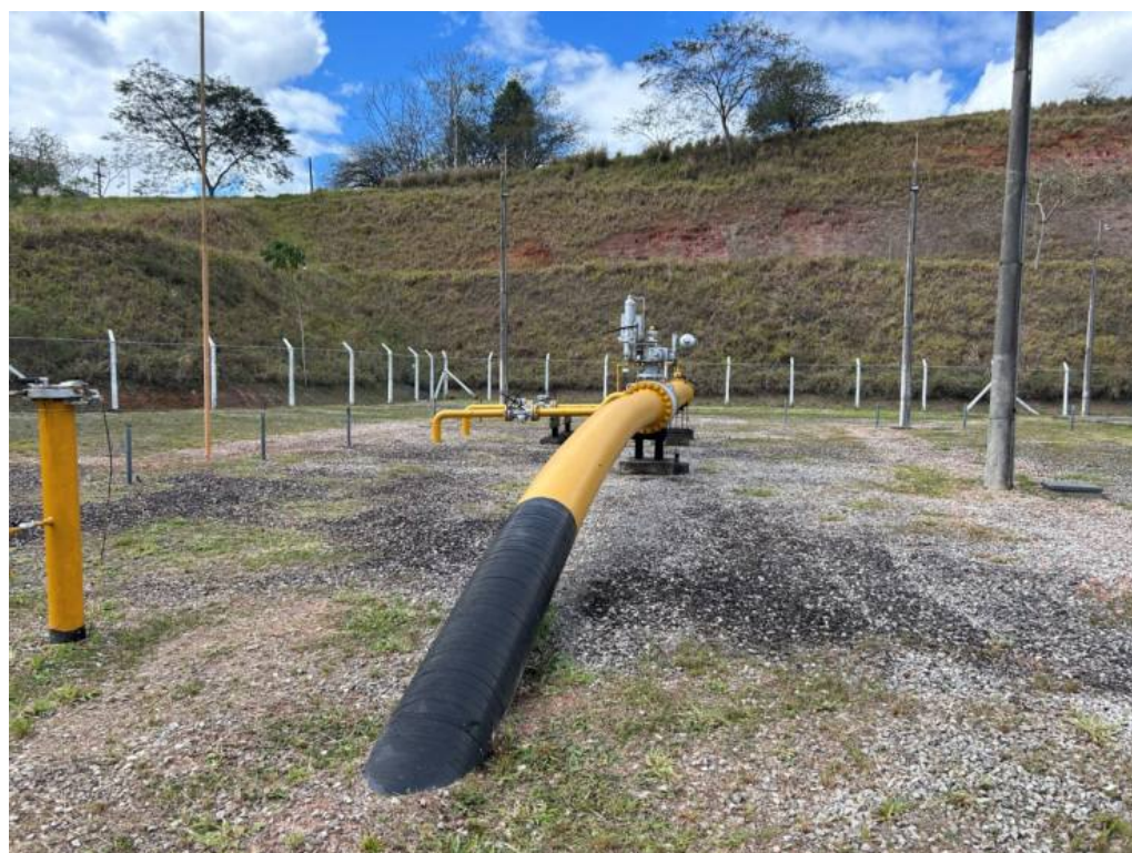
Foto 6: Canhão receptor de PIG.
