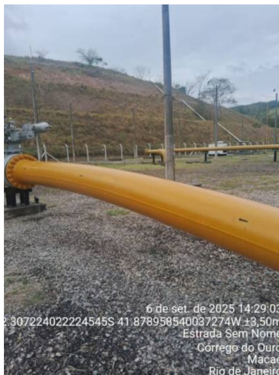
Foto 8: Canhão receptor de PIG com setas ajustadas (foto enviada pelo representante da Concessionária).
