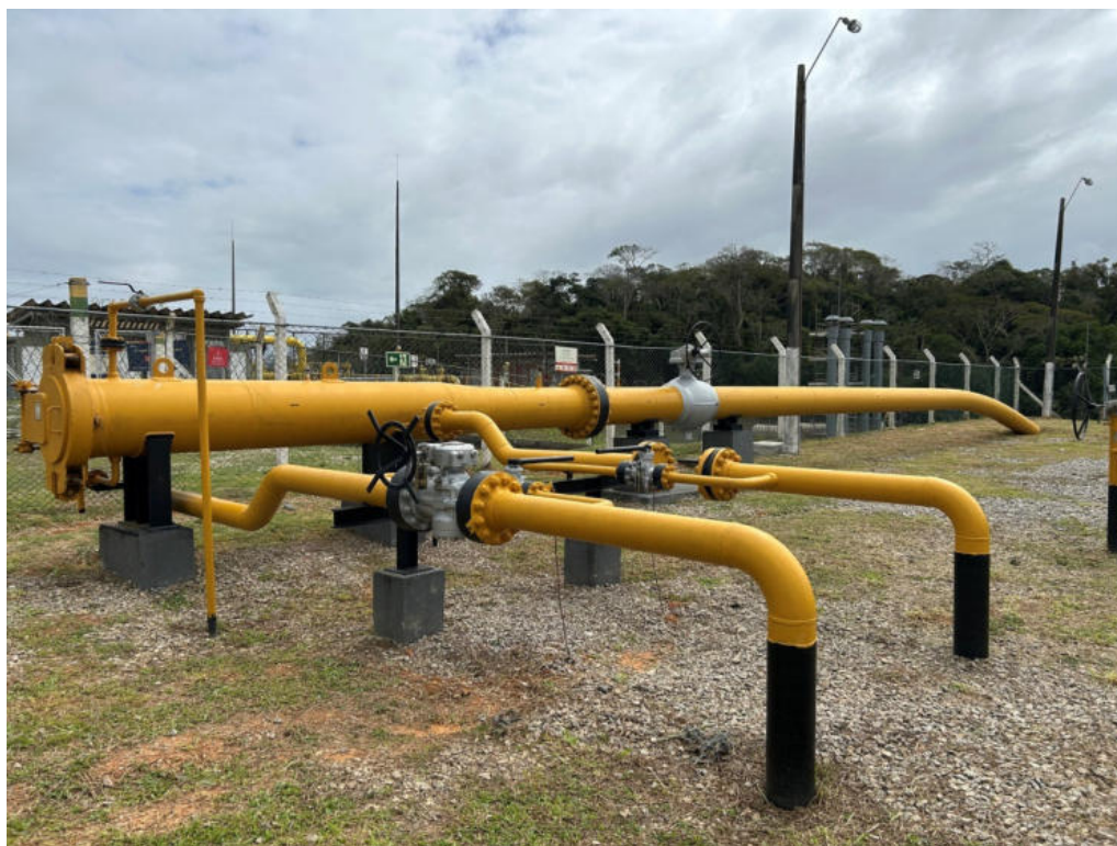
Foto 5: Canhão lançador de PIG para a UTE Norte-Fluminense.
