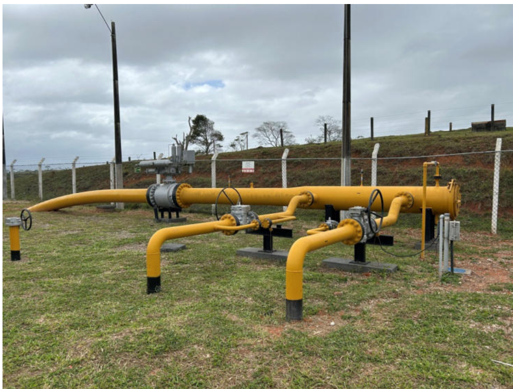
Foto 3: Canhão lançador de PIG para a UTE Mário Lago.
