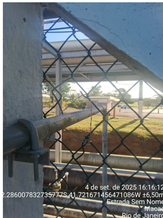
Foto 6: Falha na cerca reparada (foto enviada pelo representante da Concessionária).
