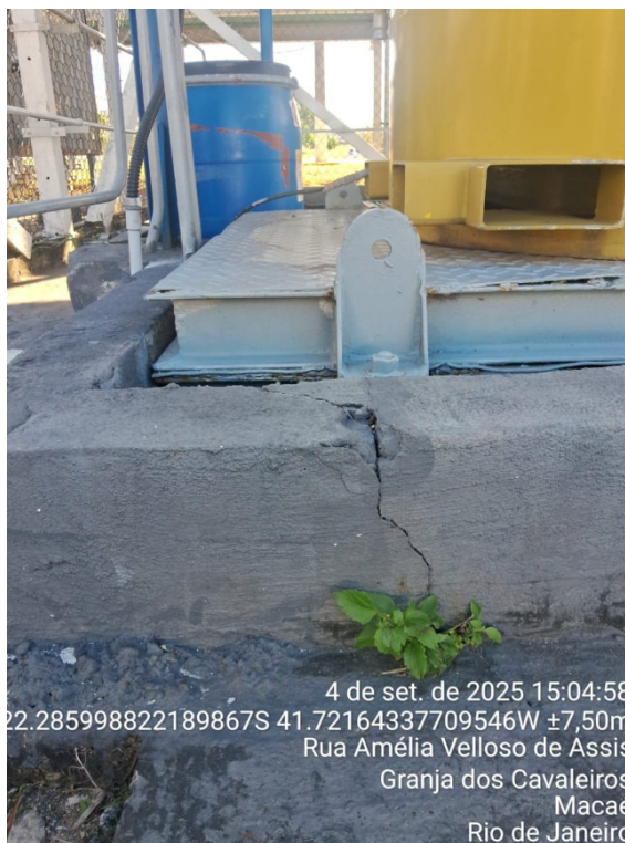
Foto 3: Rachamento na mureta do sistema de odorização (foto enviada pelo representante da Concessionária).
