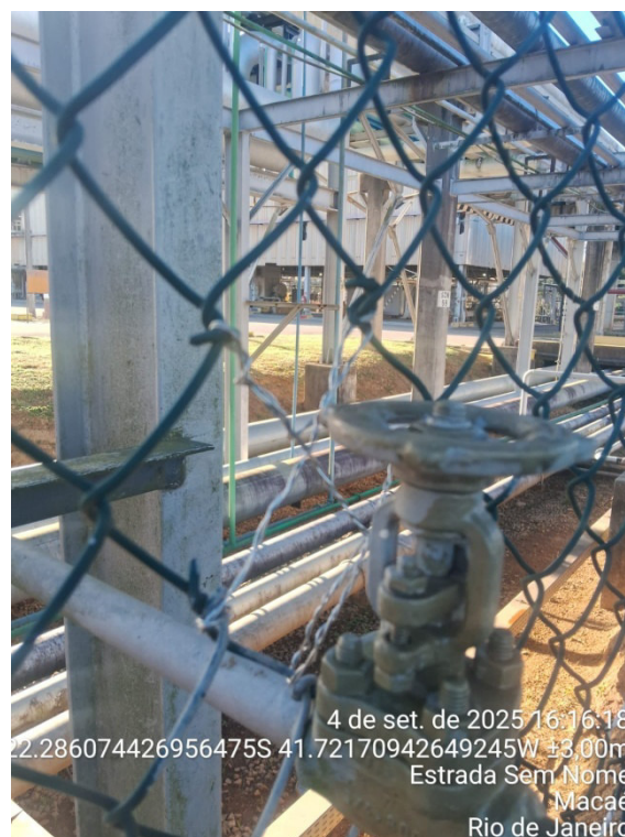
Foto 8: Falha na cerca reparada (foto enviada pelo representante da Concessionária).
