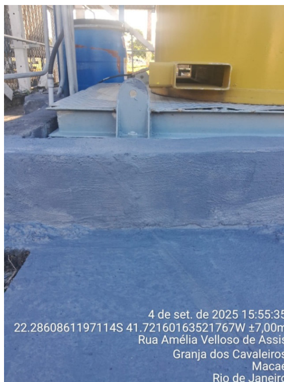
Foto 4: Rachamento na mureta reparado (foto enviada pelo representante da Concessionária).
