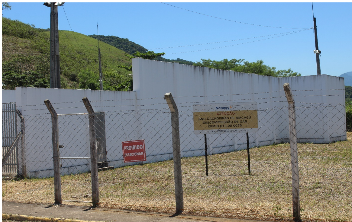
Foto 1: Placa de identificação da estação
