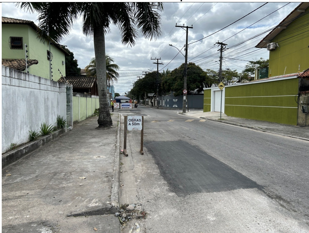
Foto 4: Aviso de obras a 50 metros e trecho recomposto da via.
