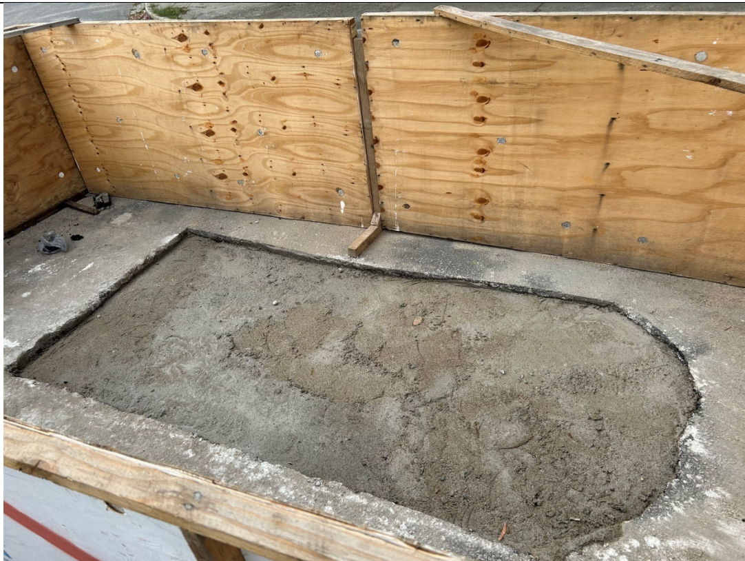
Foto 3: Abertura na via ainda não recomposta.
