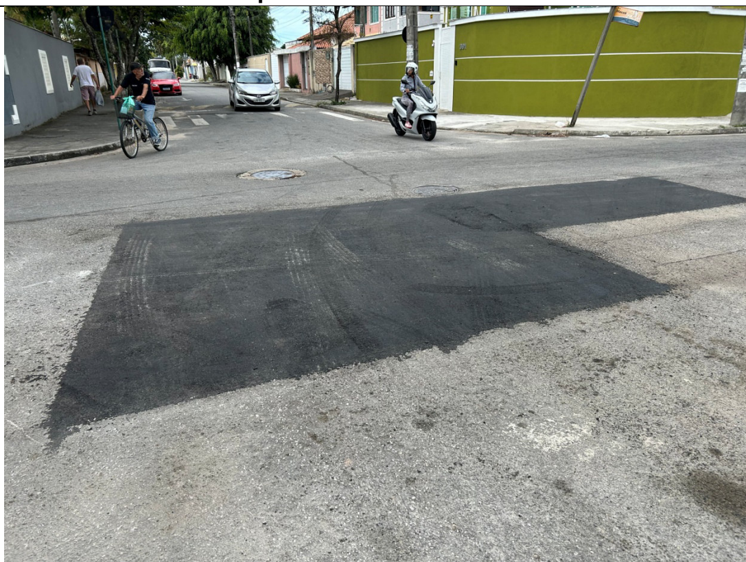
Foto 6: Área da via recomposta após rompimento de tubulação de esgoto.
