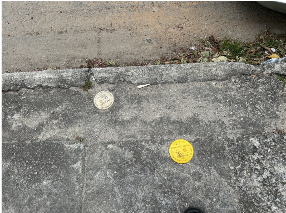
Foto 11: Marco plano novo instalado ao lado de marco da rede antiga.
