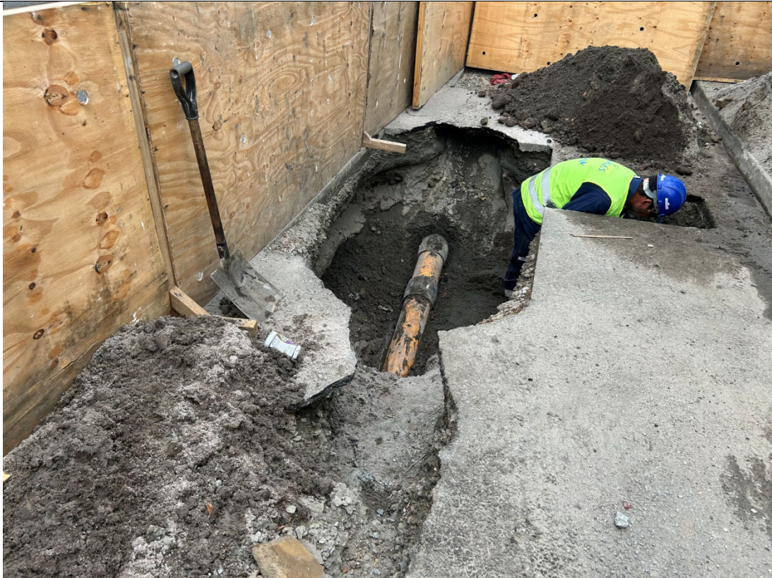
Foto 9: Trecho final da obra em execução, com extremidade final da tubulação visível na vala aberta.
