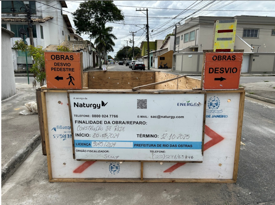
Foto 1: Identificação da obra e sinalizações.
