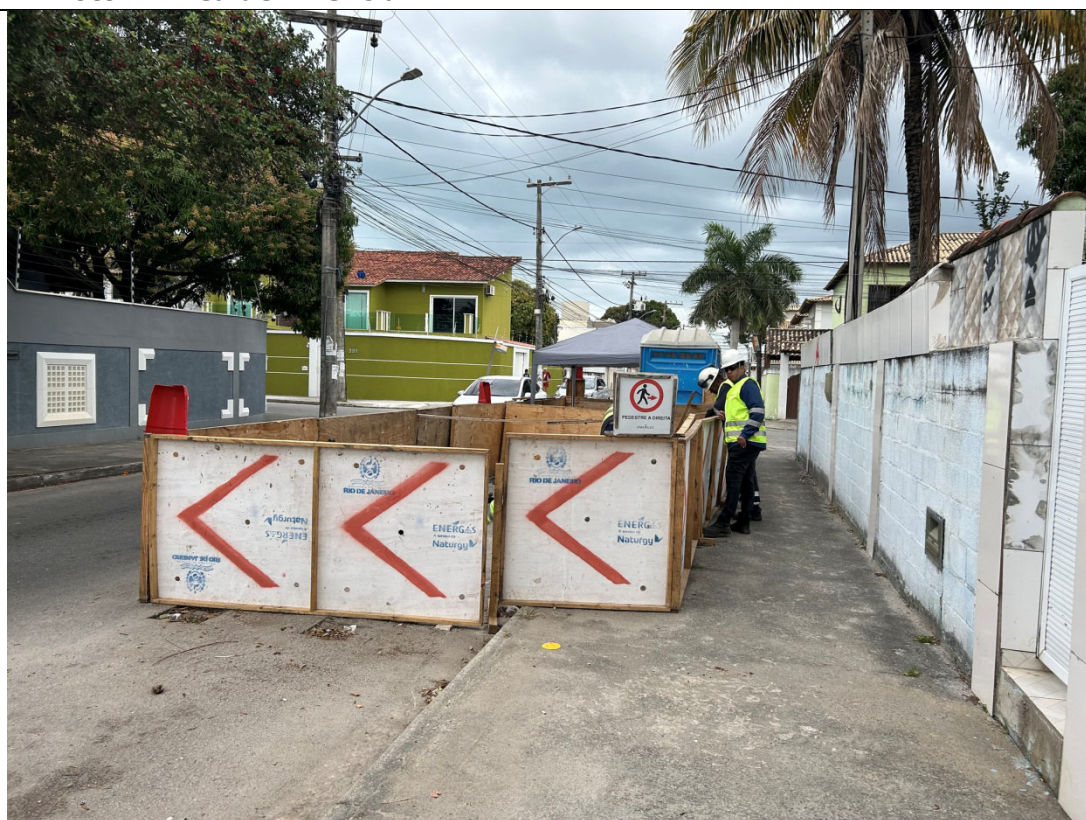
Foto 8: Ponto atual de avanço da obra.
