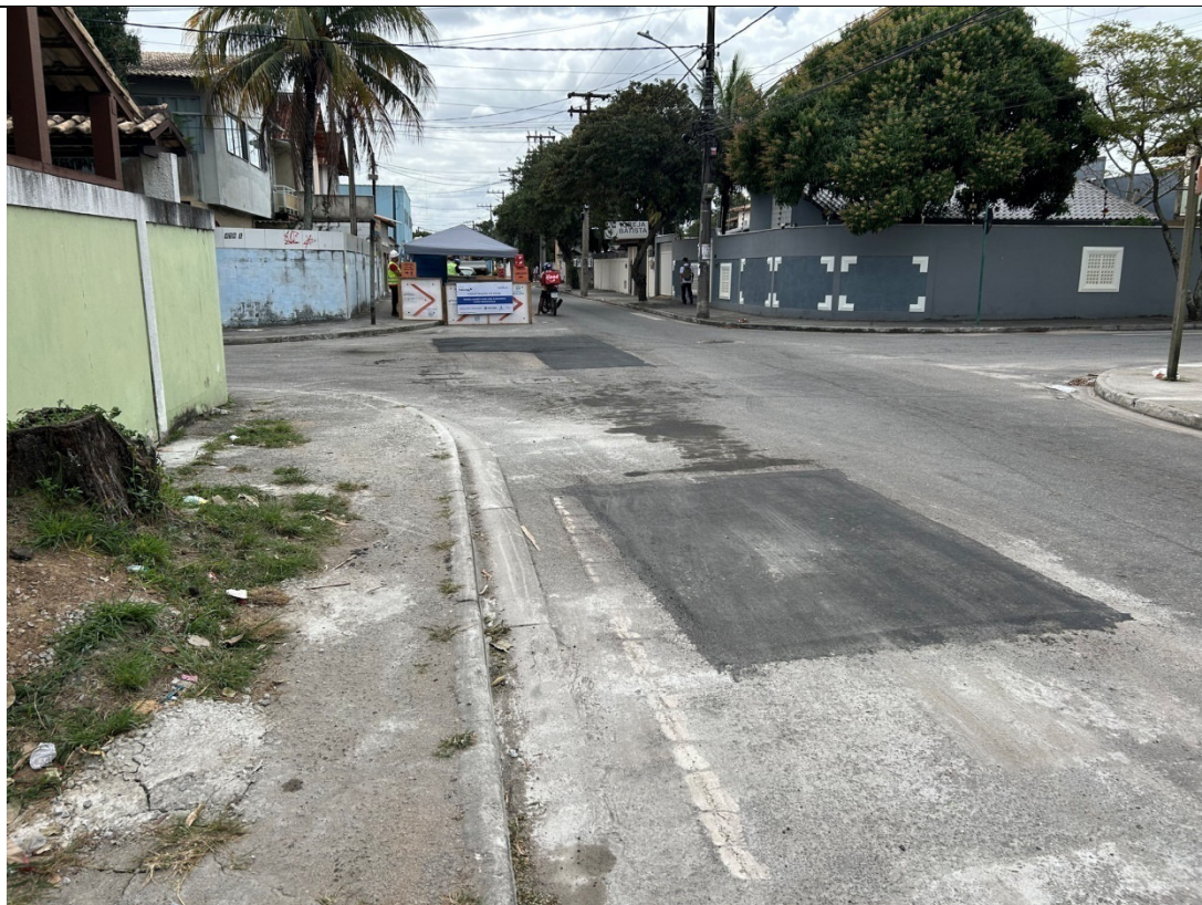
Foto 5: Trechos recompostos da via e local de vivência ao fundo.
