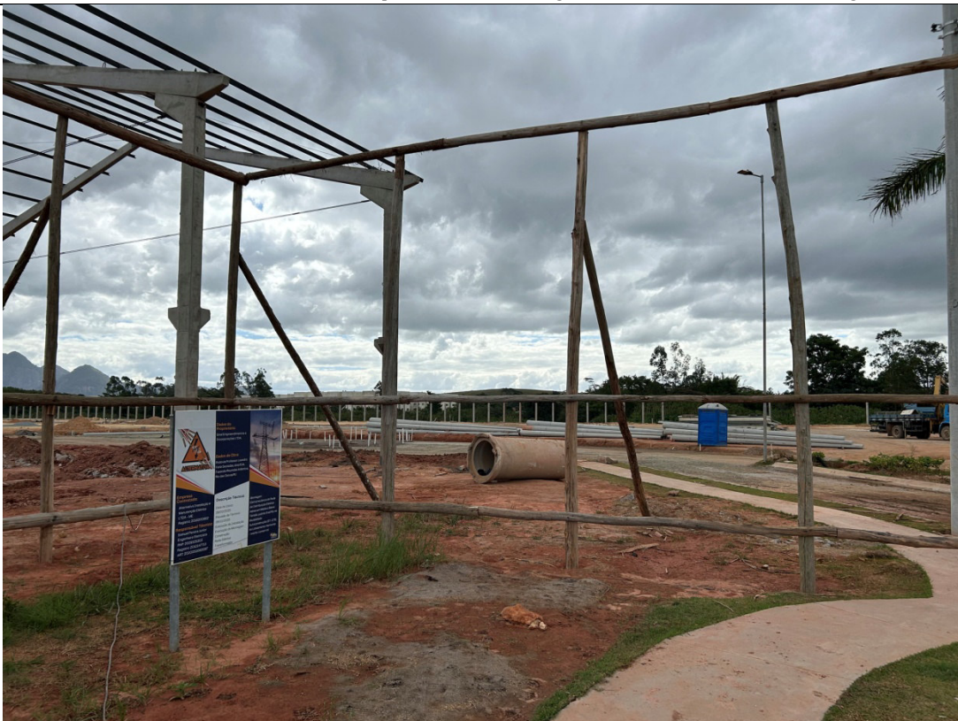
Foto 2: Vista do Bairro Harmonia em construção.
