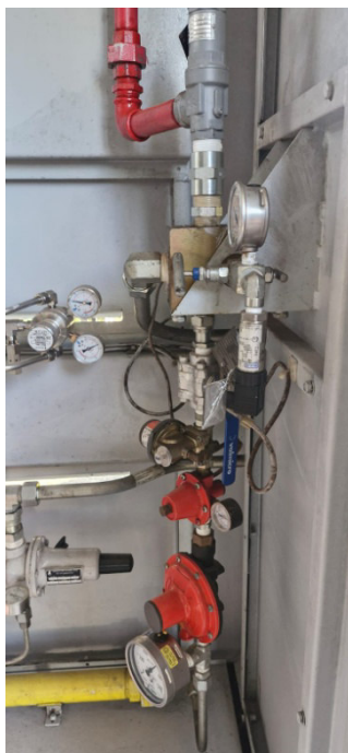
Foto 5: Regulagem dentro do RCU para alimentar o gerador.
