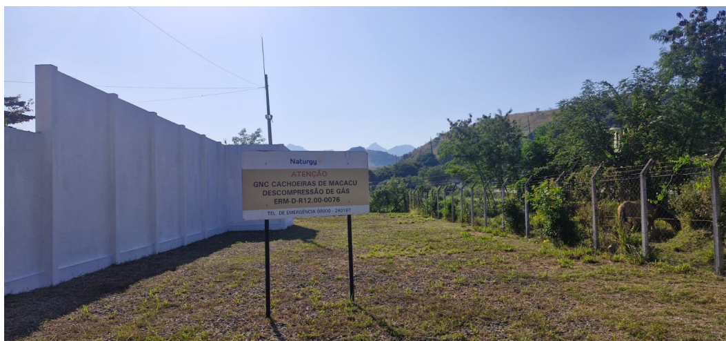
Foto 1: Identificação da Estação de Descompressão - Cachoeiras de Macacu .
