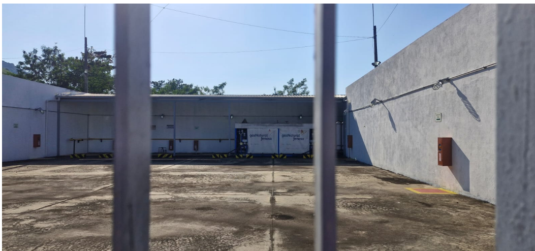
Foto 3: Pátio da Estação de Descompressão.
