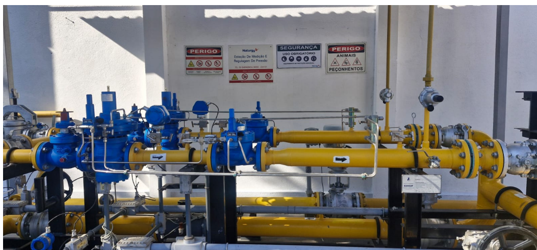
Foto 4: Estação de Medição e Regulagem de Pressão .
