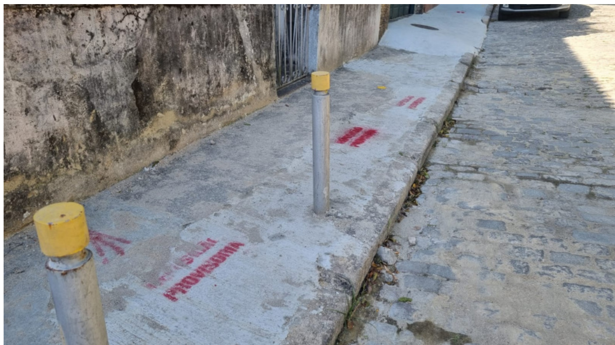
Foto 2: Trecho de recomposição provisória no calçamento da rua.
