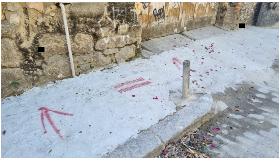
Foto 3: Trecho de recomposição provisória no calçamento da rua.
