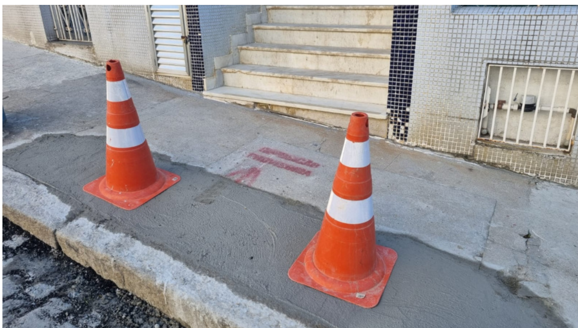
Foto 4: Trecho de recomposição provisória no calçamento da rua sinalizado com cones.
