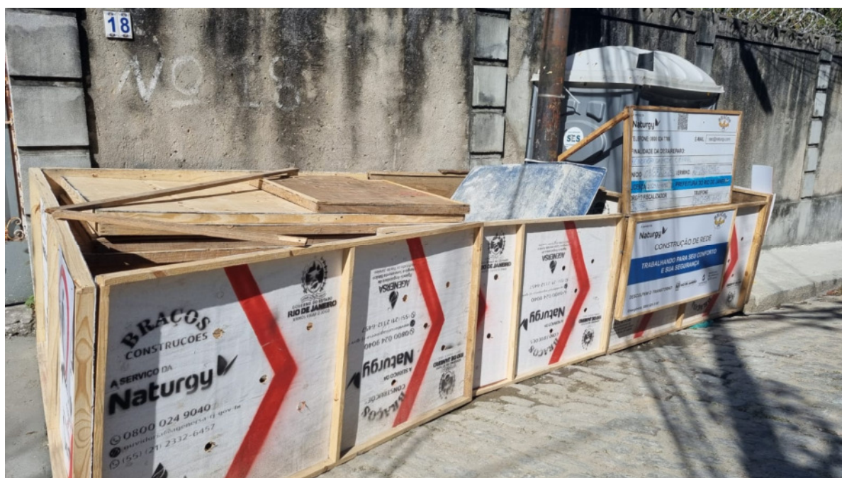
Foto 7: Área de armazenamento de material.
