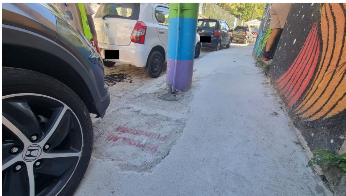
Foto 5: Trecho de recomposição provisória no calçamento – local teve muita influência de pedestres e carros estacionados.
