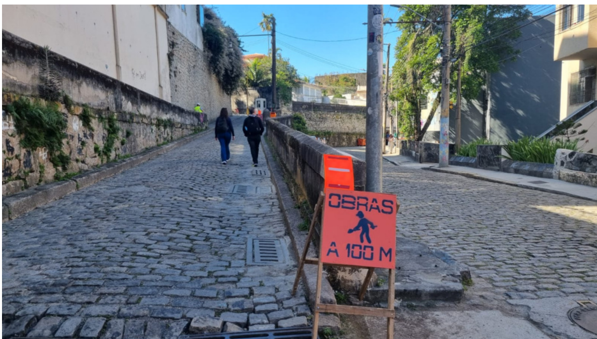
Foto 11: Placa de aviso de obra.
