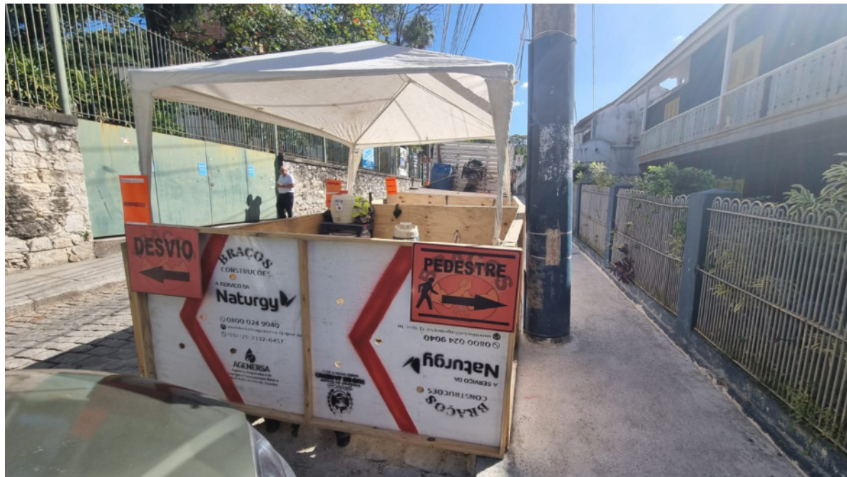
Foto 6: Local de vivência, placas de desvio de trânsito e de pedestres e sinalização noturna.
