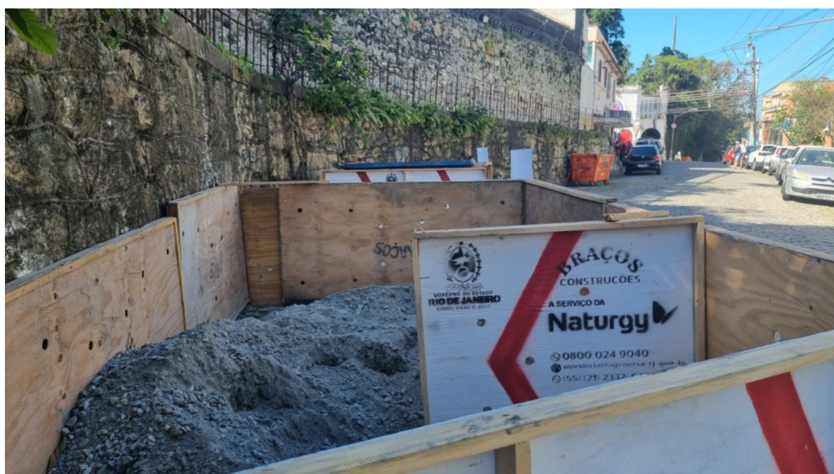
Foto 8: Área de armazenamento de material.
