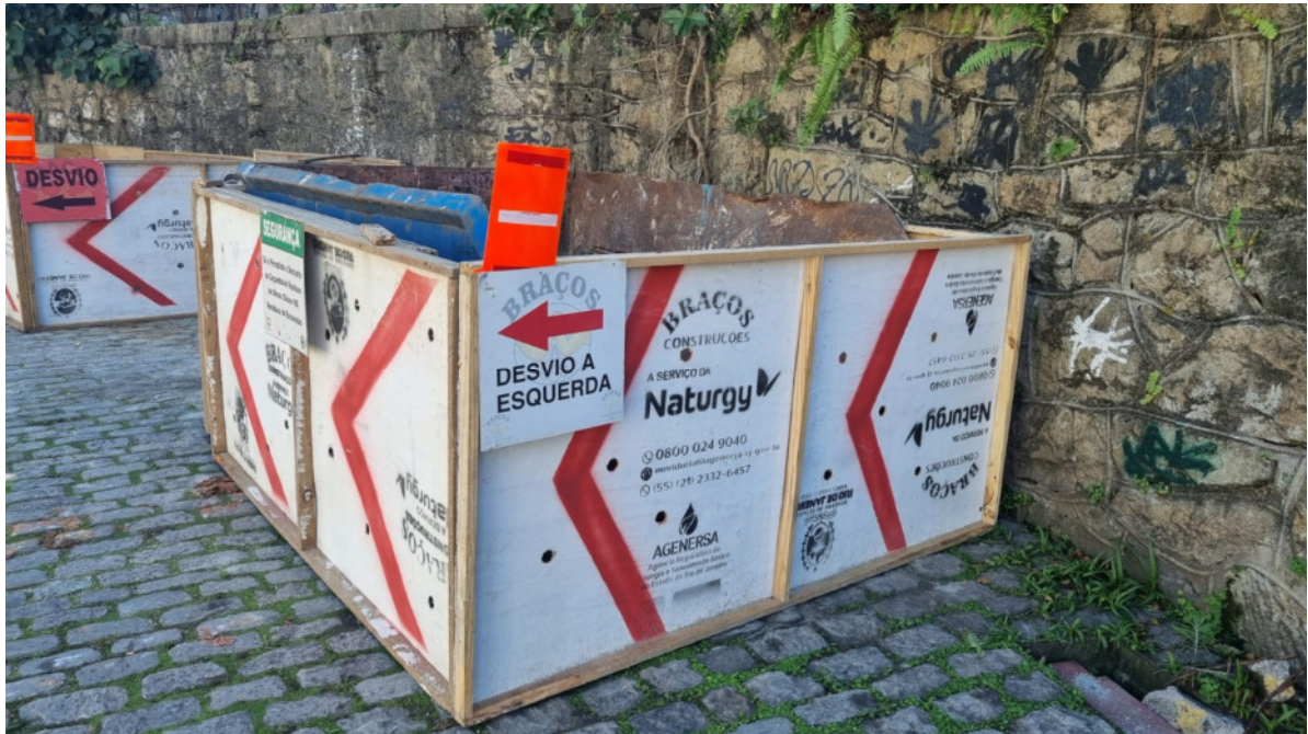
Foto 9: Área de descarte de material com placa de desvio de trânsito e sinalização noturna.
