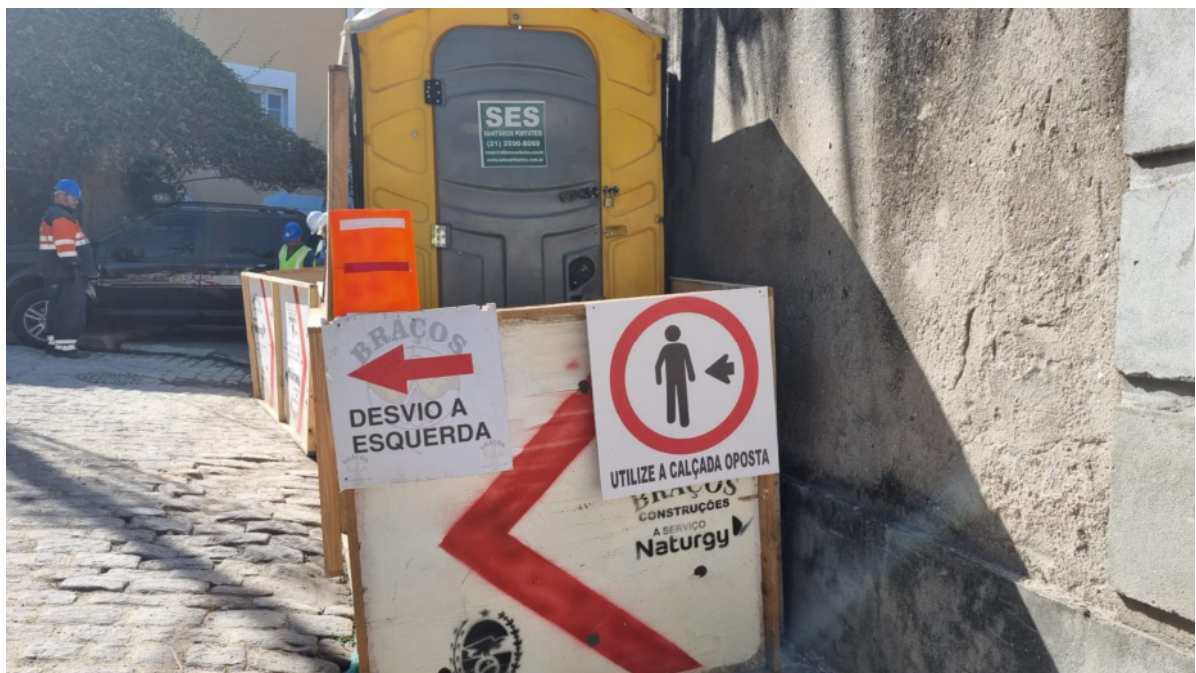
Foto 10: Placas de desvio de pedestre e de trânsito e sinalização noturna.
