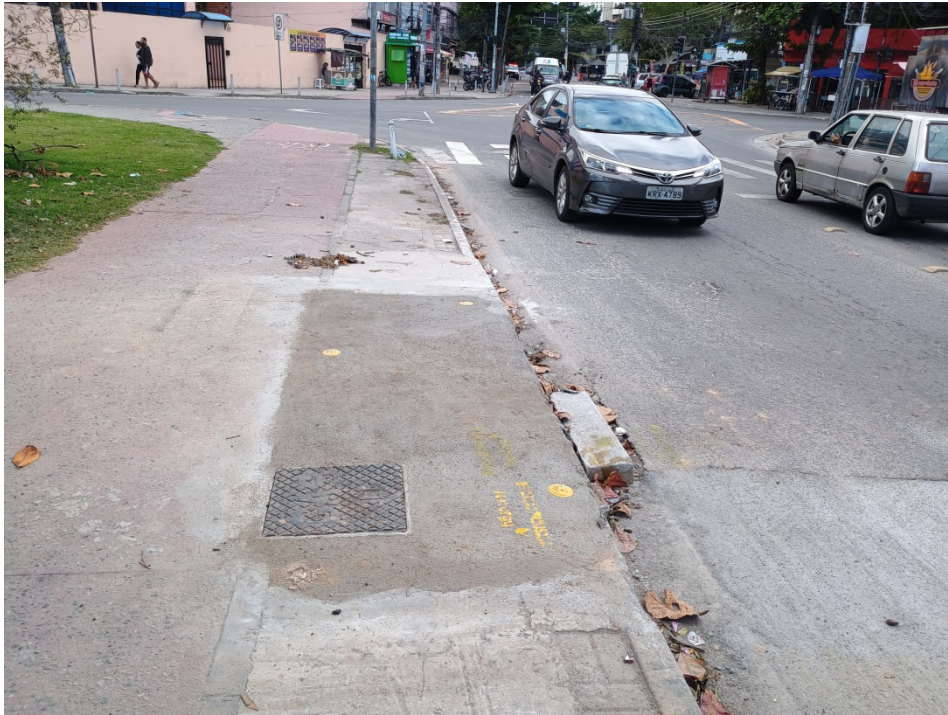
Foto 3: início da obra na Estrada Rodrigues Caldas.
