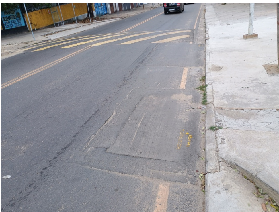
Foto 8: trecho de recomposição provisória.
