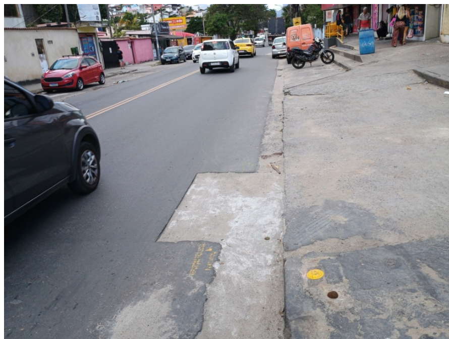
Foto 5: tubulação assentada na Estrada Outeiro Santo.
