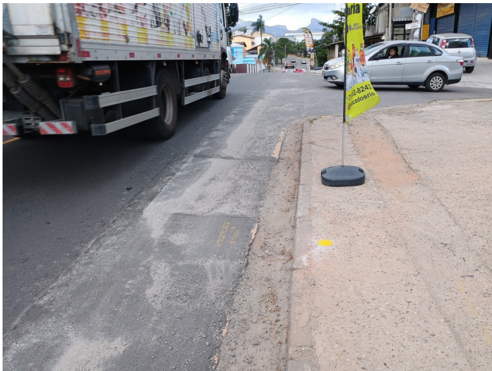
Foto 4: tubulação assentada na Estrada Outeiro Santo.
