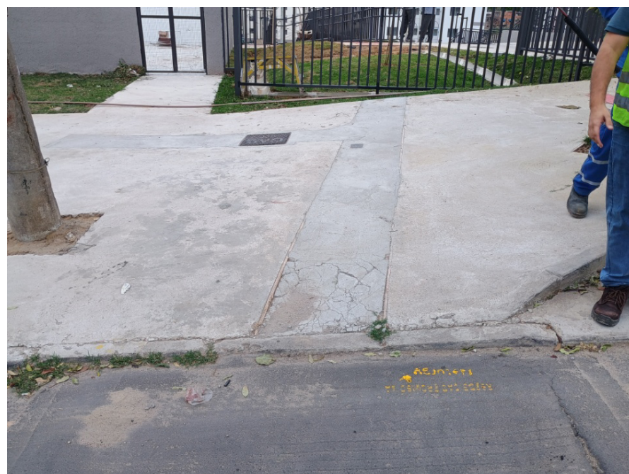
Foto 6: ponto de interligação na Estrada Outeiro Santo com o Condomínio Soul.
