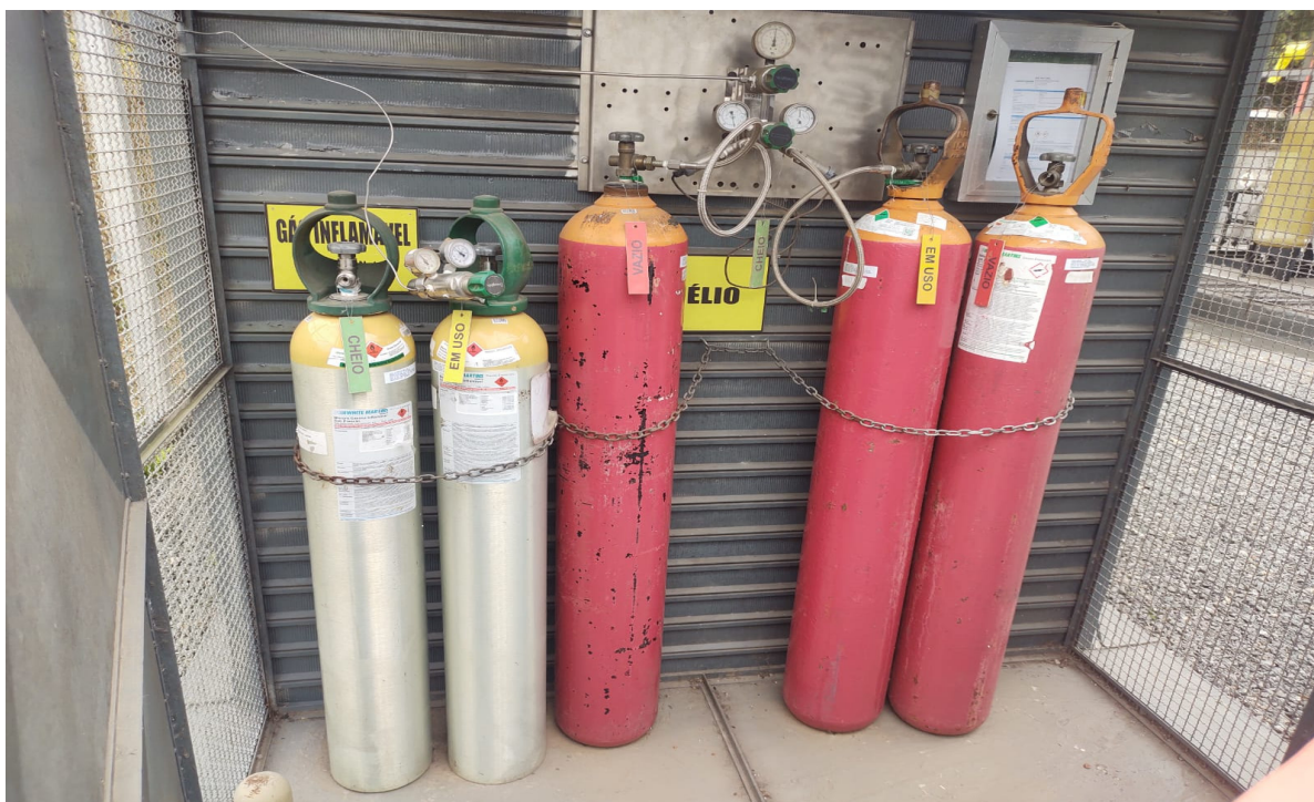
Foto 8: Gases utilizados pelo sistema de cromatografia.
