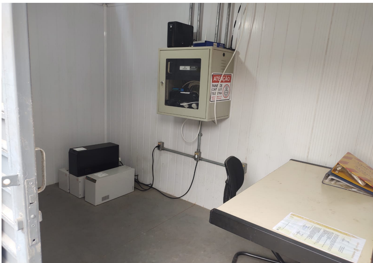
Foto 7: Sistema de telemetria e nobreak.
