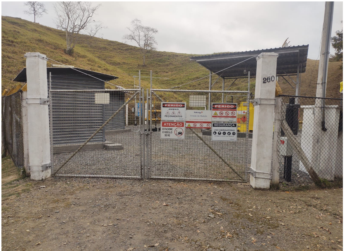
Foto 2: Portão de acesso e placas de sinalização de segurança.
