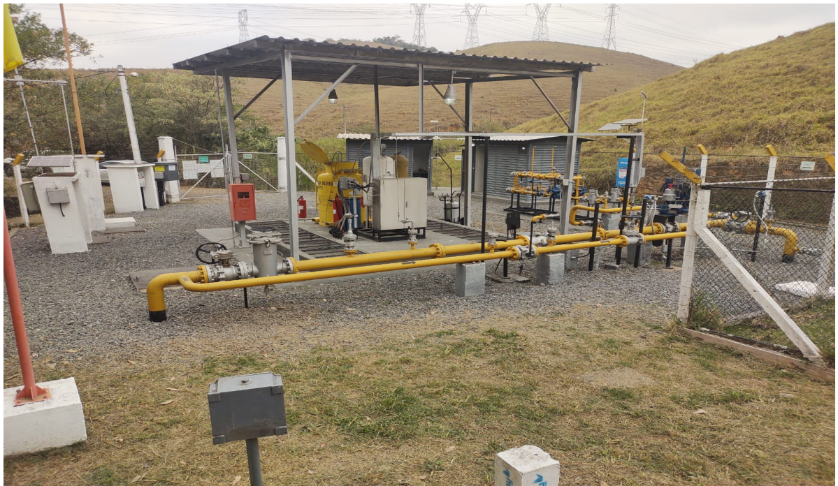
Foto 1: Vista da Estação.
