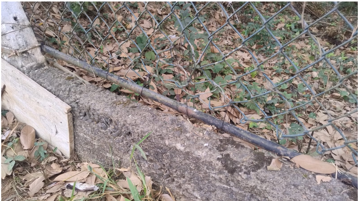
Foto 14: Reparo da cerca.
