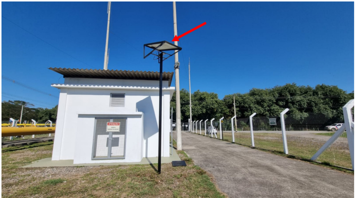
Foto 10: Vista da parte de trás da estação, com destaque para o painel fotovoltaico.
