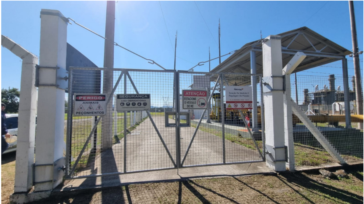
Foto 3: Portão de entrada e placas de sinalização de segurança da estação.
