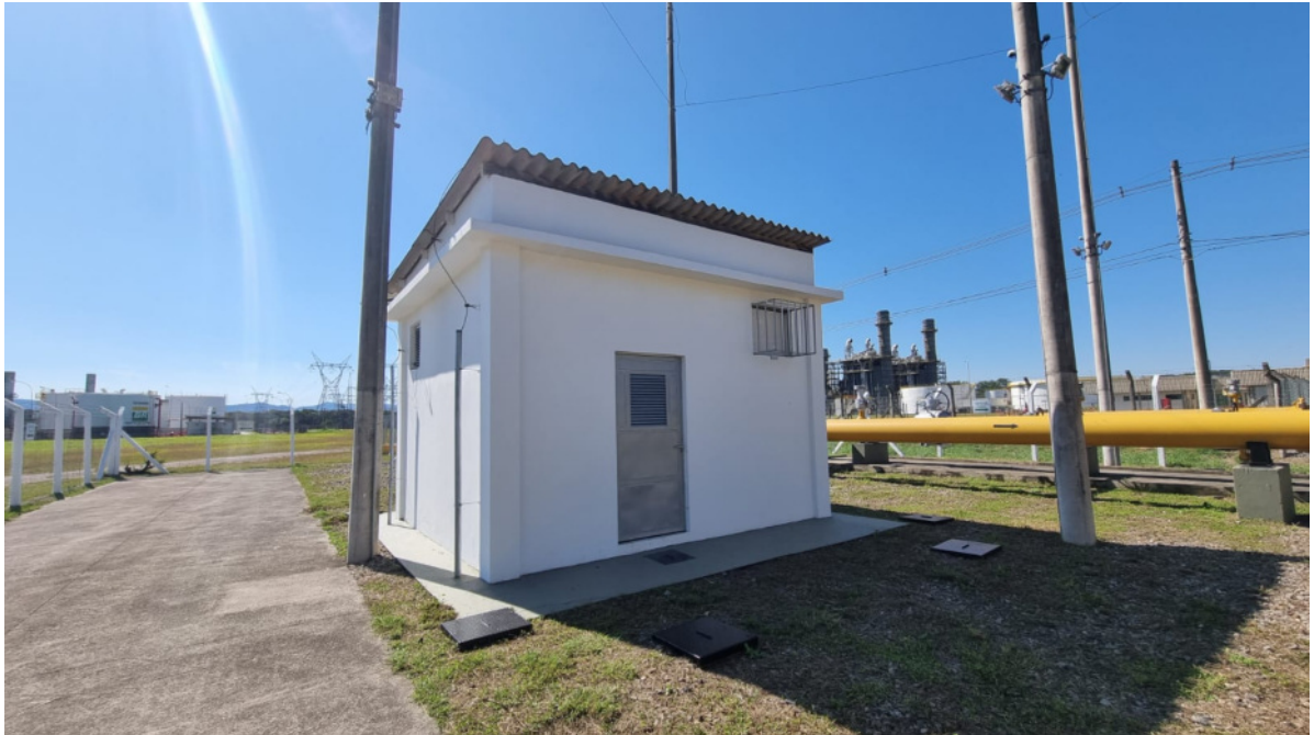
Foto 9: Sala de controle do sistema de telemetria.
