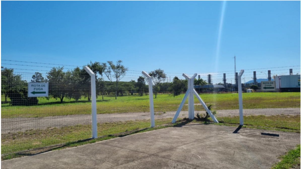
Foto 11: Cerca e sinalização de rota de fuga.
