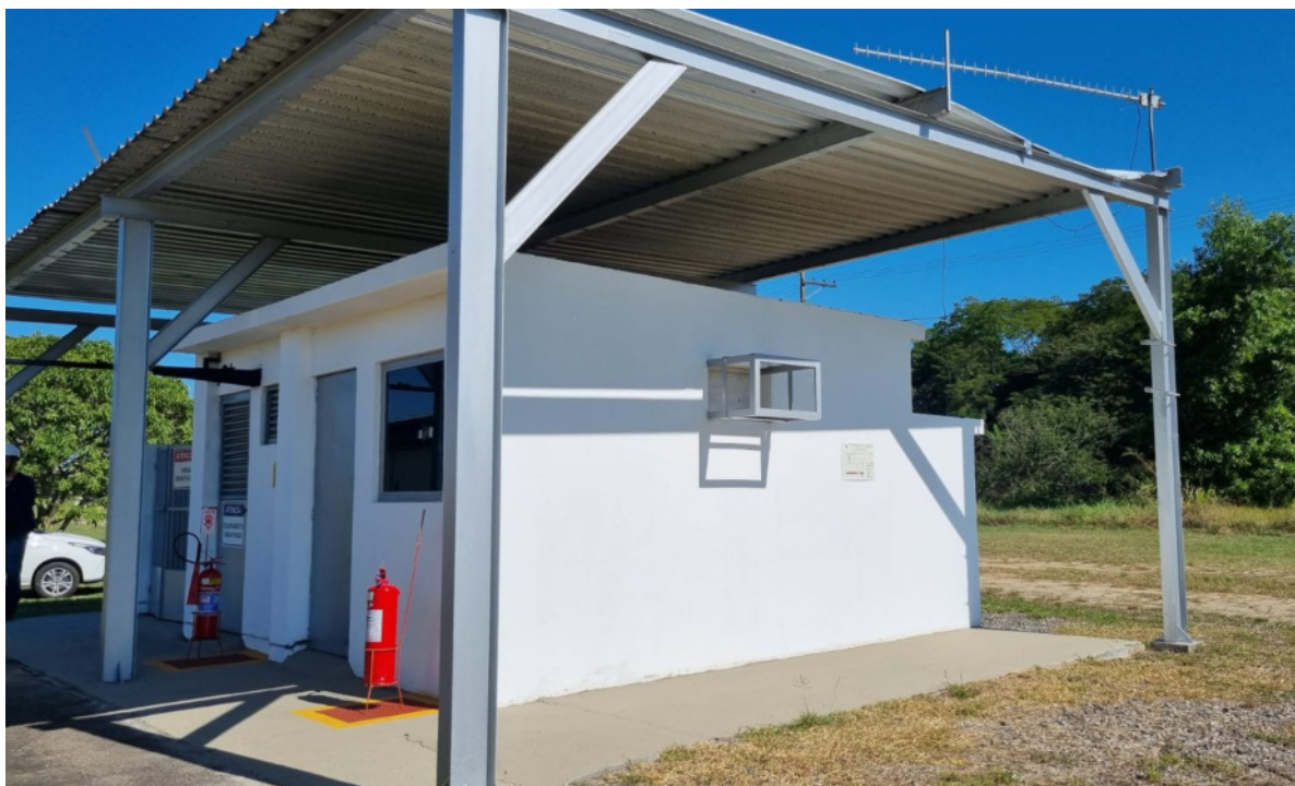
Foto 9: Sala de controle do sistema de telemetria.
