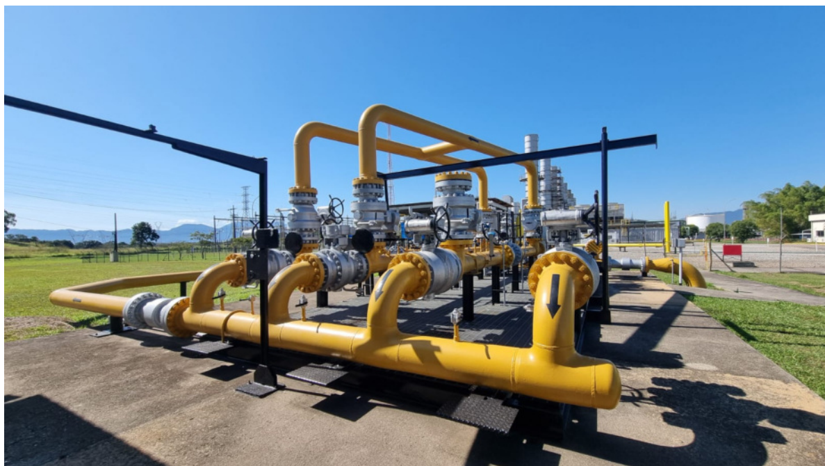
Foto 10: Vista frontal da estação.
