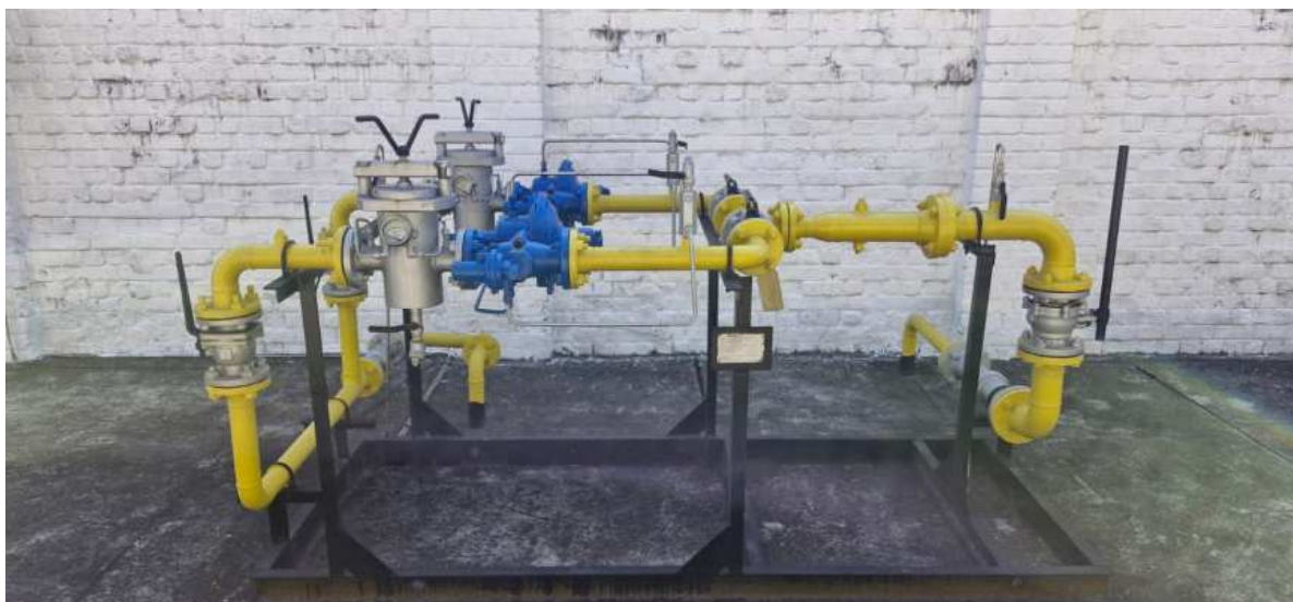
Foto 11: Estação São Cristóvão.
