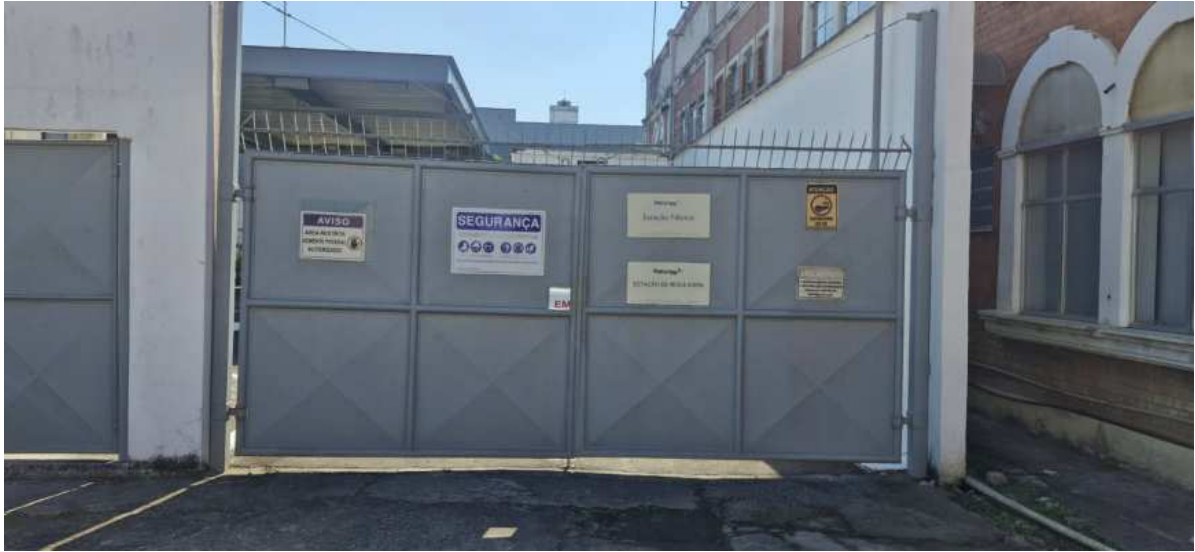
Foto 1: Portão de entrada da estação ERM - Fábrica Nova.
