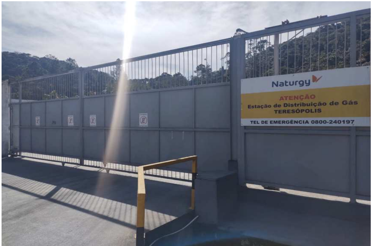
Foto 1: Identificação da estação e sinalização.
