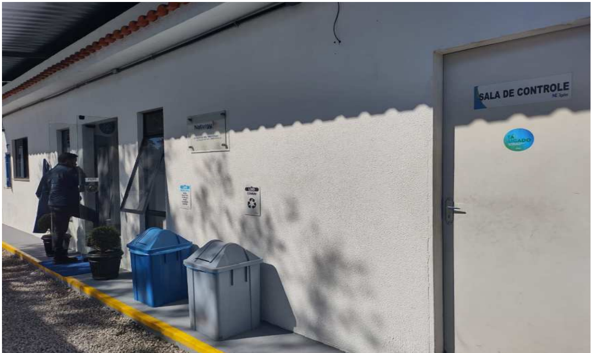
Foto 9: Instalação de comando em alvenaria.
