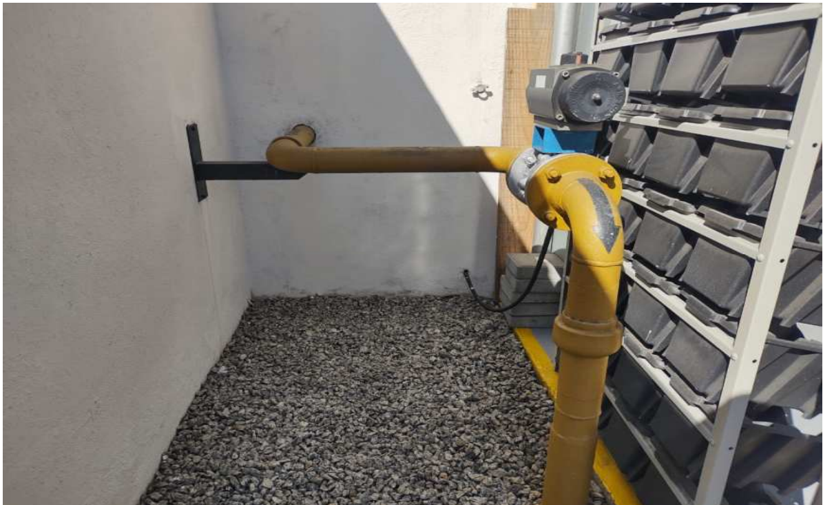
Foto 4: Tubulação de saída das RCU para a ERM da Naturgy.
