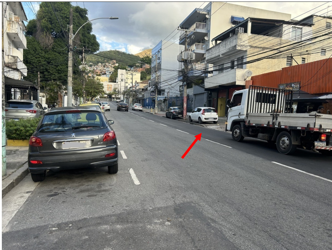
Foto 1: Lado par da via, com solo escavado já recomposto.
