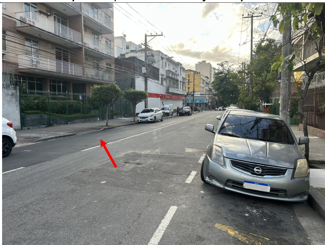
Foto 2: Lado par da via, com solo escavado já recomposto.
