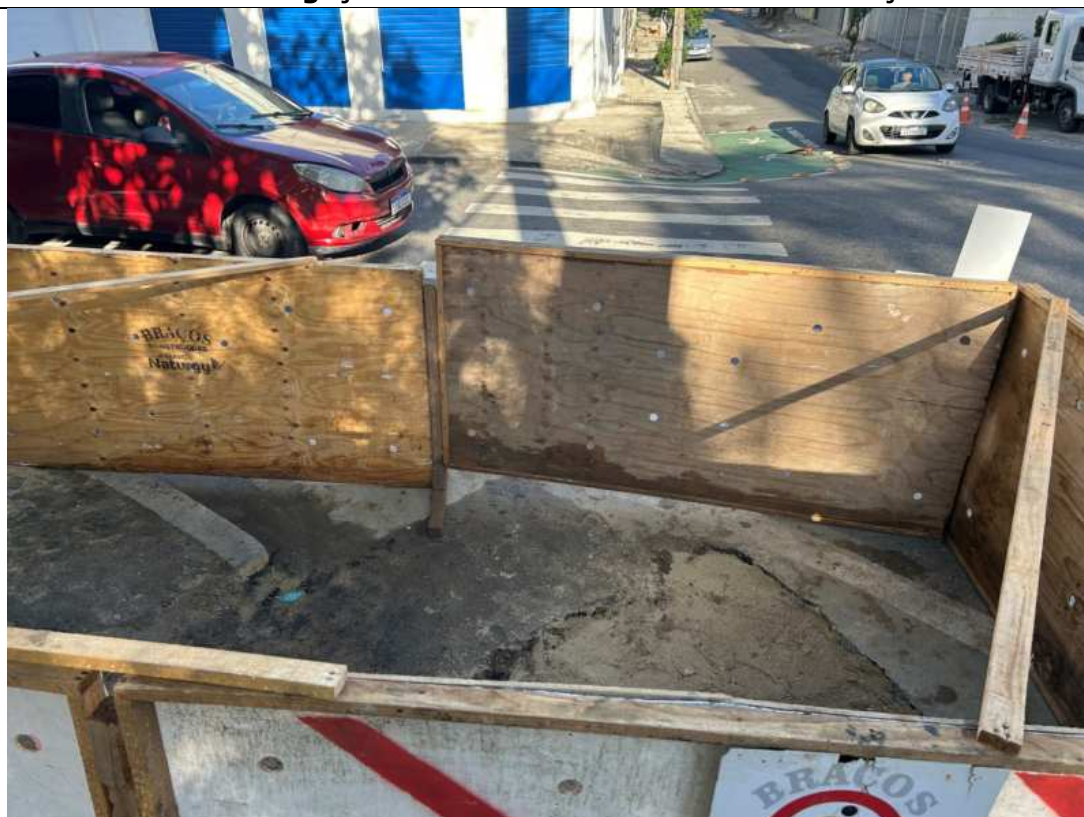
Foto 4: Obra de ligação terminada, faltando recomposição do solo.
