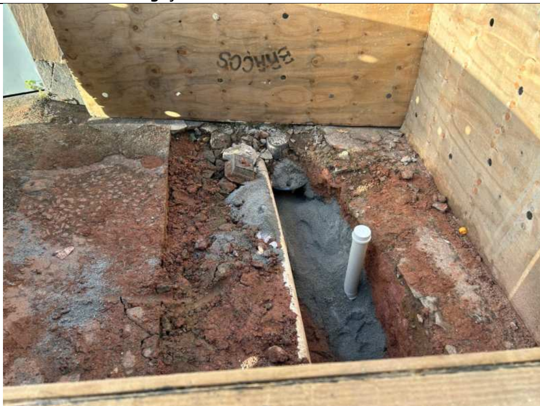
Foto 10: Obra de ligação de ramal ainda em andamento.
