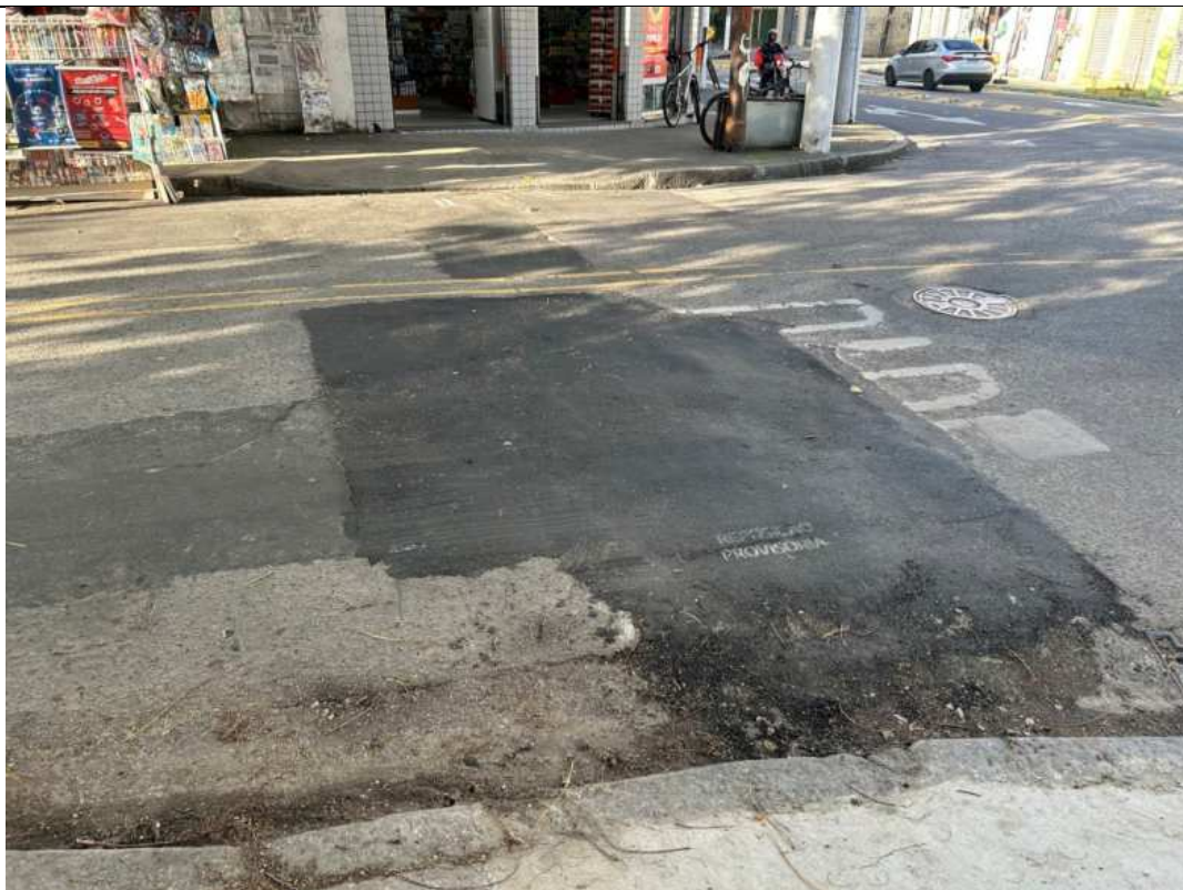
Foto 7: Recomposição provisória da via.
