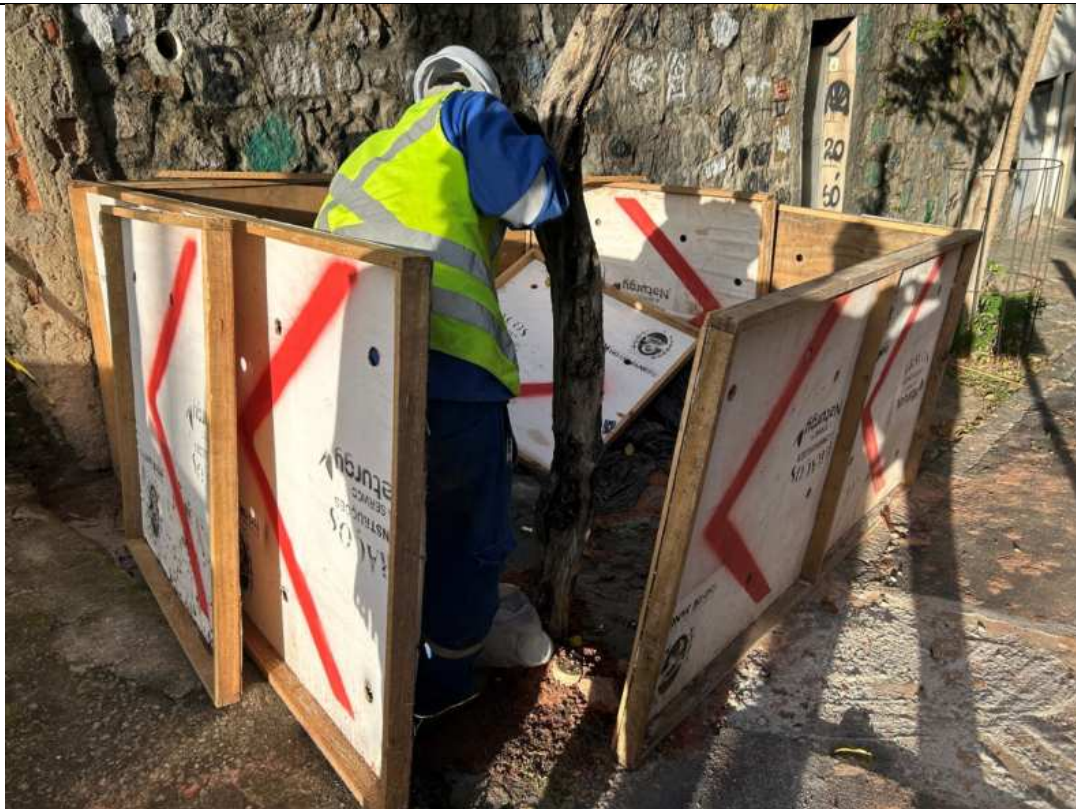
Foto 9: Obra de ligação de ramal ainda em andamento.
