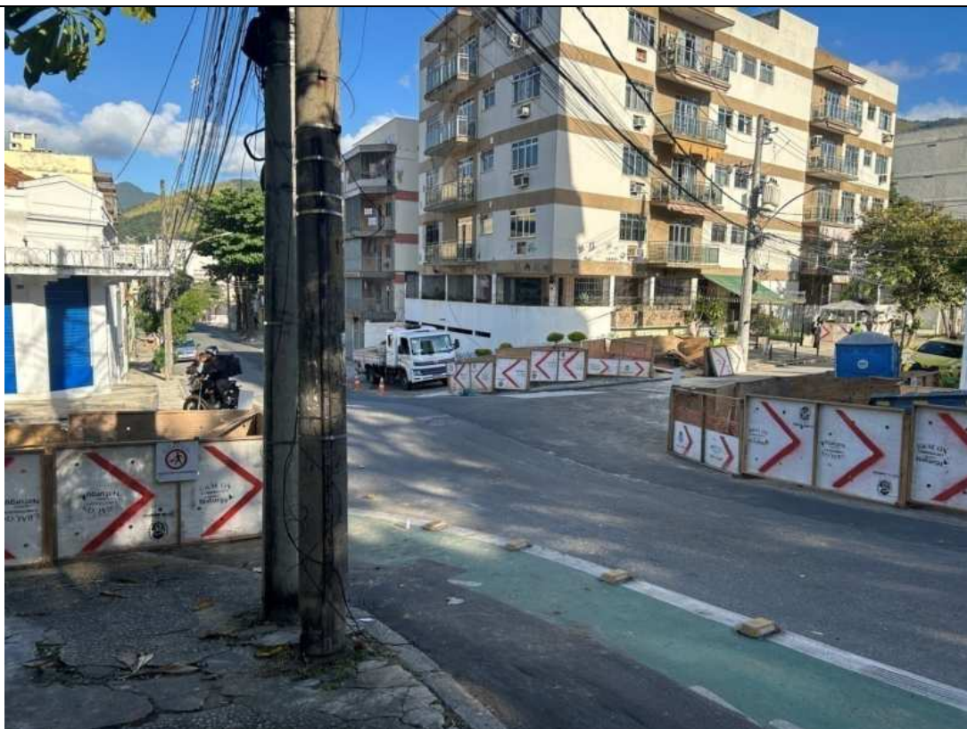
Foto 2: Obras de ligação de rede realizadas em 13/06/2025.
