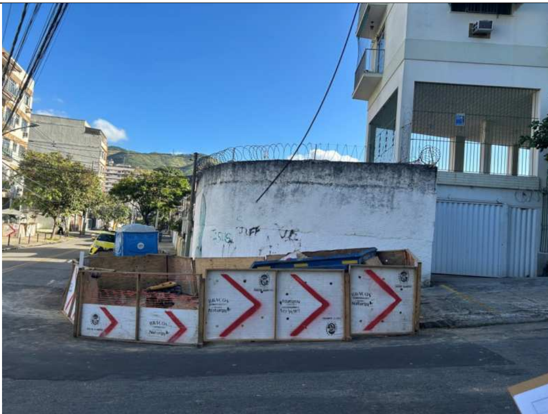
Foto 5: Obra de ligação de rede e área de descarte.
