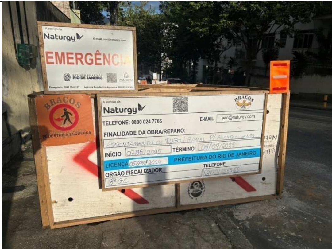
Foto 11: Placa de identificação da obra e sinalizações.
