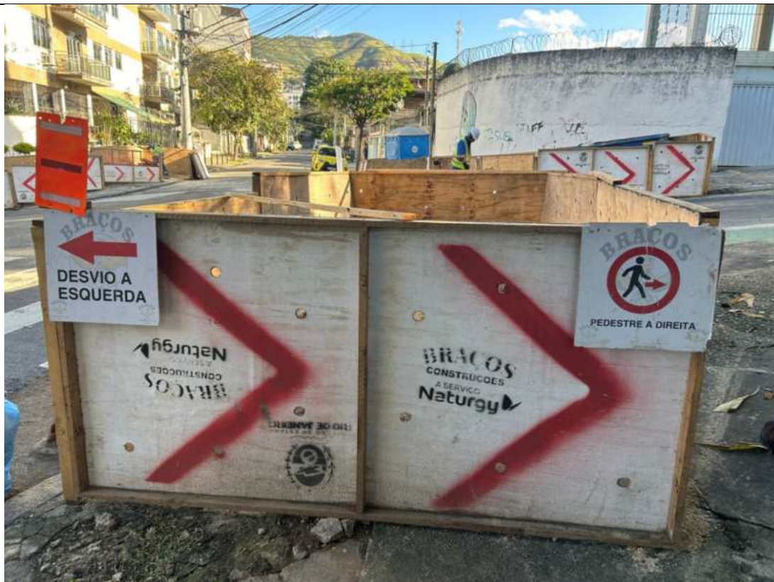
Foto 3: Obra de ligação de rede com isolamento e sinalizações.
