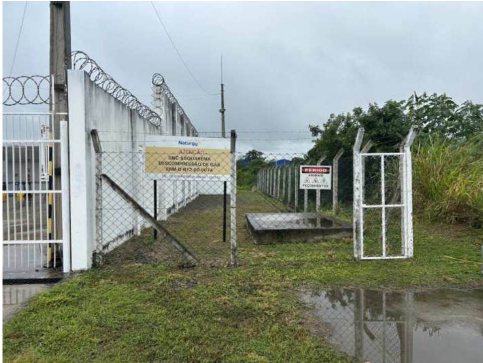
Foto 1: Placa de identificação da estação.
