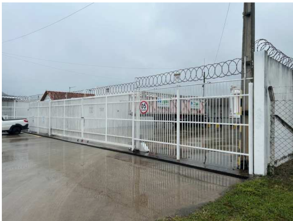
Foto 2: Vista externa da base de descompressão.
