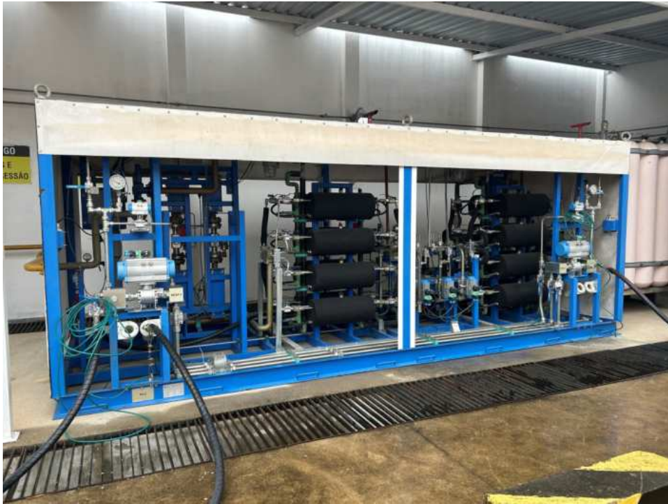
Foto 9: Unidade de Controle e Redução (RCU).
