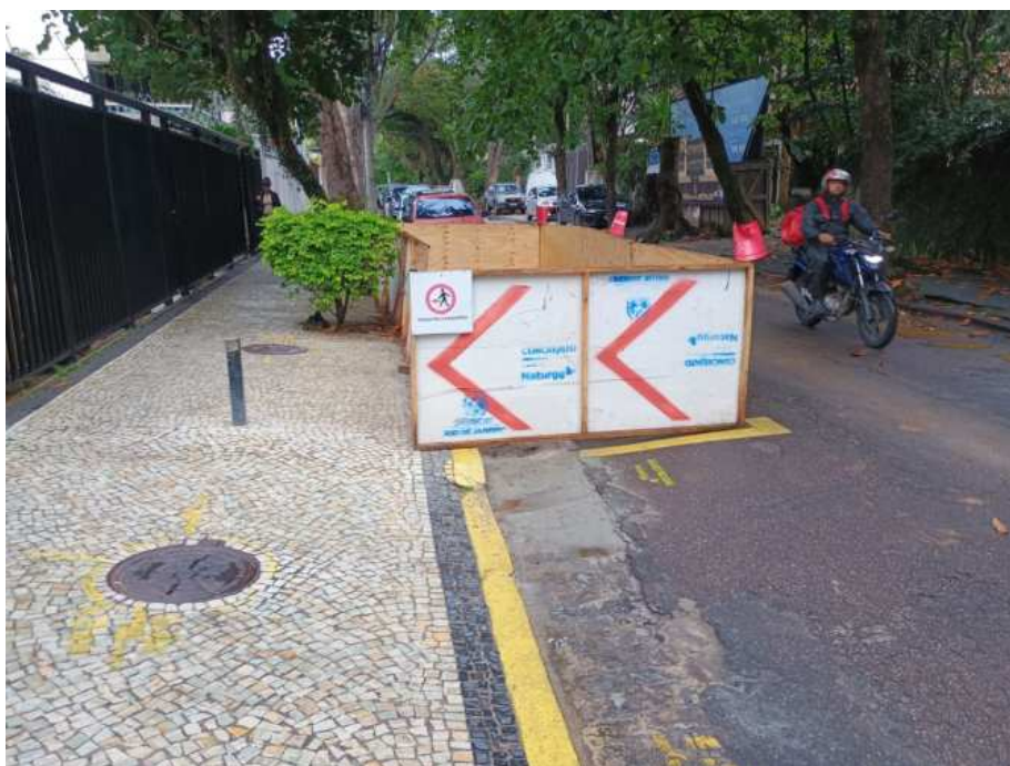
Foto 6: trecho de tubulação assentada na Rua Coronel João Olintho.
