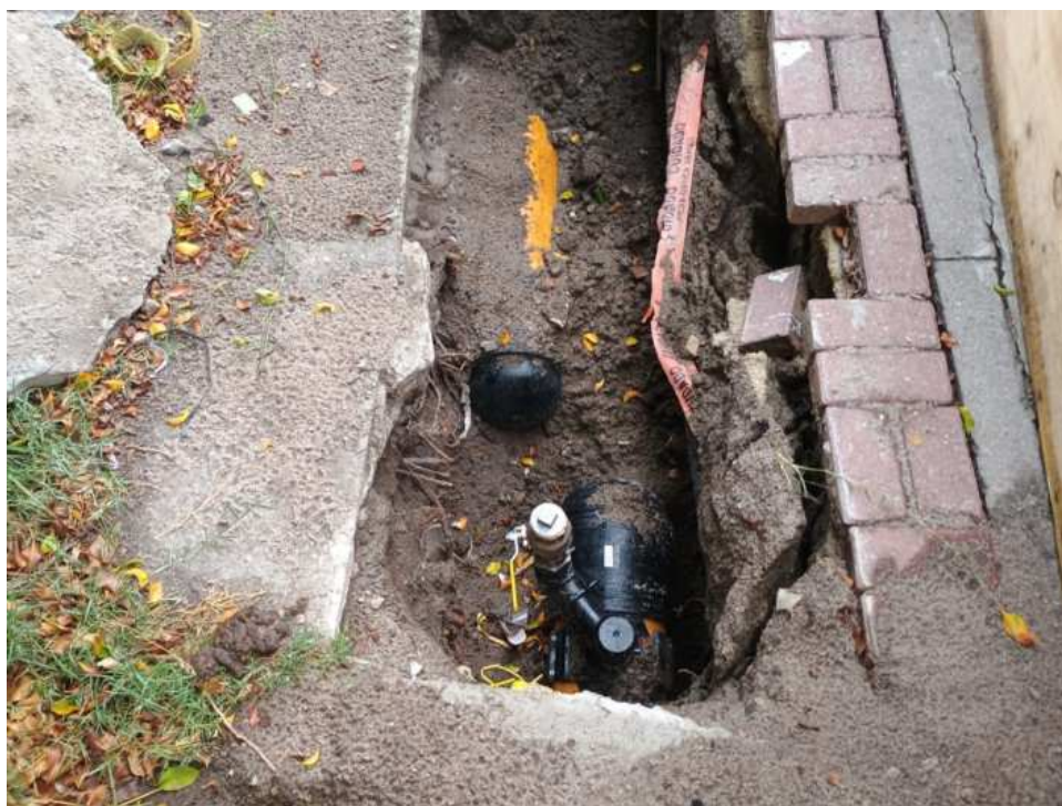
Foto 2: tubulação de polietileno com Ø250 mm.
