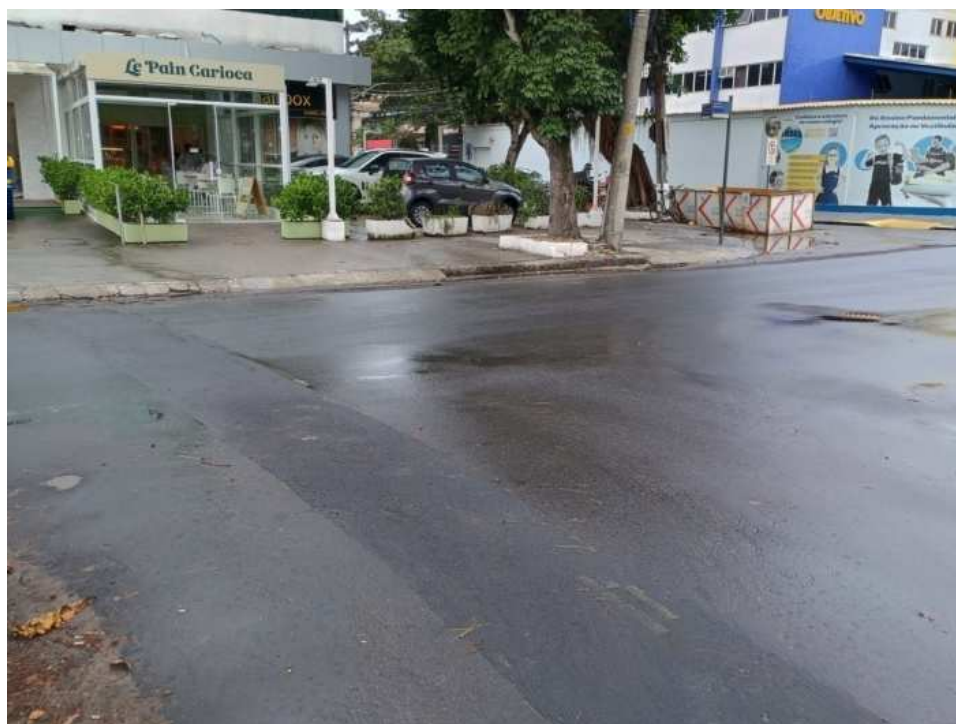
Foto 8: trecho de recomposição provisória.
