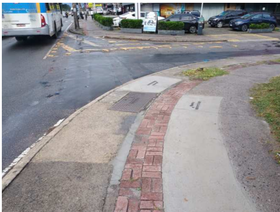
Foto 3: início da fase 4, na Avenida das Américas, na altura da Rua Ismael Silva.
