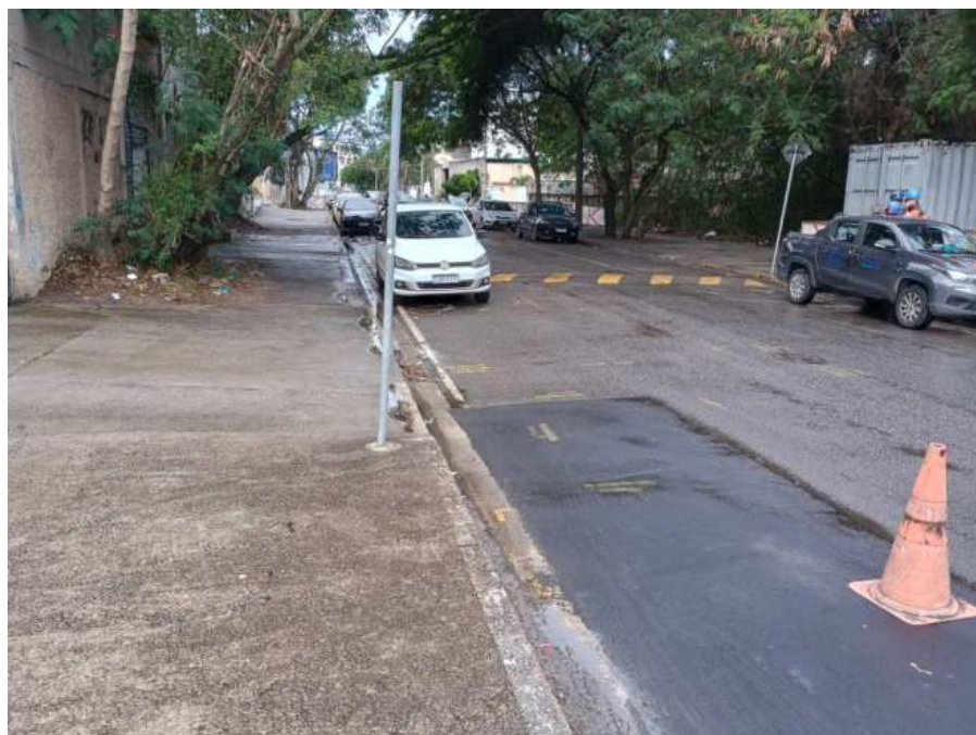
Foto 5: trecho de tubulação assentada na Rua Nelson Tarquínio.
