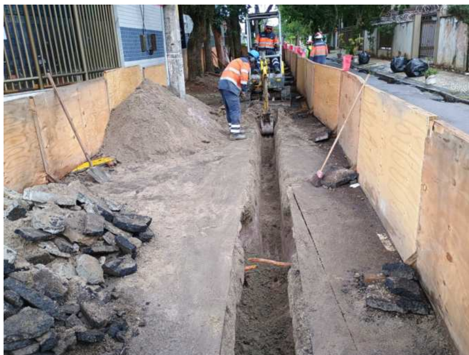
Foto 7: trecho na Rua Coronel João Olintho, entre o número 611 e a Rua Crispim Laranjeira, que receberá a tubulação.
