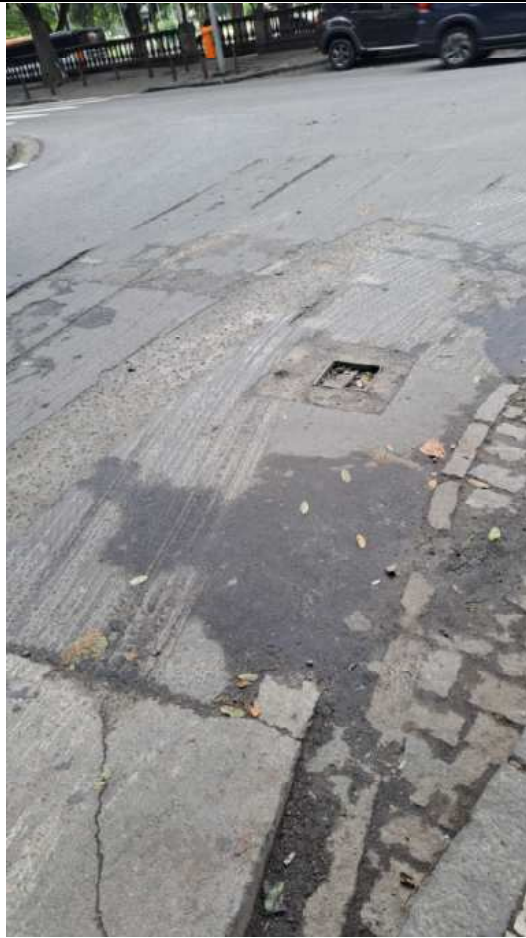
Foto 8: Futuro ponto de interligação da rede nova. Esquina Rua da Glória e Cândido Mendes
