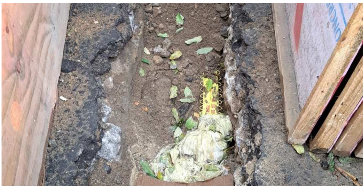
Foto 2: Início de recomposição do último trecho. Detalhe da fita de segurança posicionada sobre a tubulação
