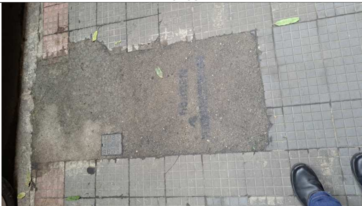
Foto 7: Recomposição provisória de ramal
