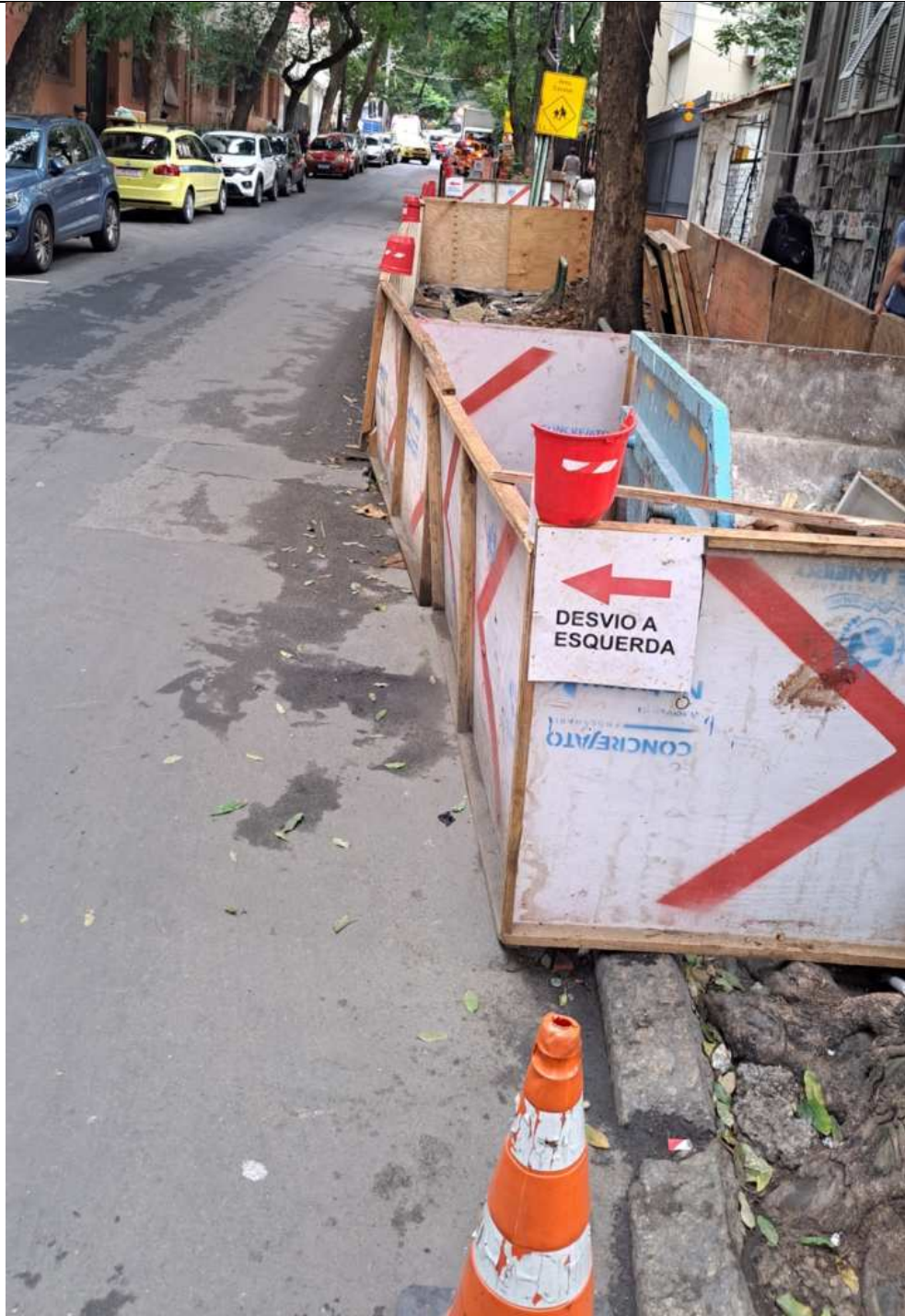
Foto 5: Sinalização para desvio de tráfego e noturna
