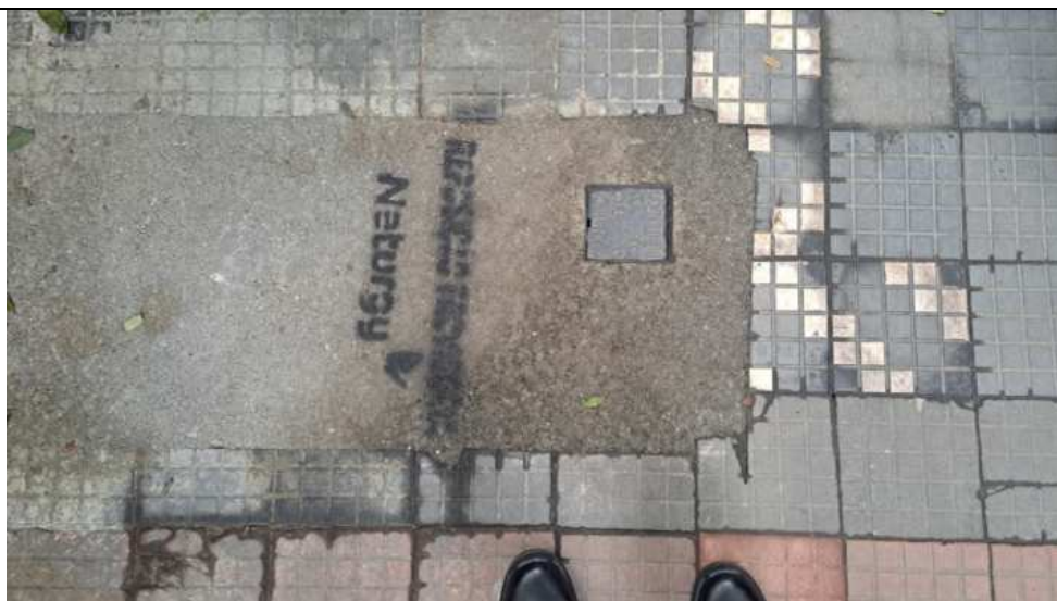
Foto 6: Recomposição provisória de ramal
