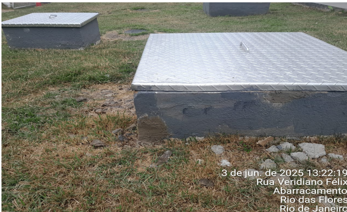
Foto 13: Reparo na alvenaria da caixa de passagem.
