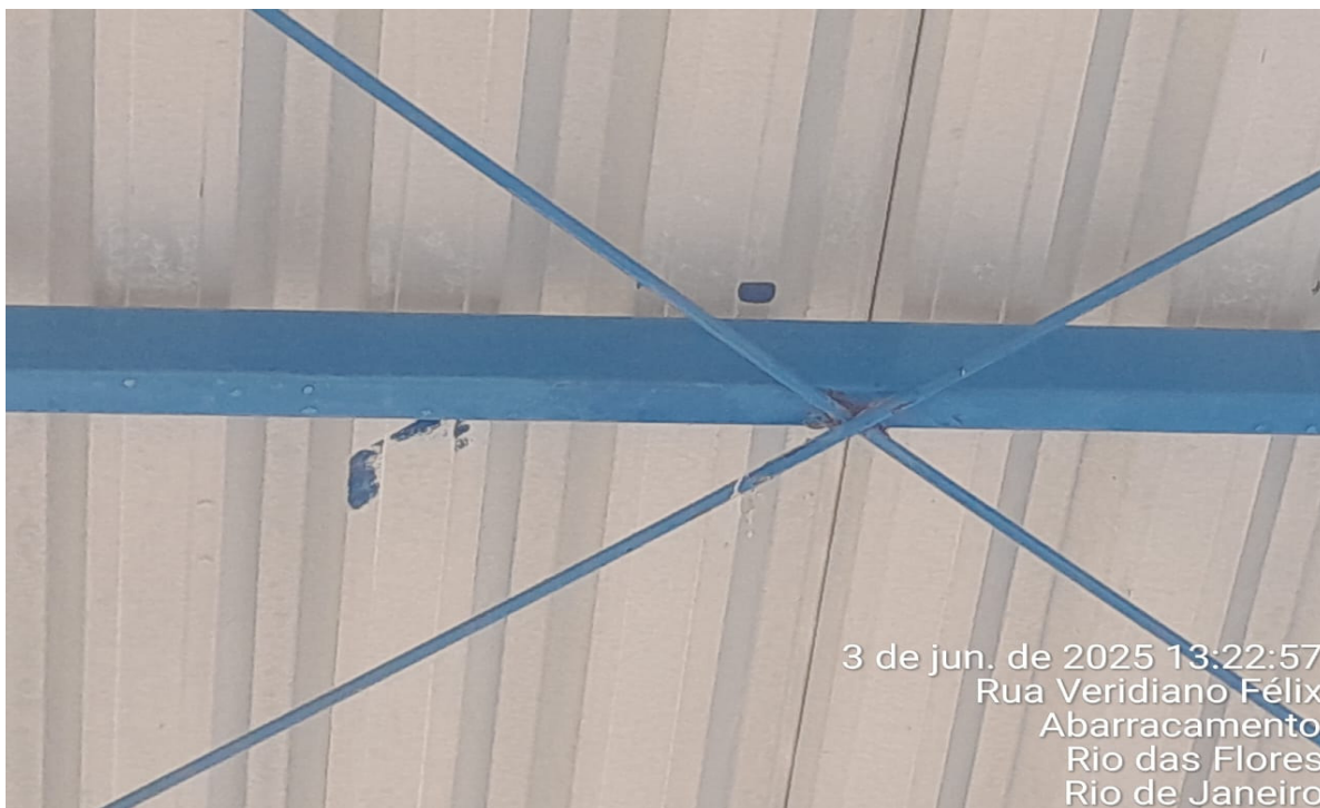
Foto 18: Telhado após a limpeza da casa de marimbondo.
